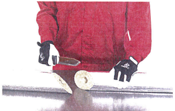
Rozcięcie otuliny pod kątem 45° na dwa elementy.
