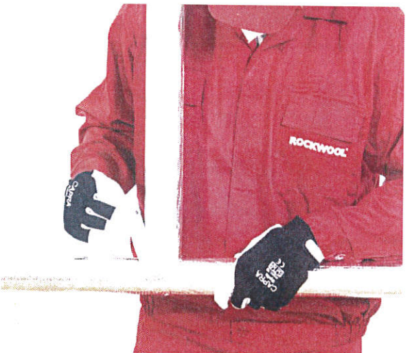
Sklejenie styków izolacji taśmą aluminiową.
