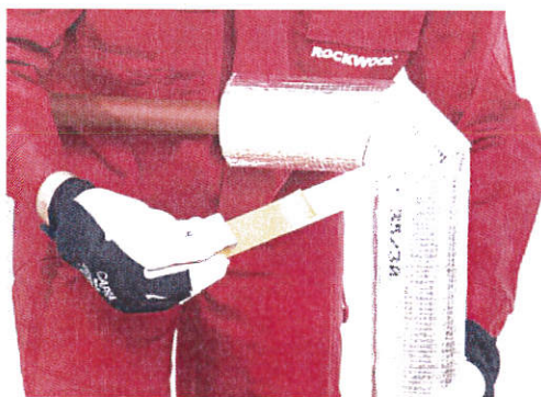
Sklejenie połączeń poprzecznych taśmą aluminiową.
