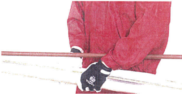
Nałożenie otuliny na odcinek prosty rurociągu.
