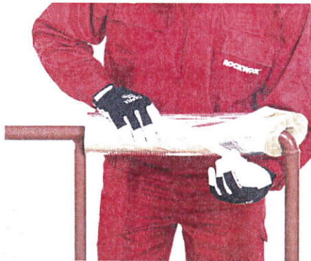
Sklejenie połączenia wzdłużnego zakładką samoprzylepną.
