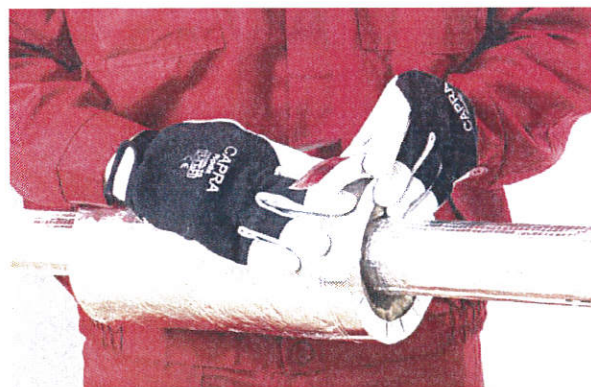
Zabezpieczenie zakończenia izolacji mankietem aluminiowym.
