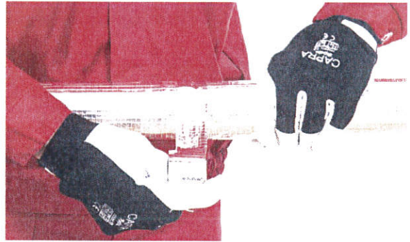
Zabezpieczenie połączenia poprzecznego otulin samoprzylepną taśmą aluminiową.
