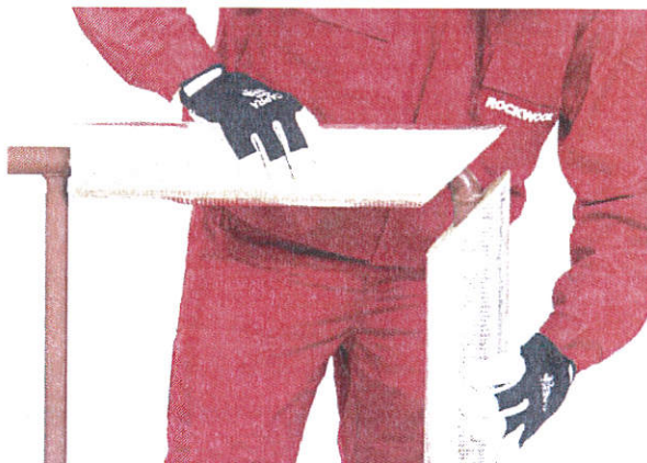
Dopasowanie obu elementów izolacji kolana.
