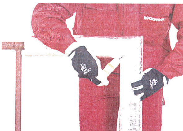
Zabezpieczenie połączenia poprzecznego otulin samoprzylepną taśmą aluminiową.
