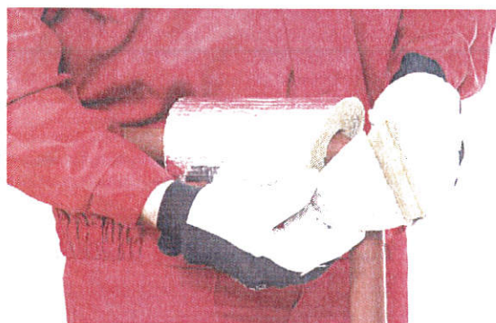
Montaż jednego segmentu kolanowego.
