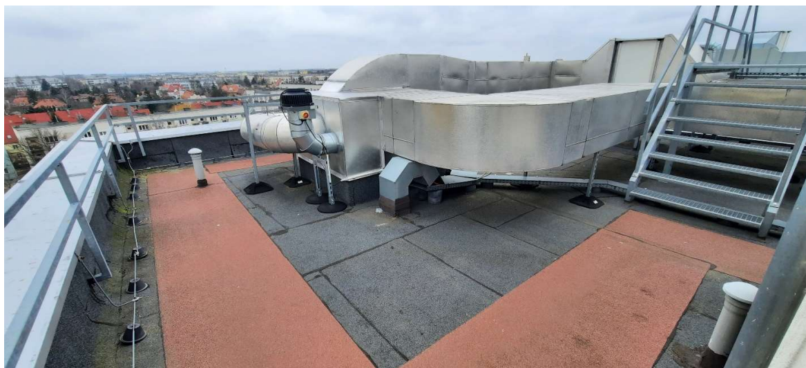
Fotografia dachu – przepust kablowy i proponowana lokalizacja rozdzielnicy RKLIM.
