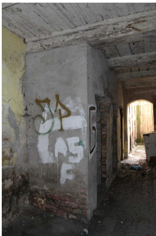
Fot. 17. Parter budynku przy ul. Spichrzowej 30 w Grudziądzu (fot. Karolina Witkowska)
