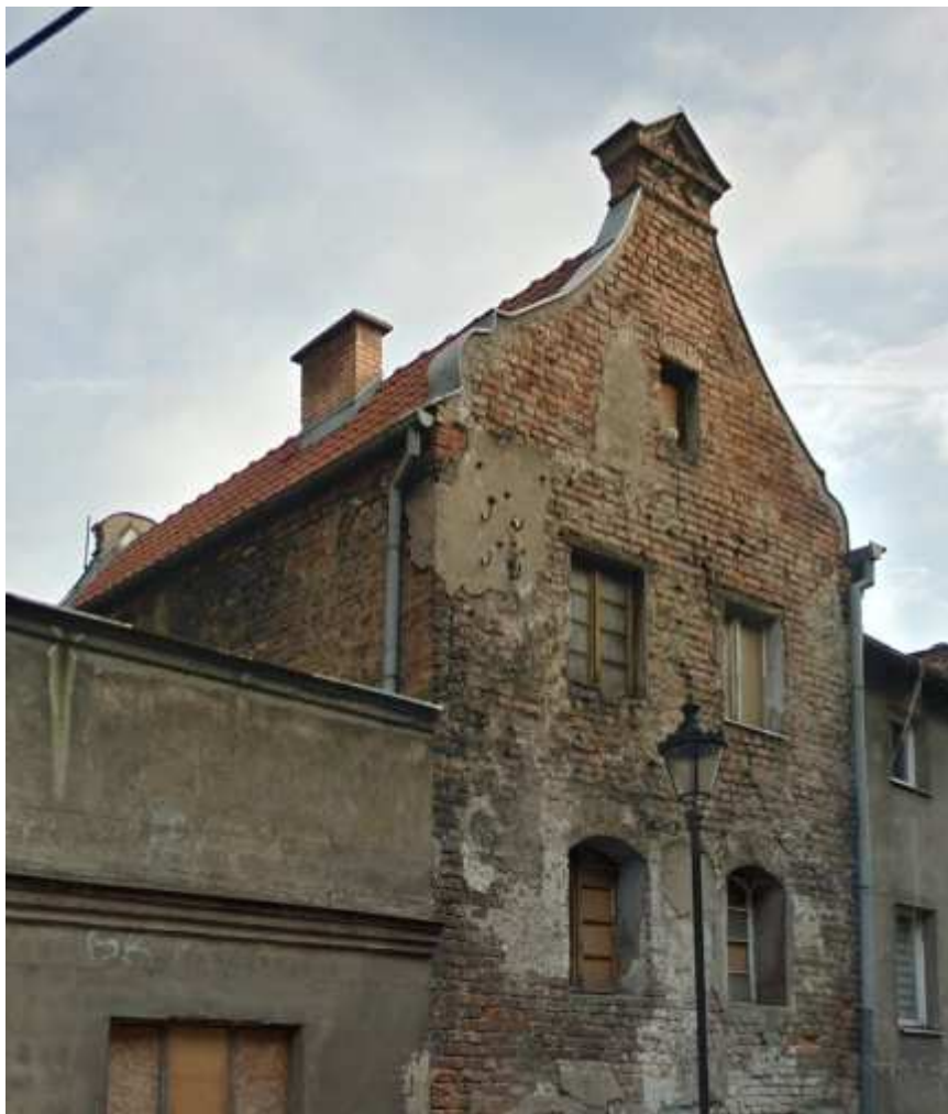
Fot. 2. Elewacja zachodnia i północna budynku przy ul. Spichrzowej 30 w Grudziądzu (fot. Anna Zaręba).
