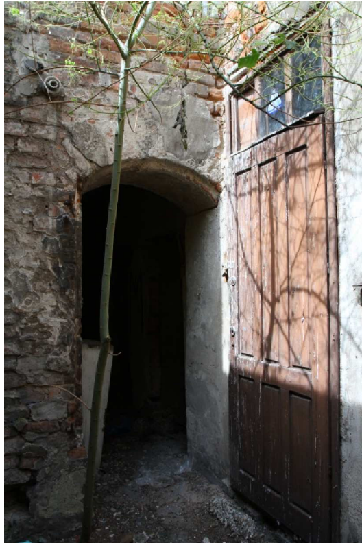
Fot. 23. Drzwi od podwórza w budynku przy ul. Spichrzowej 30 w Grudziądzu (fot. Karolina Witkowska)
