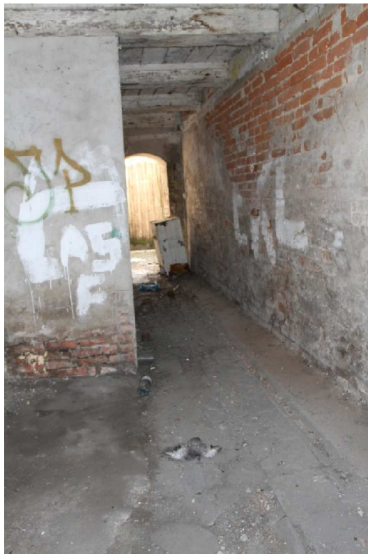
Fot. 16. Parter budynku przy ul. Spichrzowej 30 w Grudziądzu (fot. Karolina Witkowska)
