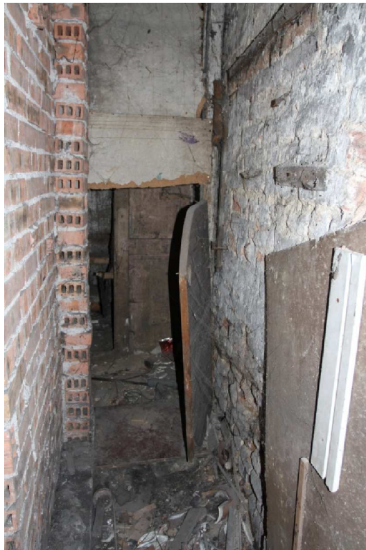
Fot. 19. Wtórne ścianki z cegły dziurawki, drzwi do schowka pod schodami, budynek przy ul. Spichrzowej 30 w Grudziądzu (fot. Karolina Witkowska)
