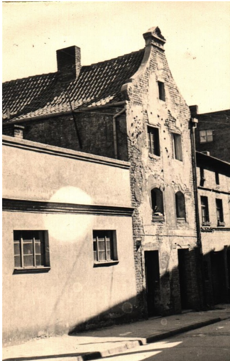
Fot. 30. Lata 60, budynek przy ul. Spichrzowej 30 w Grudziądzu, widoczny zarys woluty u spływu szczytu i opaski pozorne we wtórnych tynkach, źródło: Karta ewidencji zabytku z 1966 roku.
