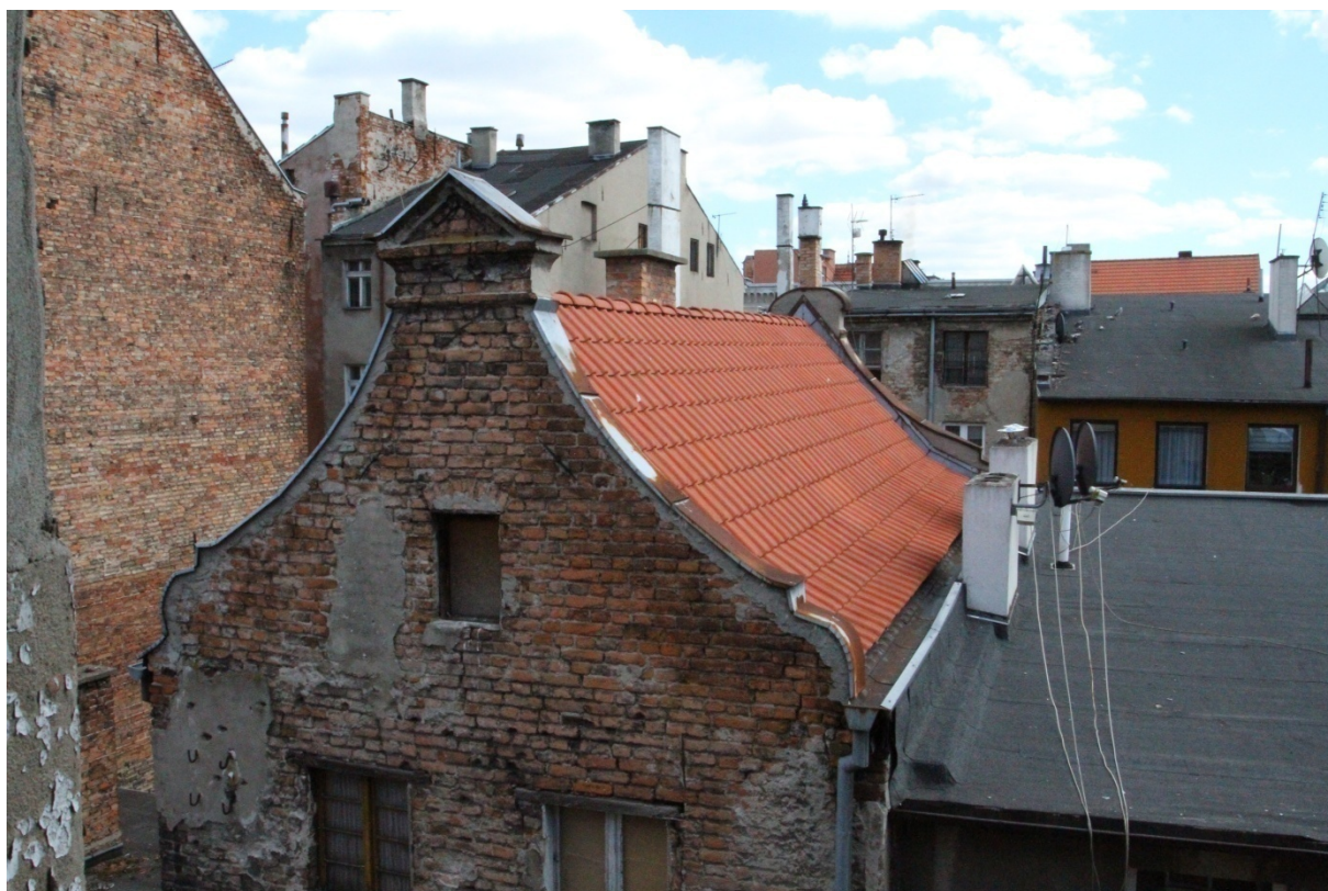
Fot. 3. Dach budynku przy ul. Spichrzowej 30 w Grudziądzu (fot. Karolina Witkowska).
