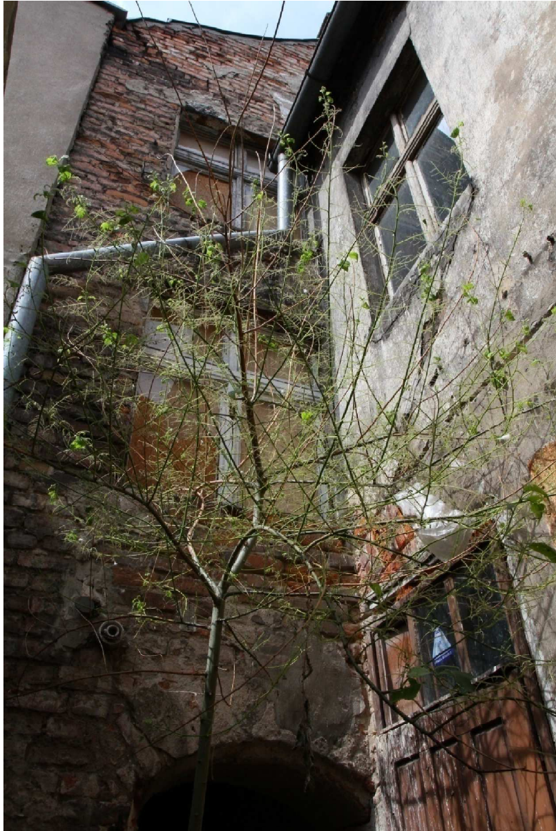
Fot. 6. Elewacja wschodnia i fragment oficyny budynku przy ul. Spichrzowej 30 w Grudziądzu (fot. Karolina Witkowska).
