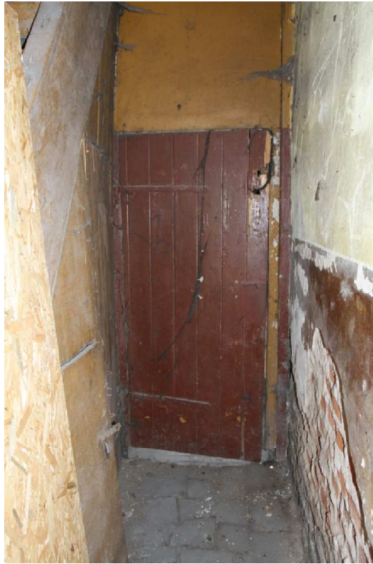
Fot. 15. Parter budynku przy ul. Spichrzowej 30 w Grudziądzu, wejście do toalety (fot. Karolina Witkowska)
