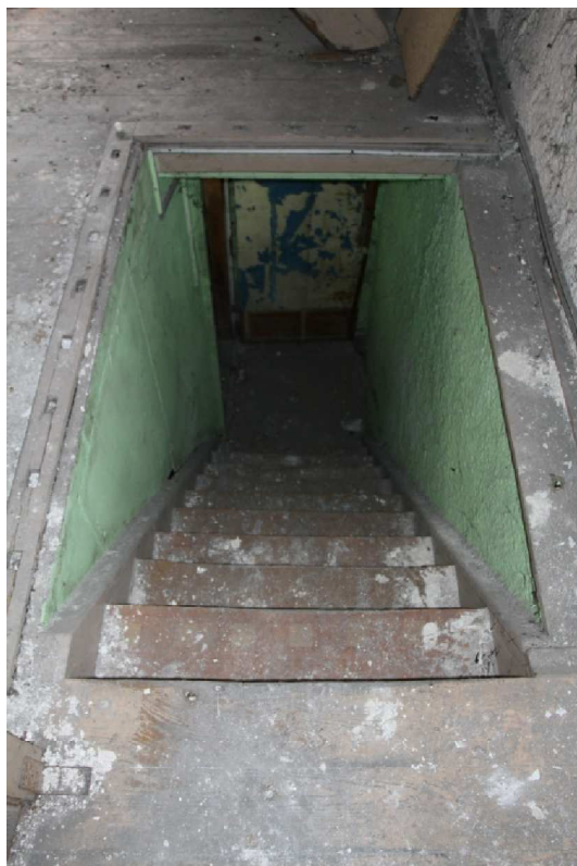
Fot. 10. Schody między II i I piętrem budynku przy ul. Spichrzowej 30 w Grudziądzu (fot. Karolina Witkowska)
