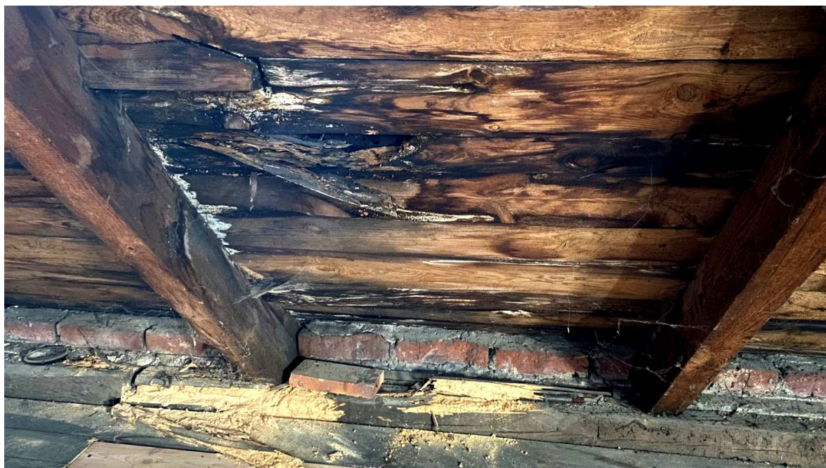
Fot. B. Elewacja szczytowa – okienka strychowe do wymiany
