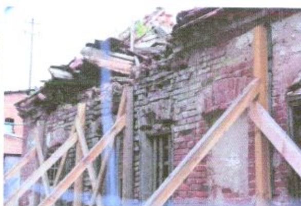
Fot. 17-18. Widoczny katastrofalny stan spichrza. Więźba dachowa wpadła do wnętrza poddasza. Został uszkodzony gzyms. Widać liczne pęknięcia i bardzo zły stan cegieł i spoiny. Tynk na elewacji zachował się tylko szczątkowo.
