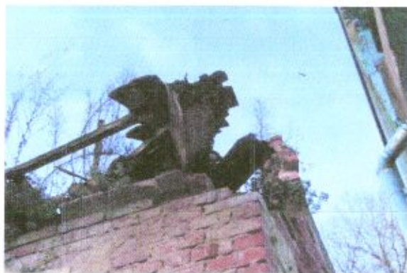
Fot. 8-9. Widoczne belki oraz dachówki, które uległy destrukcji. Belki w bardzo złym stanie, spróchniałe i zbutwiałe, dachówki są popekane.
