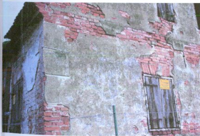
Fot. 67- 68. Szczątkowe pozostałości pasa między kondygnacjami elewacji w 2021 r.
