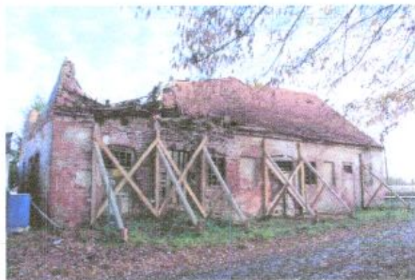
Fot. 62-63. Elewacja północna - analogiczna do elewacji południowej, 3-osiowa. Pomiędzy kondygnacjami pas z tynku. Blenda pomiędzy otworami okiennymi. W narożnikach murów widoczne boniowania.
