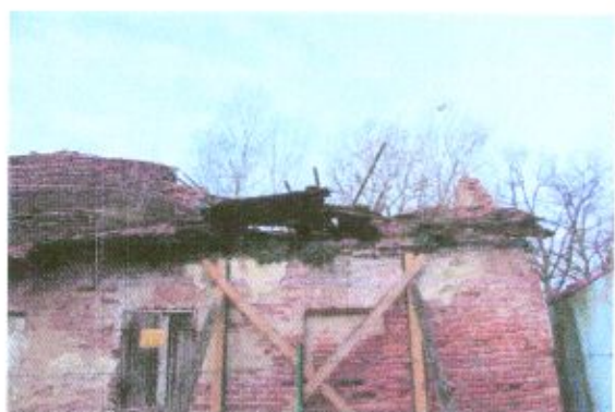
Fot. 6-7. Dach od strony północnej zawalił się. Belki więźby dachodwój, krokwie orzez część kalnicy wpadła do wnętrza spichrza.
