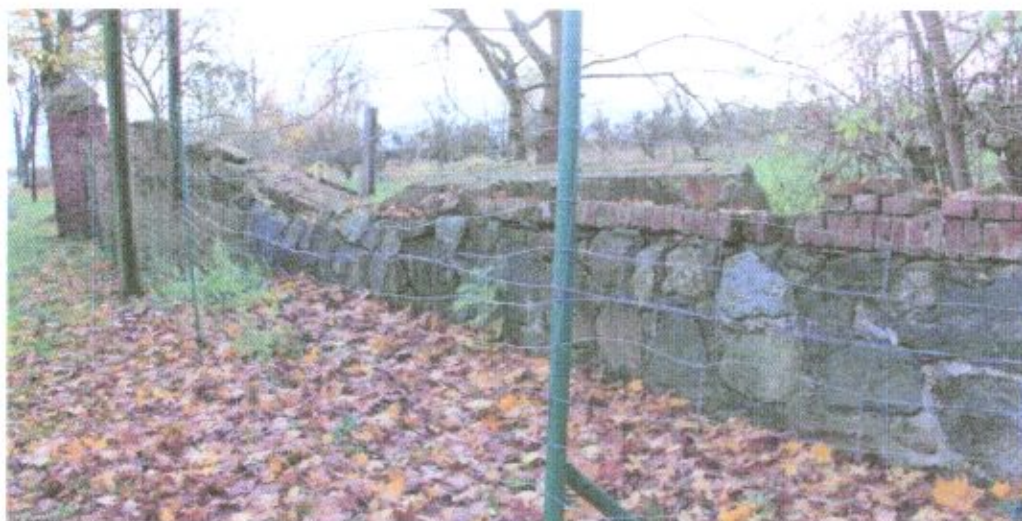
Fot. 51. Zachowana oryginalna część muru ceglanego wraz ze słupkiem bramy. Uzupełnienia spoiną cementową są wtórne jak i założone na zaprawę cementową dachówki.
