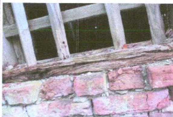
Fot. 21-22. Okna drewniane i drzwi od strony elewacji zachodniej są w bardzo złym stanie. Drewno jest spróchniałe i przegniłe.
