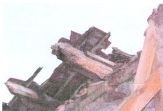
Fot. 8-9. Widoczne belki oraz dachówki, które uległy destrukcji. Belki w bardzo złym stanie, spróchniałe i zbutwiałe, dachówki są popekane.
