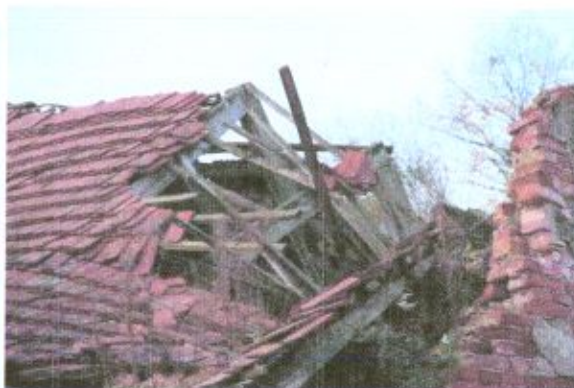
Fot. 6-7. Dach od strony północnej zawalił się. Belki więźby dachodwój, krokwie orzez część kalnicy wpadła do wnętrza spichrza.
