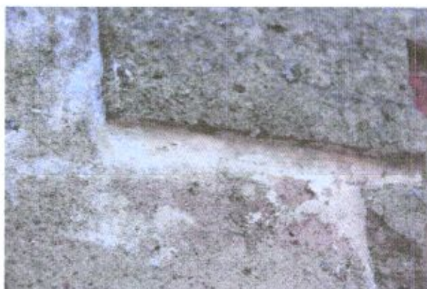
Fot. 40-41. Na elewacji północnej zachowały się pozostałości boniowania na narożniku ściany.
