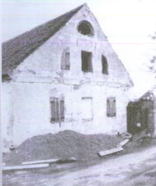
Fot. 60-61. Elewacja południowa: 3-osiowa. Pomiędzy kondygnacjami pas z tynku. Blenda pomiędzy otworami okiennymi. W narożnikach murów widoczne boniowania.
