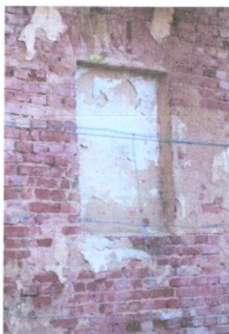
Fot. 13-14. Blendy pierwotnie były oktynkowane, zachowały się w nich tynki.
