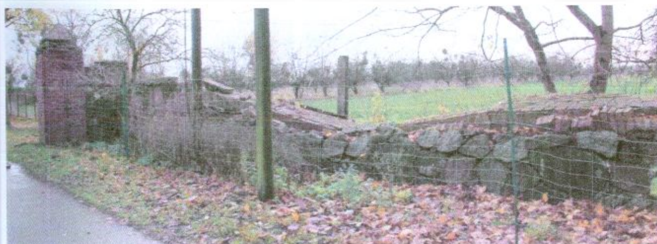
Fot. 53. Stan zachowania słupka i muru pierwotnego w 2021 r.
