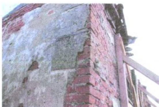
Fot. 40-41. Na elewacji północnej zachowały się pozostałości boniowania na narożniku ściany.
