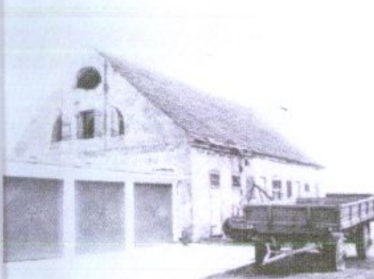
Fot. 62-63. Elewacja północna - analogiczna do elewacji południowej, 3-osiowa. Pomiędzy kondygnacjami pas z tynku. Blenda pomiędzy otworami okiennymi. W narożnikach murów widoczne boniowania.
