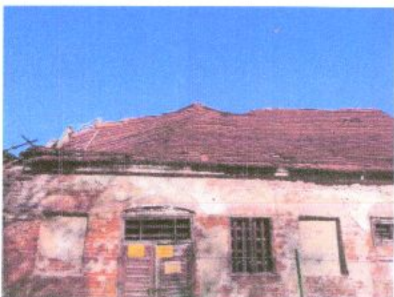
Fot. 19-20. Konstrukcja więźby dachowej uległa destrukcji. Widoczne są liczne ubytki w dachówce „karpówce”. Więźba nie spełnia swojej funkcji. Dach grozi kolejnym zawaleniem.
