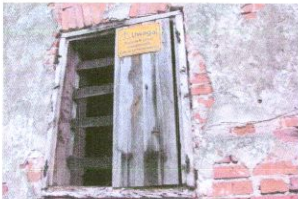
Fot. 35-36. W dolnej kondygnacji elewacji południowej znajdują się dwa otwory okienne zamknięte okiennicami, a po środku nich umieszczona jest blenda.
