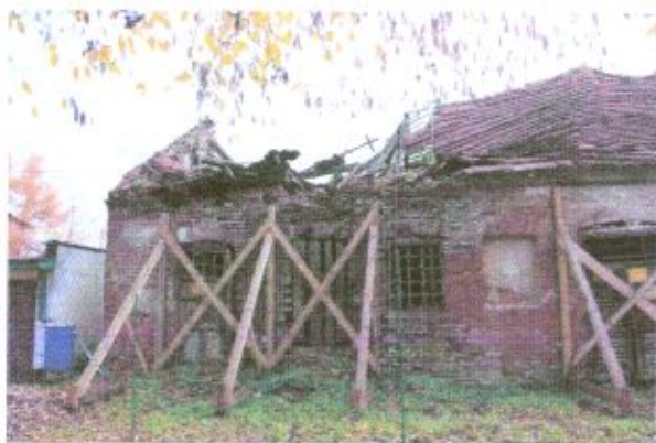
Fot. 17-18. Widoczny katastrofalny stan spichrza. Więźba dachowa wpadła do wnętrza poddasza. Został uszkodzony gzyms. Widać liczne pęknięcia i bardzo zły stan cegieł i spoiny. Tynk na elewacji zachował się tylko szczątkowo.
