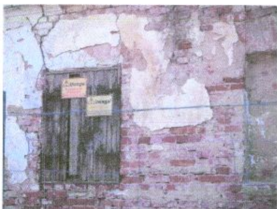
Fot. 11-12. W elewacji wschodniej zachowały się otwory okienne nieoszkłone, zamknięte 2-skrzydłowymi deskowymi okiennicami na zawiasach pasowych, o łąkach prostych, pełnych lub półkolistych. Badrzo zły stan drewna okiennic, produkty korozji na zawiasach.
