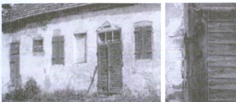
Fot. 16. Zdjęcie obrazujące oryginalne drzwi spichrza oraz okucia drzwi głównych.
