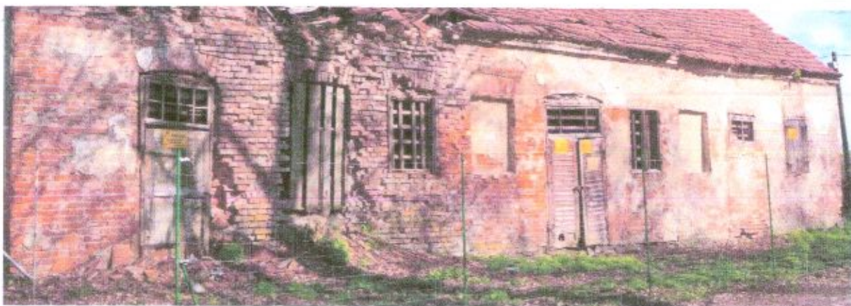
Fot. 23. Widoczne otwory okienne z okiennicami oraz dwa otwory drzwiowe, jak również blendy.
