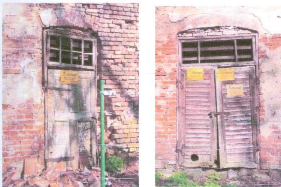
Fot. 17. Obecnie skrzydła drzwi po lewej stronie są wtórne. Po prawej stronie zachowały się oryginalne drzwi z żaluzjowym opierzeniem płycin oraz okuciami.
