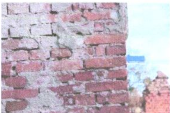
Próbka nr. 5. Zaprawa pobrana ze spoiny
