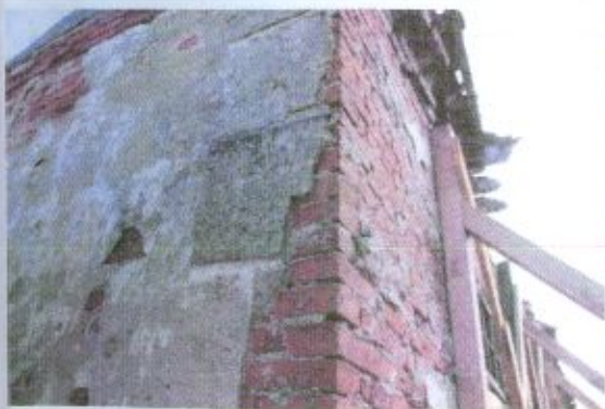
Fot. 64-66. Szczątkowe pozostałości boniowań na narożnikach ścian elewacji spichrza w 2021 r.
