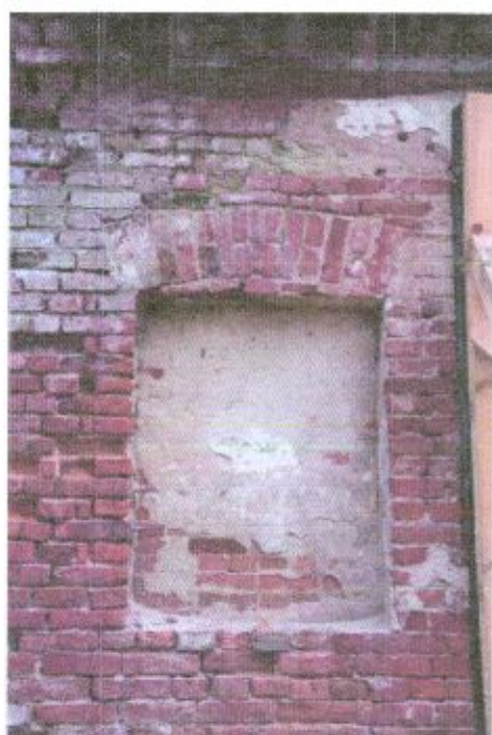
Fot. 13-14. Blendy pierwotnie były oktynkowane, zachowały się w nich tynki.
