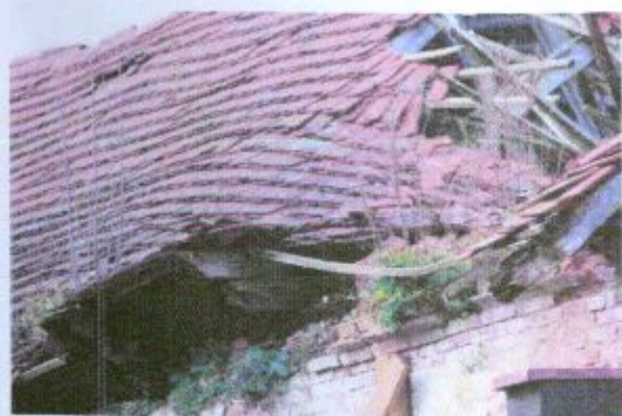
Fot. 45-49. Stan zachowania dachu spichrza w 2021 r.
