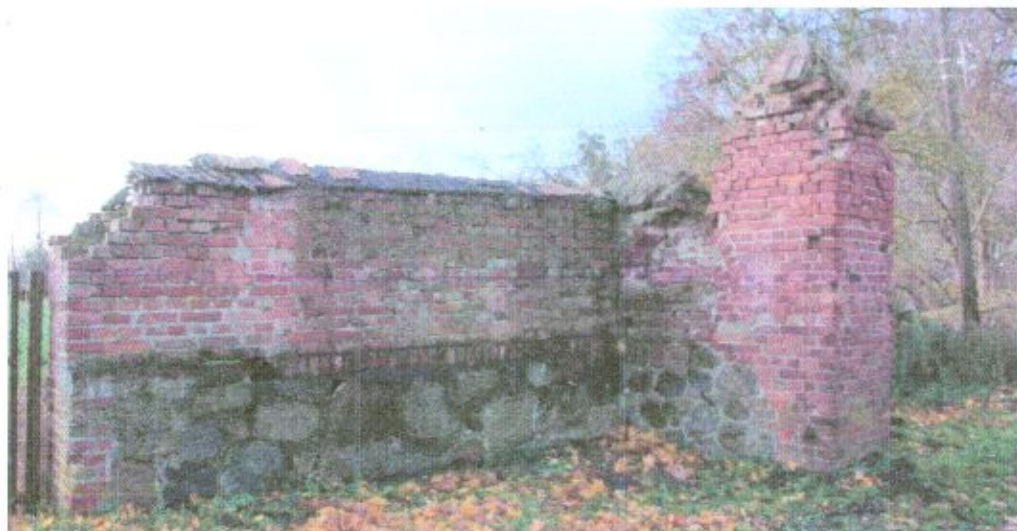
Fot. 51. Zachowana oryginalna część muru ceglanego wraz ze słupkiem bramy. Uzupełnienia spoiną cementową są wtórne jak i założone na zaprawę cementową dachówki.
