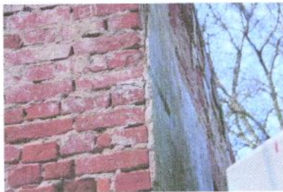
Fot. 64-66. Szczątkowe pozostałości boniowań na narożnikach ścian elewacji spichrza w 2021 r.
