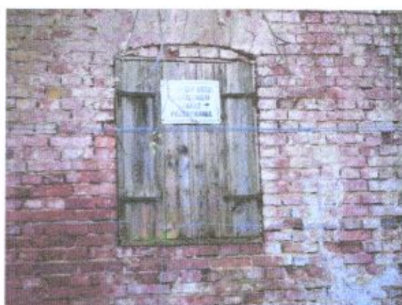
Fot. 11-12. W elewacji wschodniej zachowały się otwory okienne nieoszkłone, zamknięte 2-skrzydłowymi deskowymi okiennicami na zawiasach pasowych, o łąkach prostych, pełnych lub półkolistych. Badrzo zły stan drewna okiennic, produkty korozji na zawiasach.
