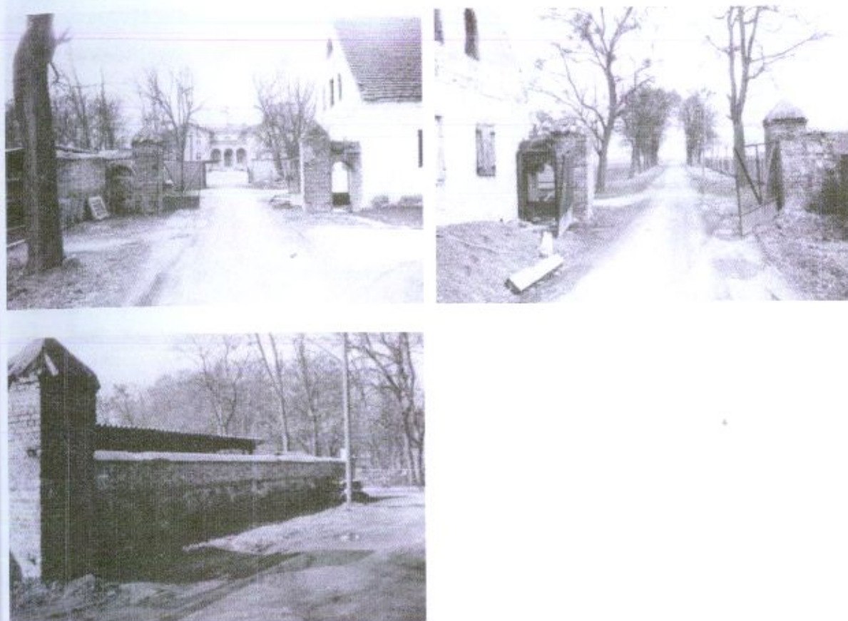
Fot. 50-52. Widoczne na starych fotografiach oryginalne słupki oraz mur, który został poddany pracom naprawczym. Metalowa brama oraz furtka od wewnętrznej strony podwórza są wtórne.
