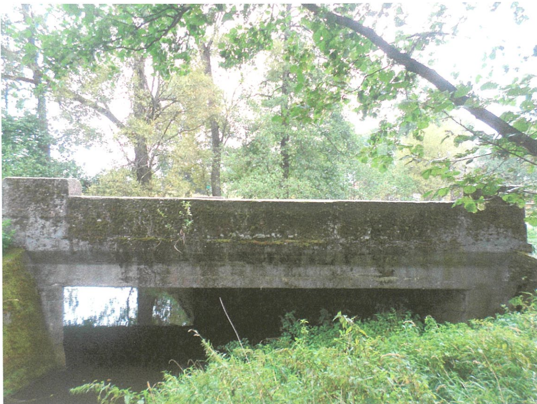
Fot. 2. Widok obiektu od strony dolnej wody.
