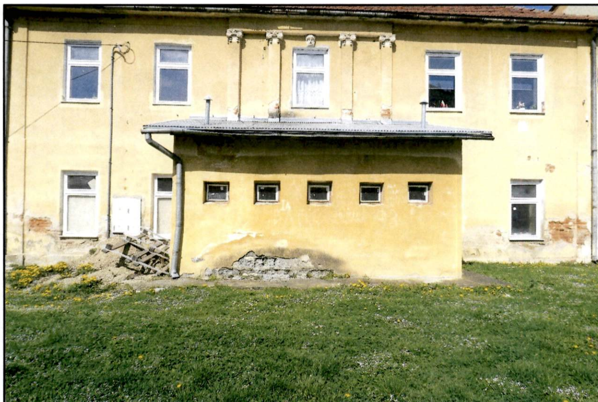
5. Budynek dawnego dworu, elewacja wschodnia, dawniej frontowa, widoczny współczesny węzeł sanitarny. Fot. B. Potera, 2024 r.
