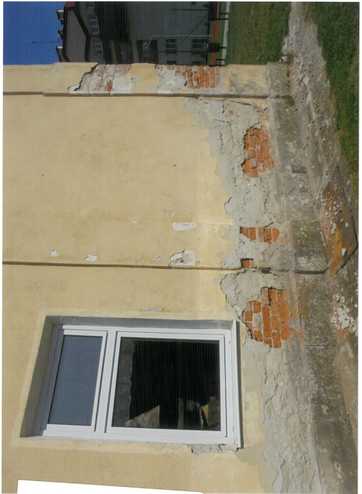
Fot. Nr 2 Huwniki - dawna szkoła, dawny dworek Stan zniszczeń murów i tynków (zawilgocenie i zasolenie).
