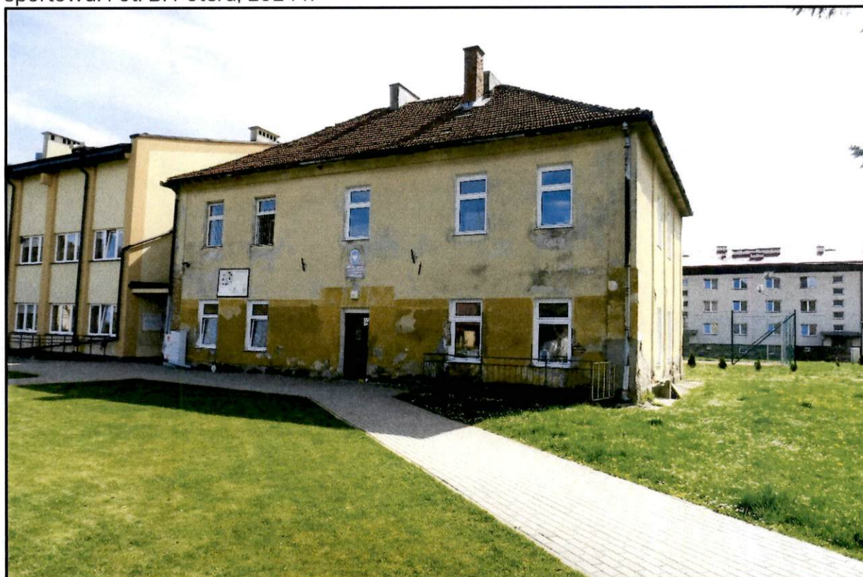
2. Budynek dawnego dworu, ob. elewacja frontowa (zach.) Fot. B. Potera, 2024 r.
