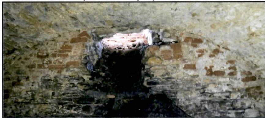
20. Pomieszczenie w pd.-wsch. części piwnic, wtórny zsyp. Fot. B. Potera, 2024 r.
