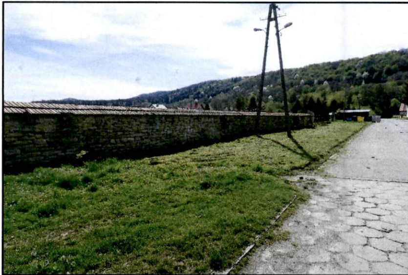
40. Mur ogrodzeniowy po pd. stronie drogi folwarcznej. Fot. B. Potera, 2024.
