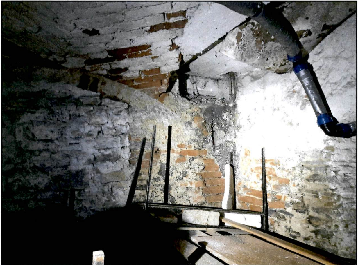
22. Zachodnia część środkowego traktu piwnic, widoczne liczne ingerencje z różnych okresów. Fot. B. potera, 2024 r.
