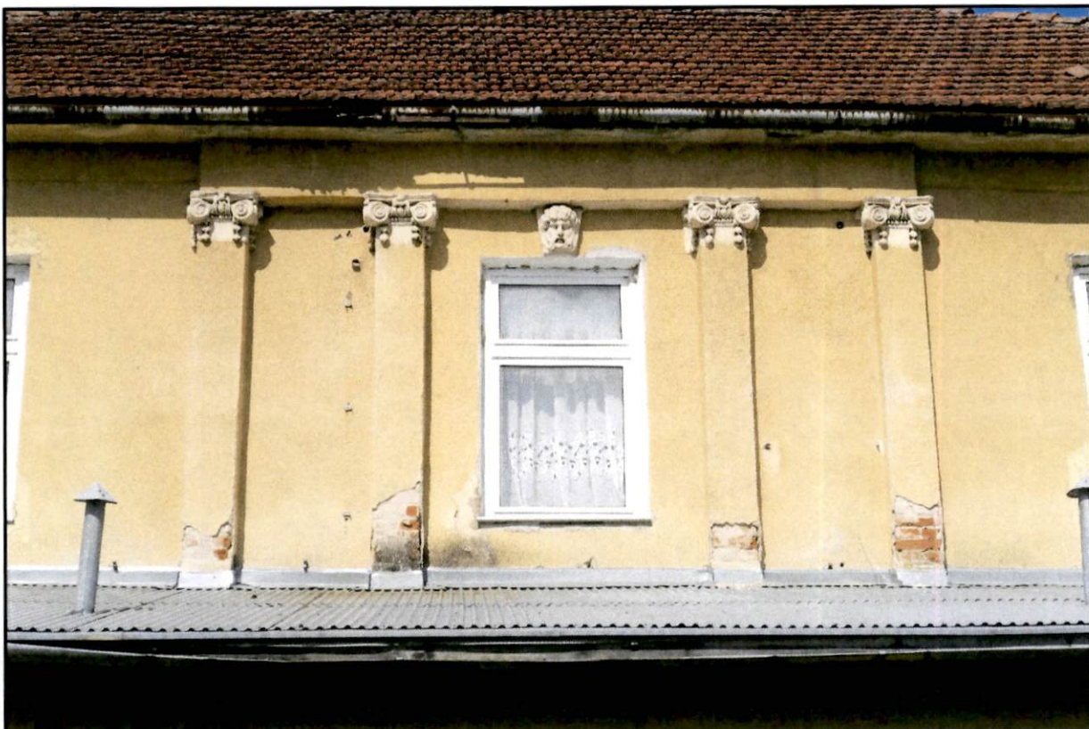
11. Elementy dekoracji elewacji wschodniej: główce pilastrów oraz klucz, w kondygnacji piętra. Fot. B. Potera, 2024 r.
