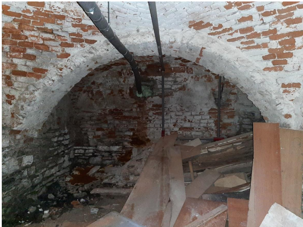
Widok ścian wewnętrznych i sklepień łukowych w piwnicy
