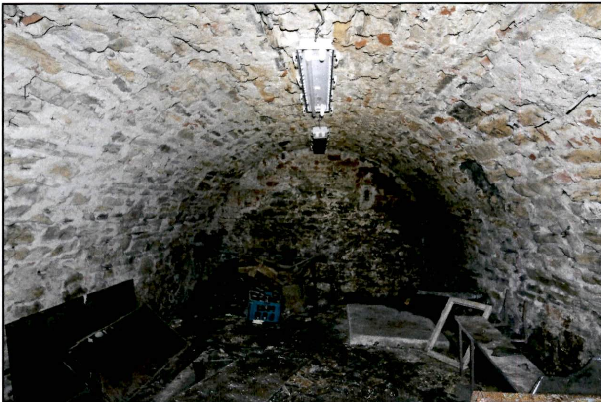
23. Pomieszczenie w pn.-wsch. części piwnic. Fot. J. Dzik, 2024 r.
