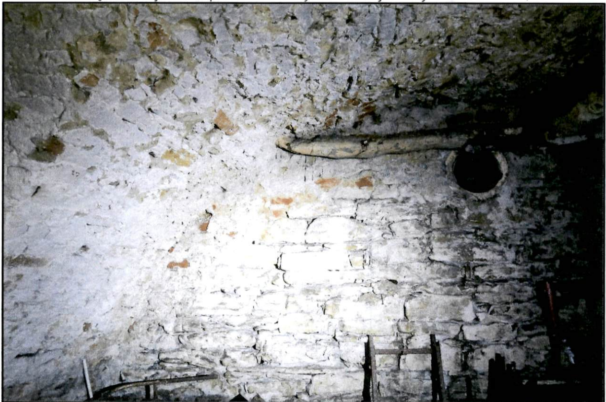
16. Pomieszczenie w pd.-zach. części piwnic. Fot. B. Potera, 2024 r.
