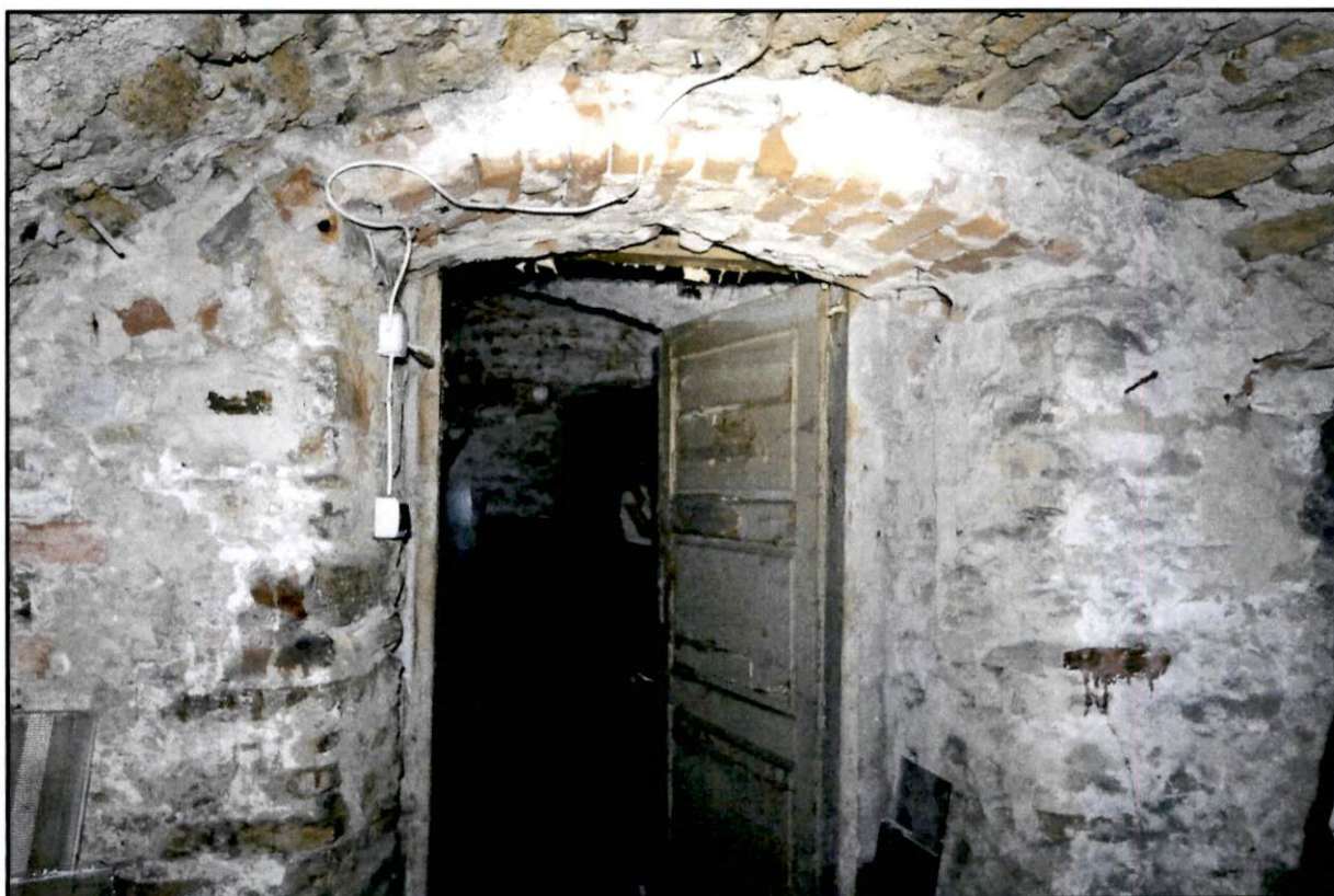
24. Pomieszczenie w pn.-wsch. części piwnic. Fot. J. Dzik, 2024 r.
