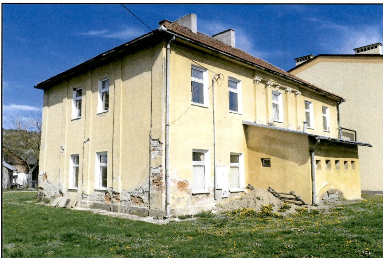
4. Budynek dawnego dworu, od pn.-wsch. Fot. B. Potera, 2024 r.
