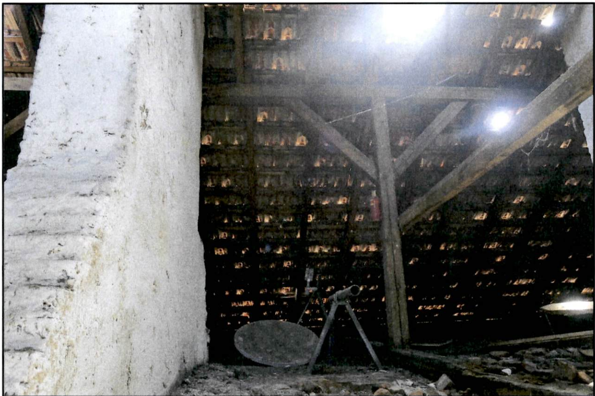
36. Wieżba dachowa, część wsch. fot. B. Potera, 2024 r.
