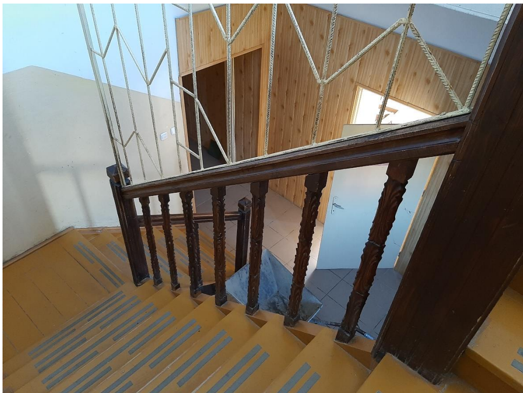
Klatka schodowa (widok na parter)
