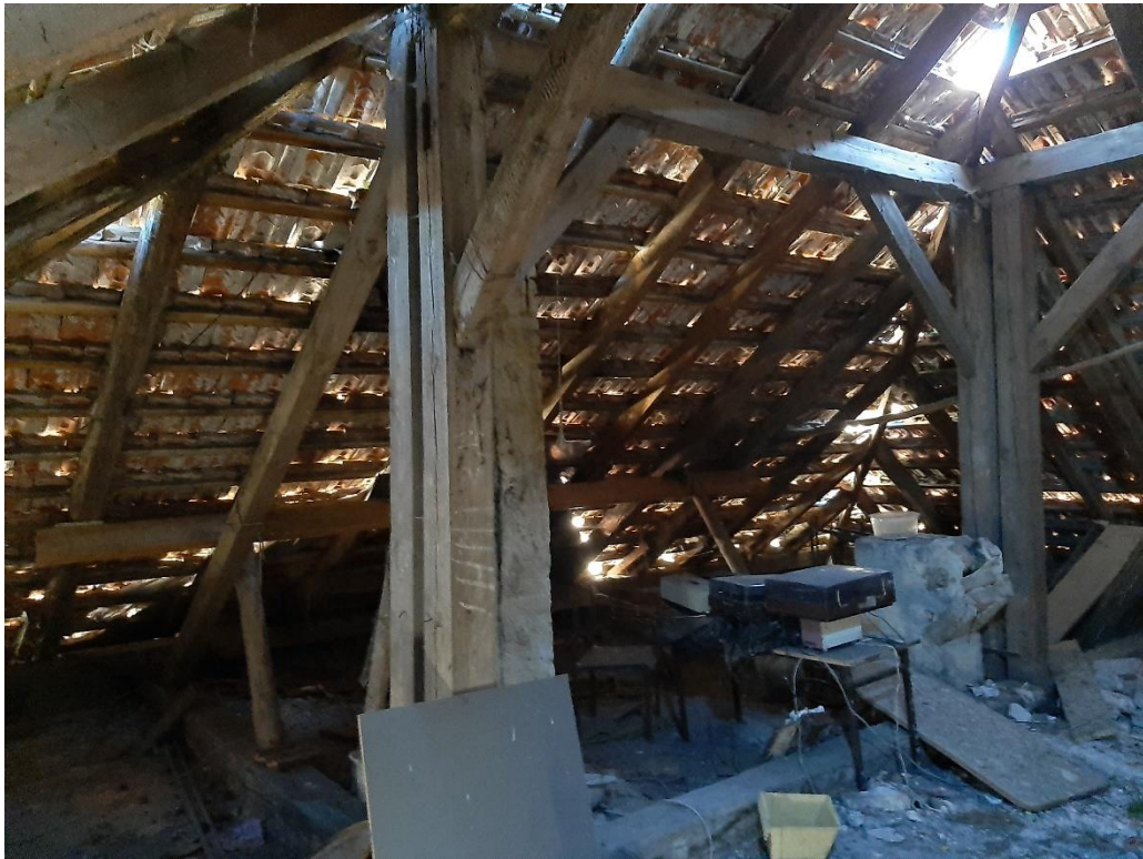
Widok głównej konstrukcji dachu
