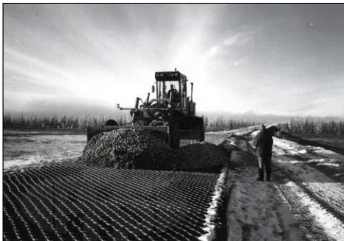
Rys. 8. Zasypywanie kruszywem komórek geosiatki za pomocą ładowarki
