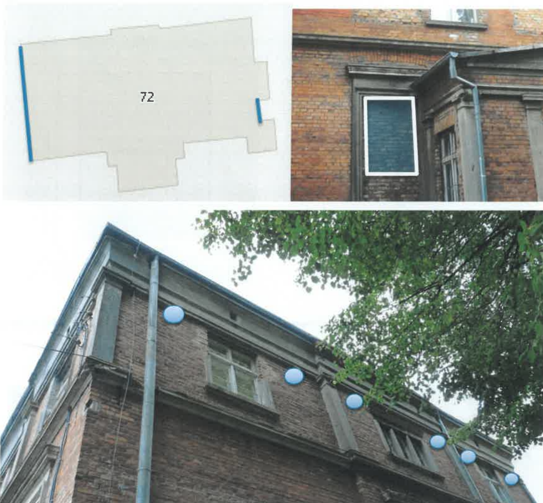
Ryc. 7 – Proponowane miejsce umieszczenia skrzynki podtynkowej dla nietoperzy (prostokąt) oraz skrzynek dla wróbli i jerzyków (koła).
