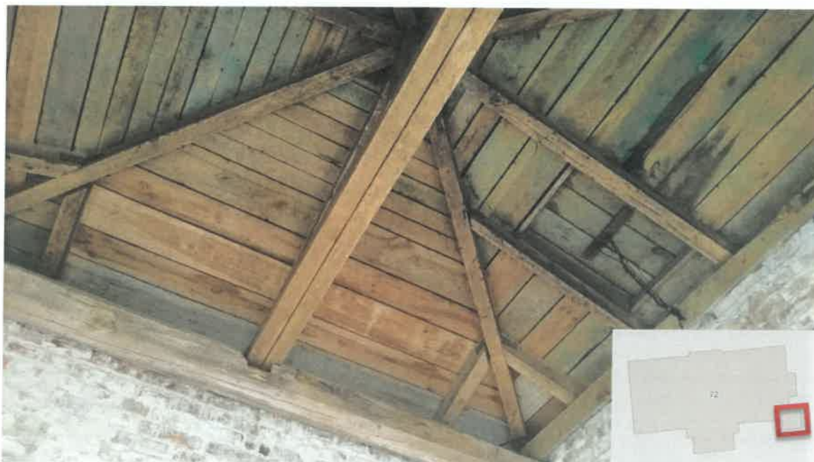
Fot. 19 – Dach wieży. Brak miejsc mogących stanowić potencjalne siedliska nietoperzy.
