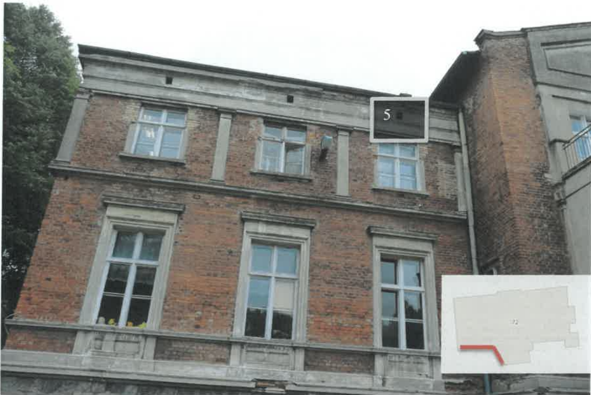
Fot. 4 – Elewacja południowa, widoczne wloty prowadzące na strych.
