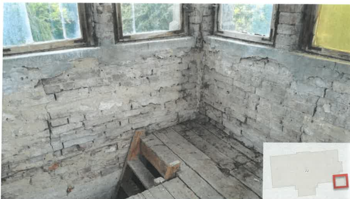
Fot. 18 – Wnętrze wieży.
