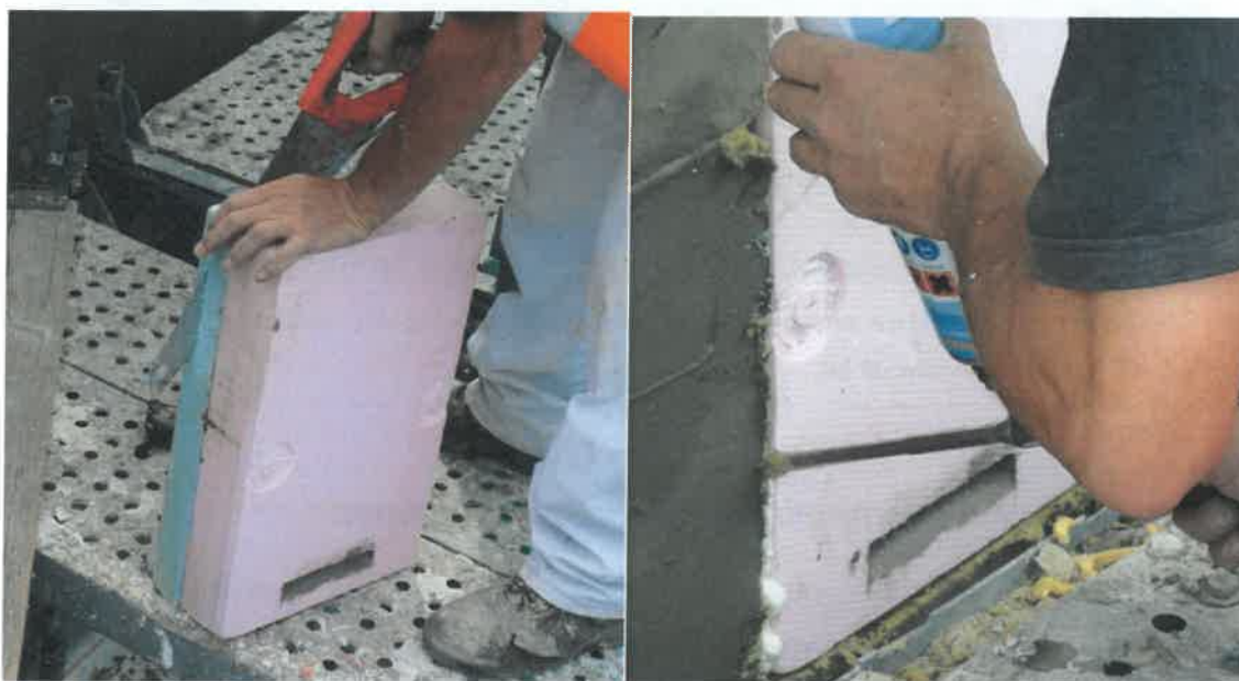
Ryc. 6 – Montaż skrzynki podtynkowej dla nietoperzy w wykonanej ze styropianu.
