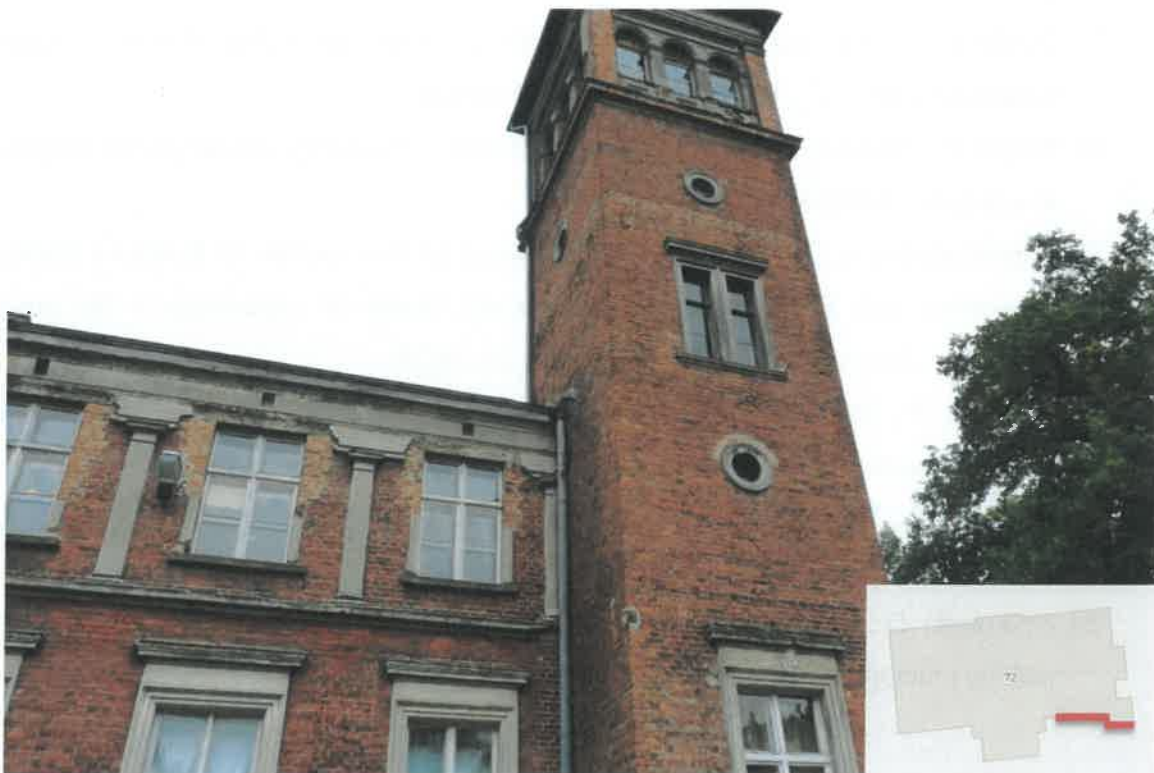
Fot. 1 – Elewacja południowa, brak siedlisk ptaków i nietoperzy.
