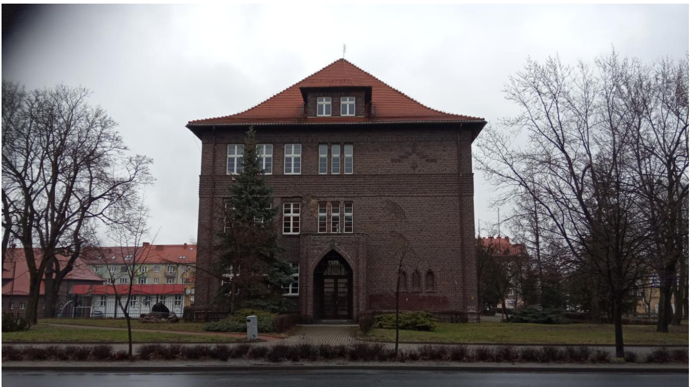
fot. 2 - elewacja południowa
