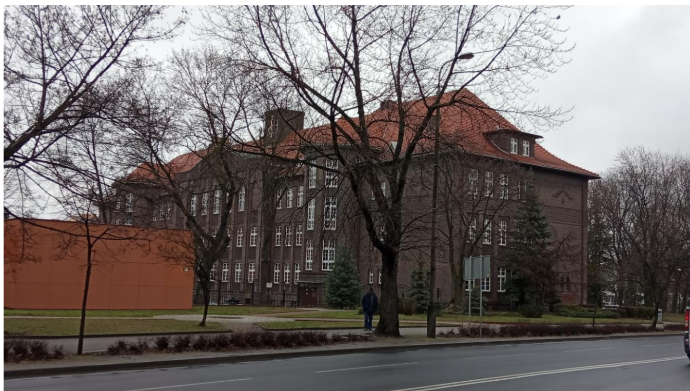
fot. 4 - elewacja zachodnia
