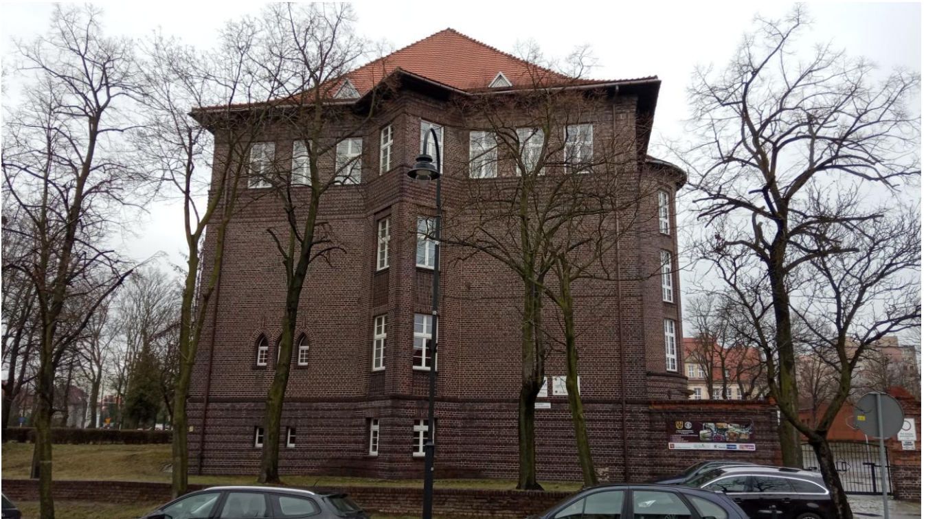
fot. 1 - elewacja północna
