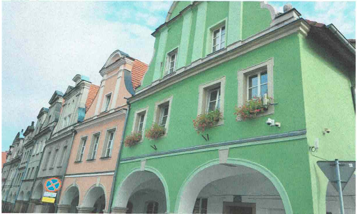
Fot. 1. Widok ogólny elewacji frontowej.
