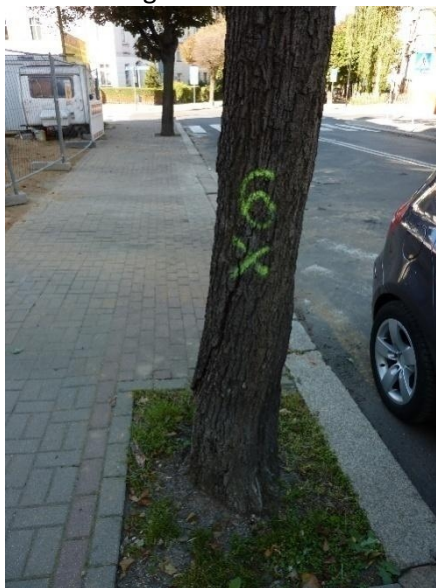
Fotografia 5. Zbyt mała powierzchnia nieutwardzona wokół drzew. Przykład złego projektowania (fot. K.Frankowska, stan. 20.09.2020 r.)
