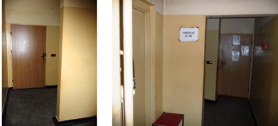
Fot. 7, 8. Zawężone przejścia wewnątrz klatek na poziomie parteru
