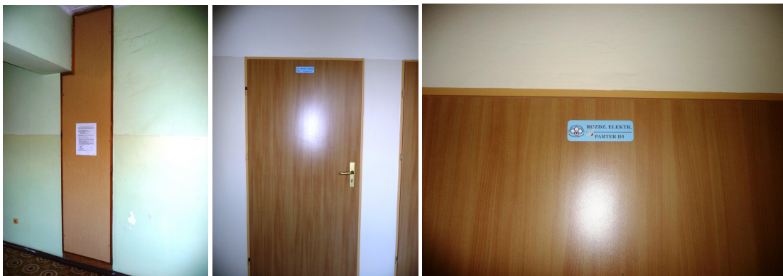
Fot. 4. Obudowa szachtu
