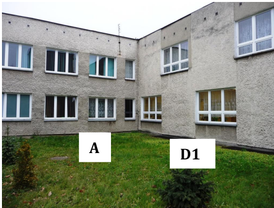
Fot. 13. Ściany segmentu A i D1
