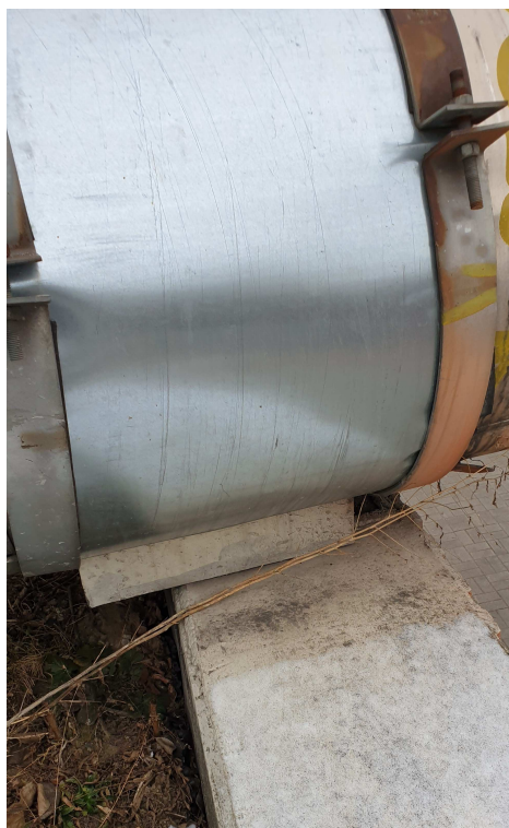
Fot. 7 - Istniejące podparcie rury
