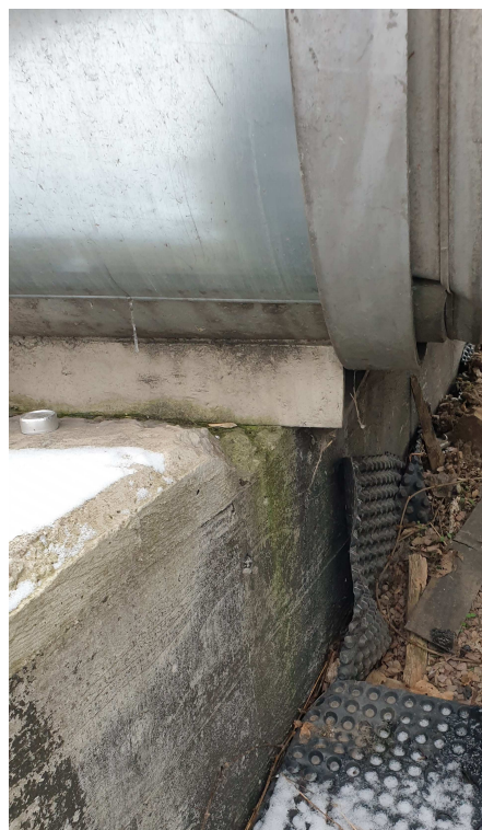
Fot. 8 - Istniejące podparcie rury
