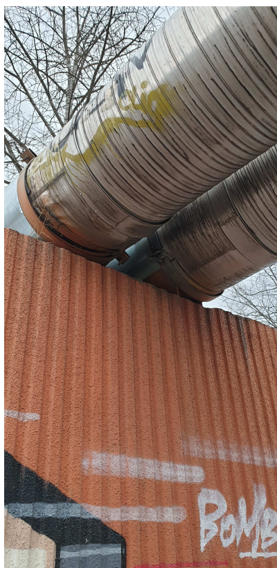
Fot. 3 - Istniejące podparcie rur
