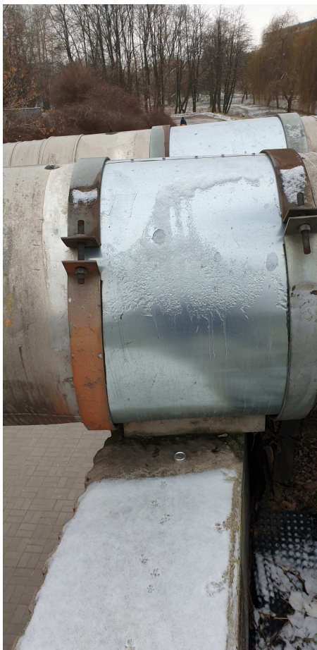
Fot. 5 - Istniejące podparcie rury
