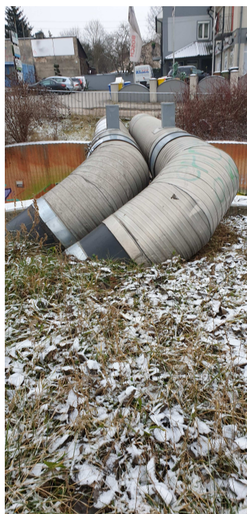
Fot. 2 - Istniejąca sieć ciepłownicza
