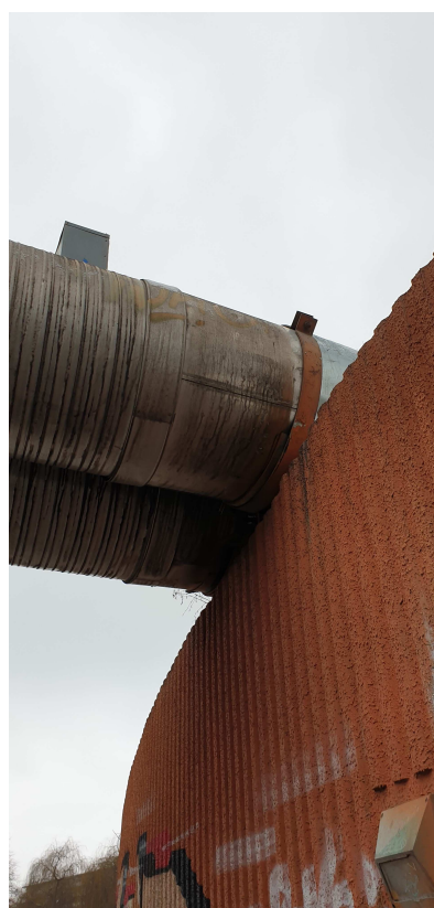
Fot. 4 - Istniejące podparcie rur
