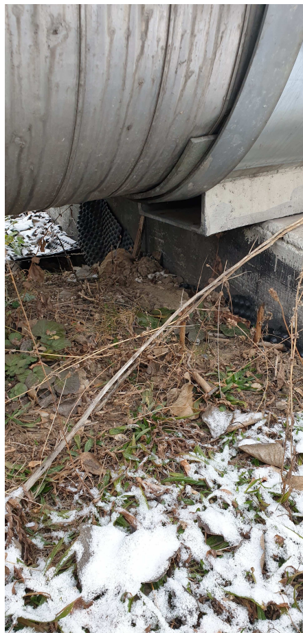
Fot. 6 - Istniejące podparcie rury
