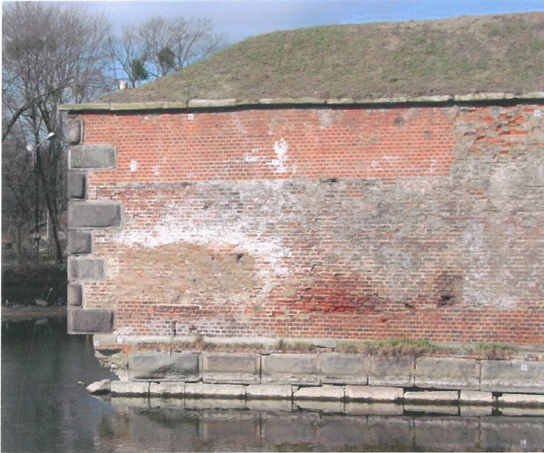
Fot. 3 Narożnik ściany południowej i wschodniej bastionu
