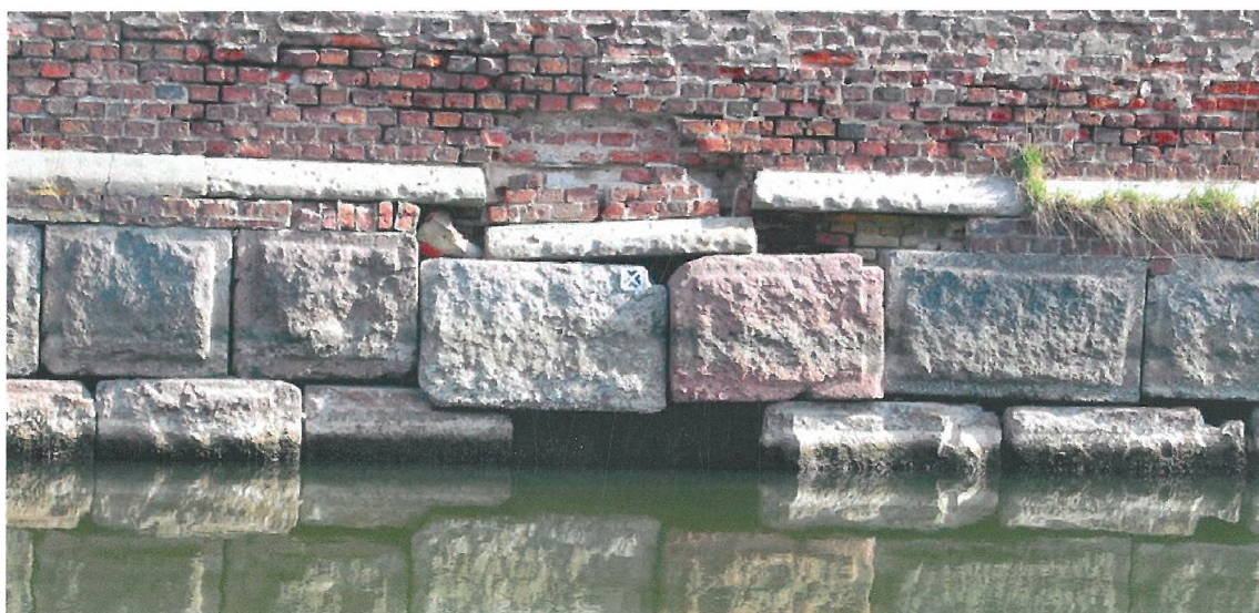
Fot. 6 Szczegół opuszczonych kamieni fundamentu
