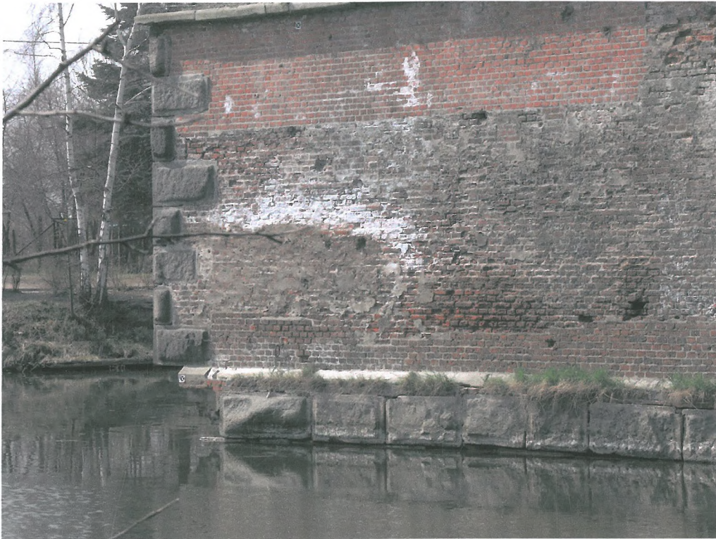
Zdj.3 Bastion Południowo-Wschodni. Fragment czola lewego.
