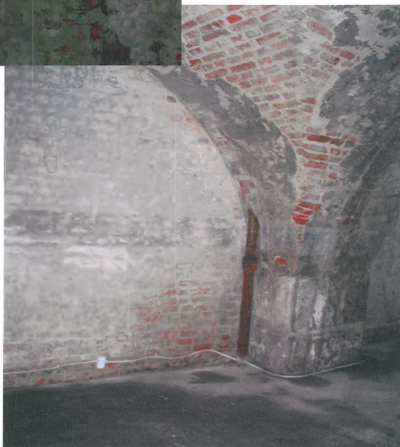
Zdj. 11 Szczegół wnętrza kazamat bastionu; widoczne rury kanalizacji deszczowej
