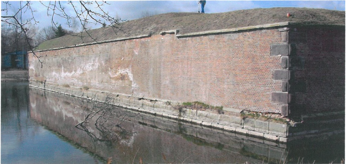
Fot. 1 Ściana bastionu Południowo-Wschodniego od strony Wschodniej
