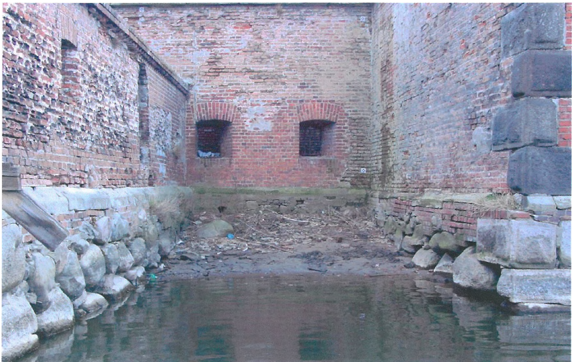
Fot. 7 Wnętrze ucha pomiędzy Bastionem Południowo-Wschodnim a Murem Fosbrei Południowym
