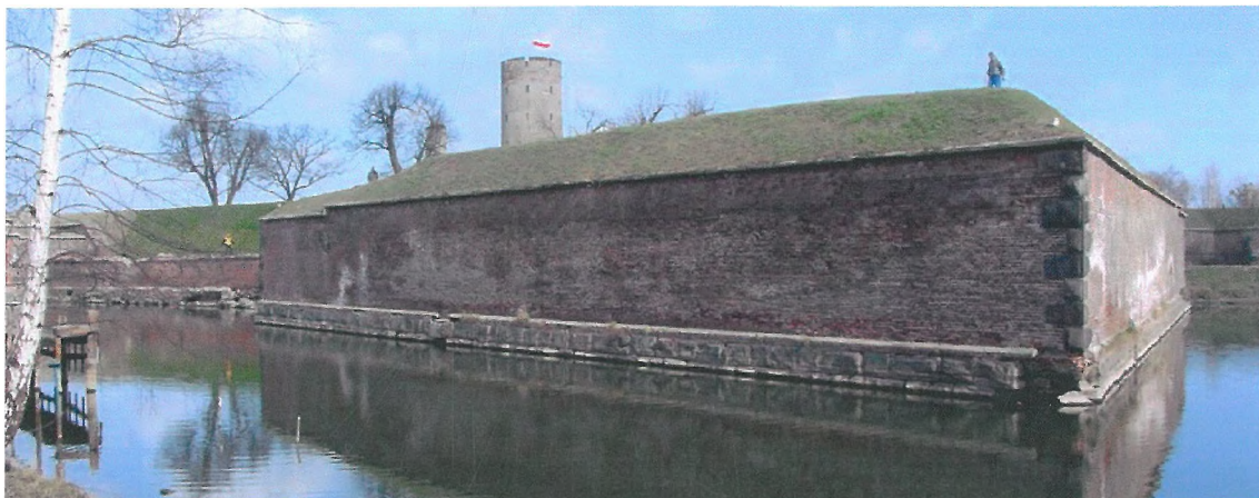
Fot. 5 Widok na ścianę południową Bastionu Południowo-Wschodniego
