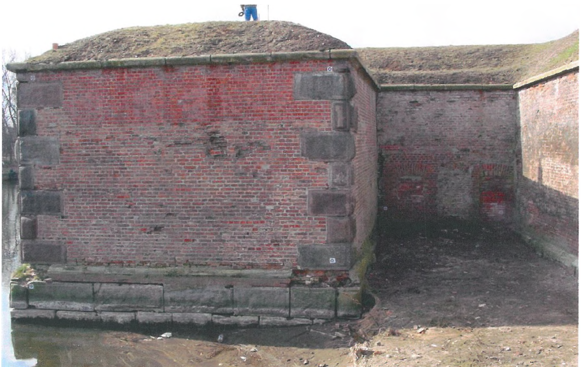
Fot. 2 Ucho pomiędzy Bastionem Południowo-Wschodnim a Murem Kurtynowym Wschodnim (od strony poterny)
