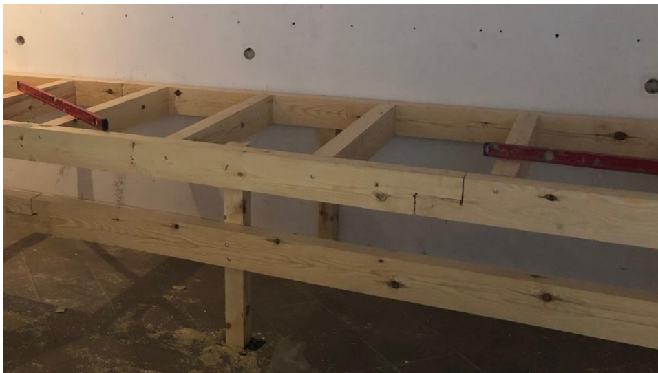
Rys. 45: Drewniana konstrukcja podestu. Belki izolowane są od ściany (niewidoczną na zdjęciu) matą izolującą 10 mm.
