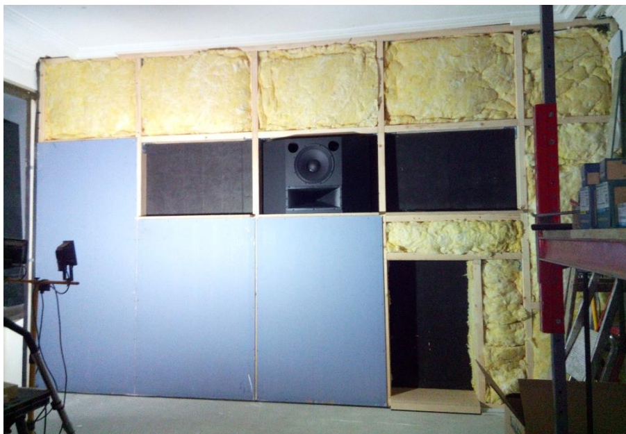
Rys. 22: Częściowo zabudowany stelaż z wstawionym jednym głośnikiem. Czarne wypełnienie otworów to szkliona wełna mineralna 50 mm. Należy zwrócić uwagę na belki okalające wszystkie otwory w płycie, do których musi być przyklejona i przykręcona płyta akustyczna (niebieska).
