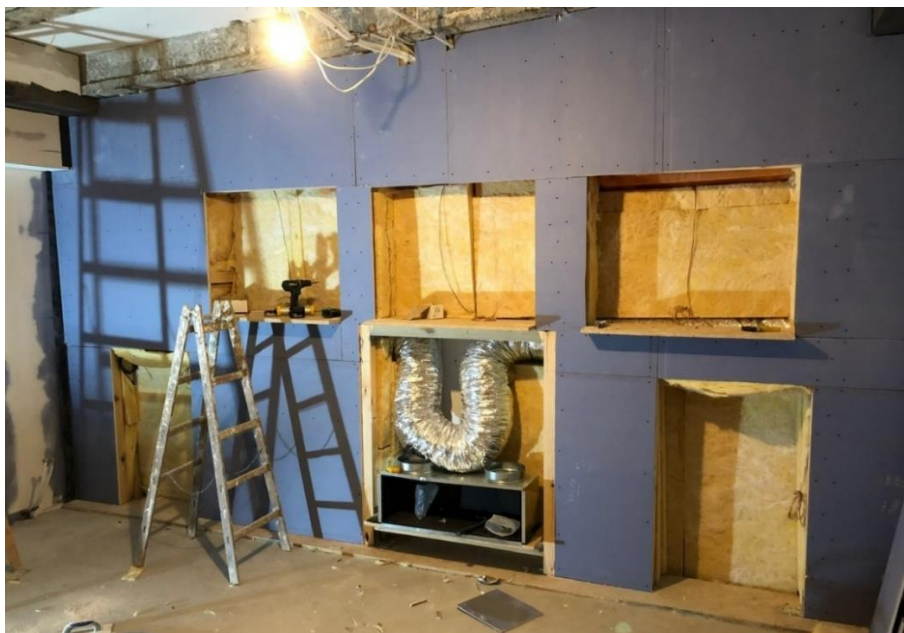
Rys. 21: Przegroda akustyczna z zainstalowaną trójwarstwową płytą akustyczną (płyta MFP obustronnie pokryta płytą G-K AKU). W otworach na głośniki widoczne wypełnienie wełną mineralną, która nie będzie zastąpiana płytą MFP.
