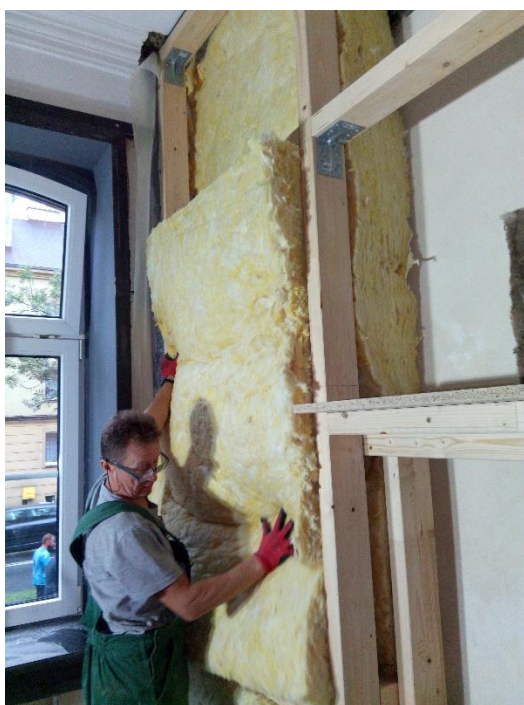
Rys. 36: Wypełnianie przestrzeni stelaża wełną mineralną o niskiej gęstości.
