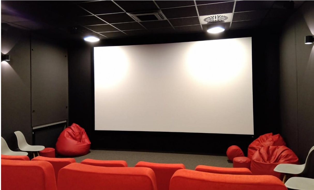
Rys. 41: Ściana akustyczna z ekranem akustycznym, pokryta w całości tkaniną akustyczną.
