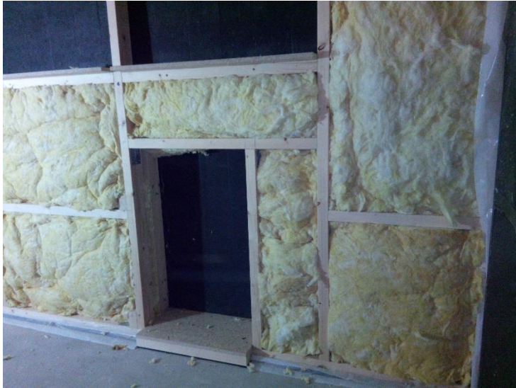
Rys. 37: W otworach na głośniki widać warstwę szklonej wełny 50 mm.
