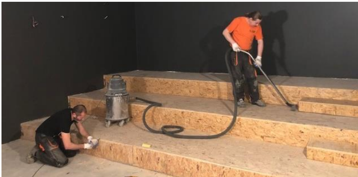
Rys. 48: Podest pokryty płytą i przygotowany do pokrycia wykładziną
