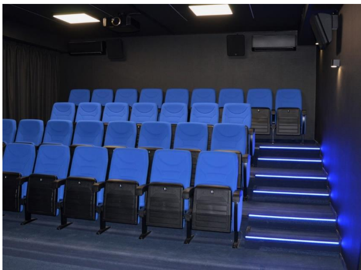
Rys. 50: Gotowy podest z fotelami. Widoczne oświetlenie krawędzi stopni.
