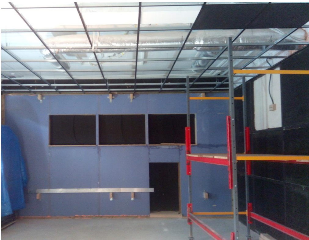
Rys. 11: Na prawej ścianie widoczny drewniany stelaż wypełniony arkuszami wełny mineralnej. z przodu ściana akustyczna, pod sufitem zawieszono sę profile dla sufitu podwieszanego.
