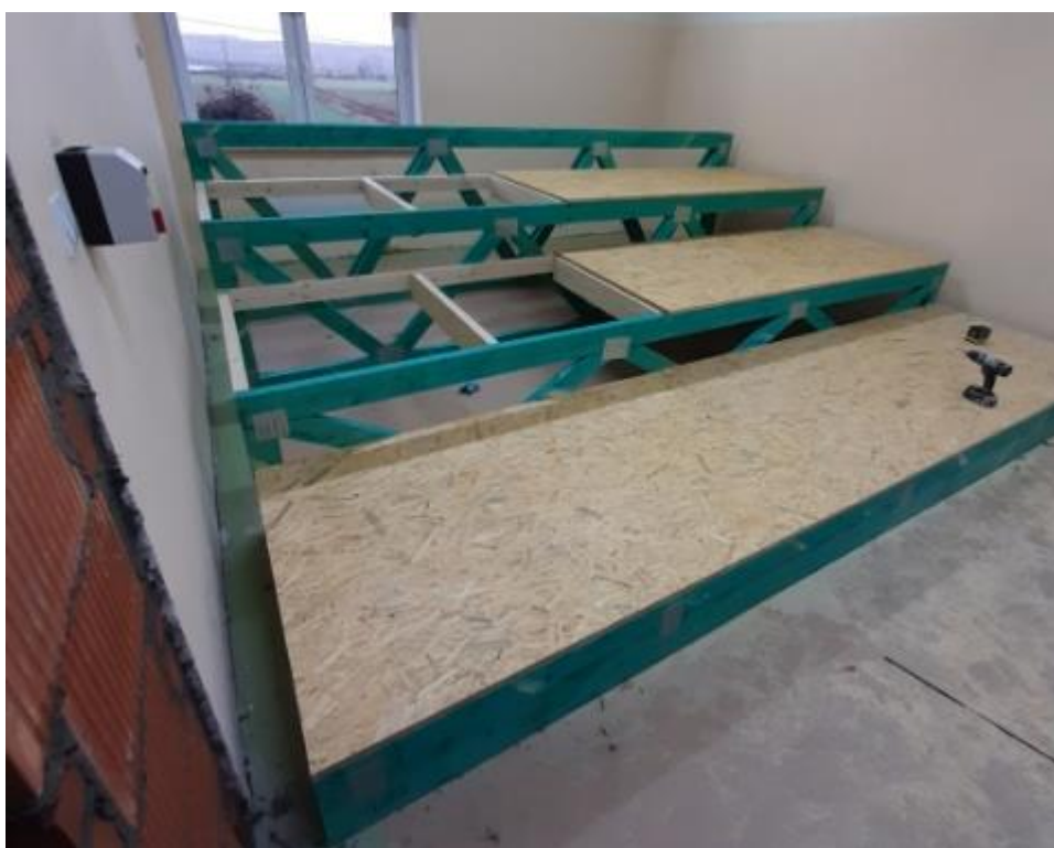
Rys. 46: Inna konstrukcja podestu drewnianego. Po lewej pozostawione miejsce na okładzinę wygłuszającą.
