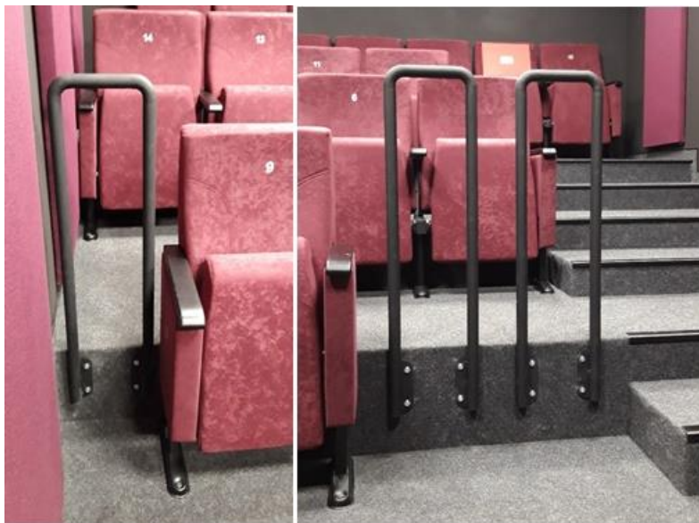
Rys. 52: Proste metody zabezpieczenia niebezpiecznych przejść i miejsca na wózek inwalidzki.
