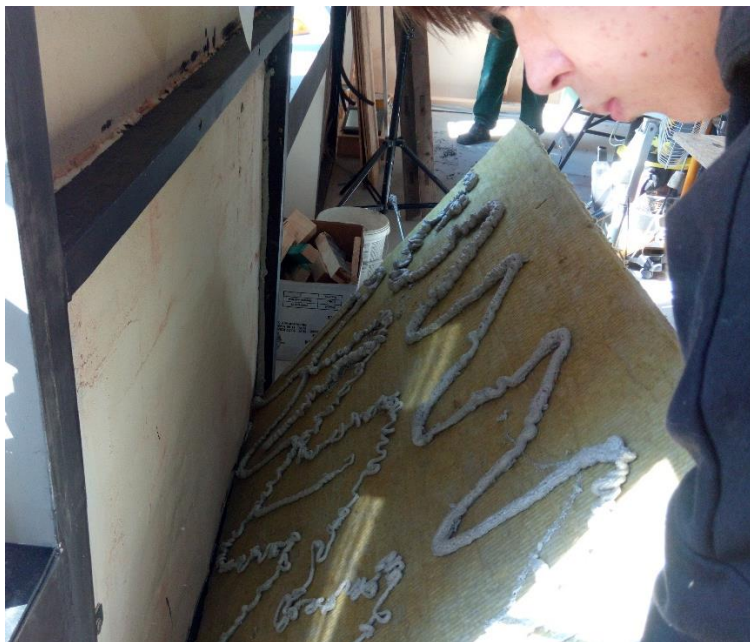
Rys. 12: Arkusze wełny mineralnej przyklejane do ściany za pomocą pianokleju.
