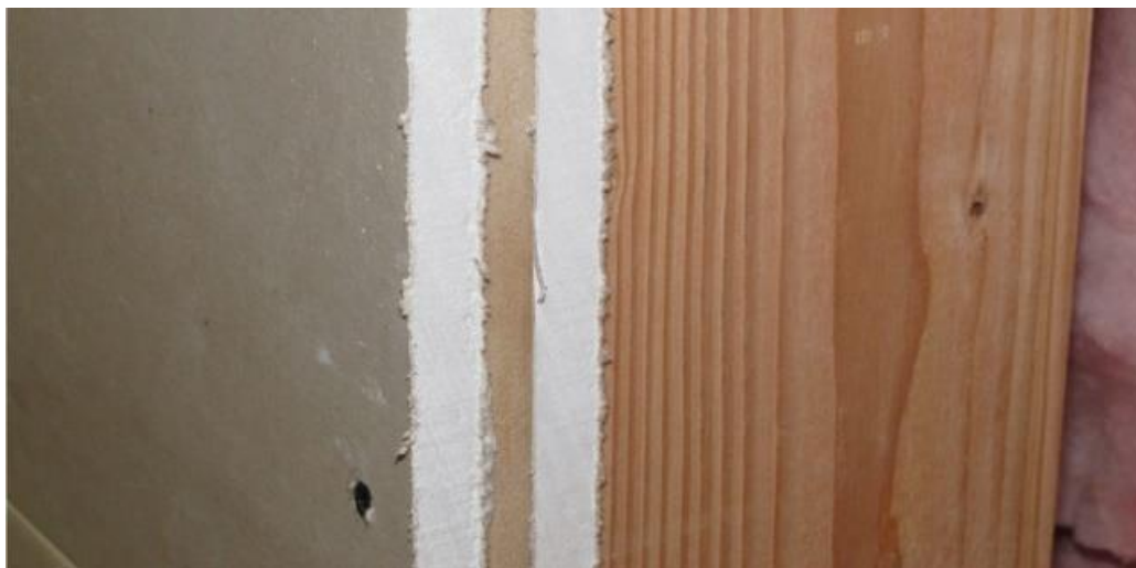
Rys. 32: Fragment trójwarstwowej płyty akustycznej przy otworze na głośnik. Brzeg płyty nie jest jeszcze wykończony.
