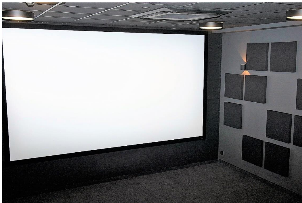
Rys. 18: Ściana akustyczna z ekranem, głośniki przykryte są tkaniną akustyczną.
