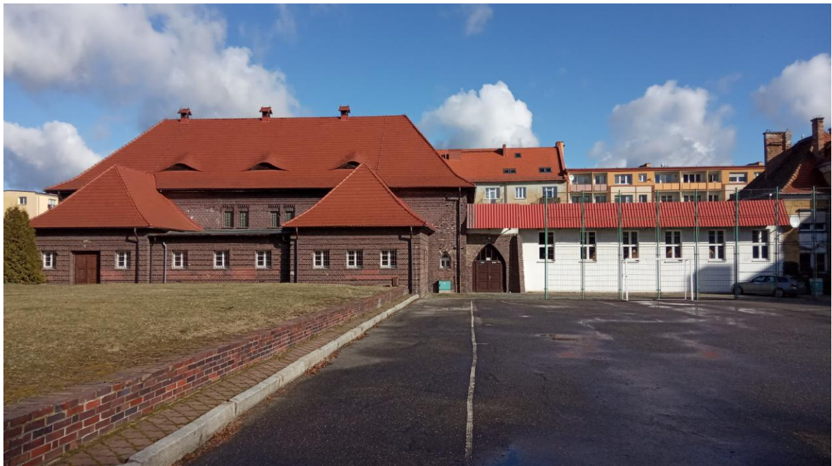
fot. 2 - elewacja południowa
