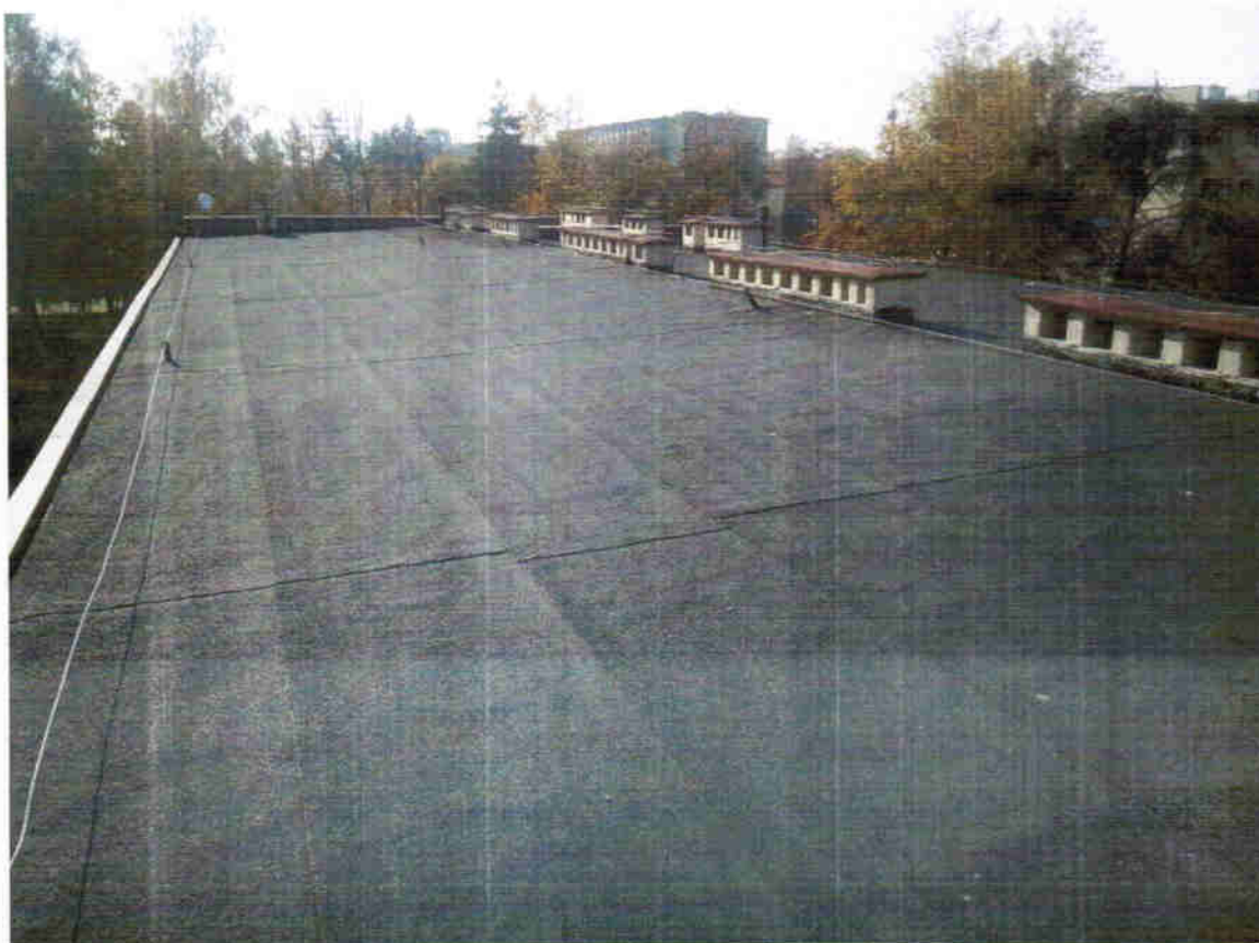
Zdjęcie nr 1 Dach płaski Przedszkola nr 2 w Tucholi
