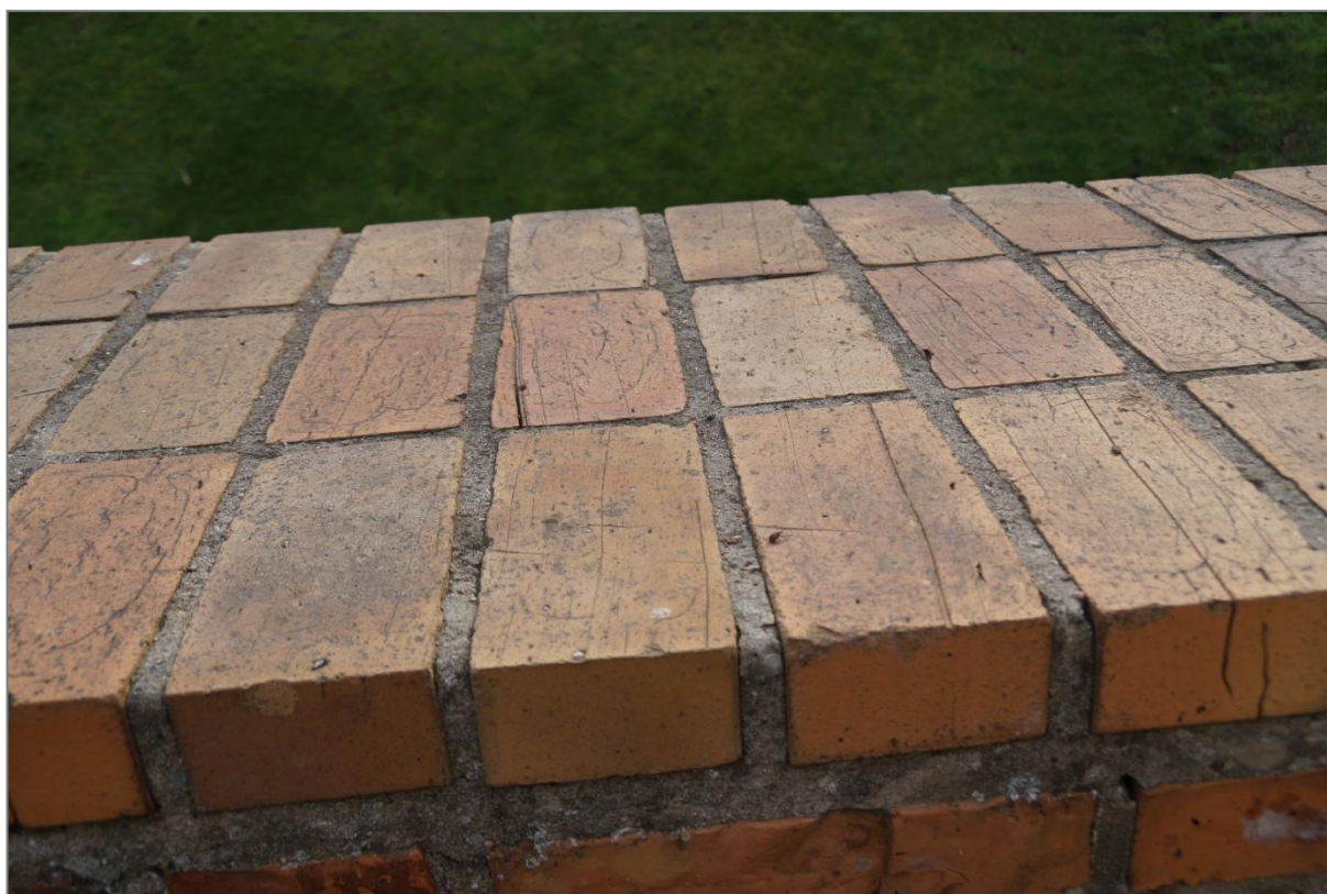
47. Jeden z nielicznych fragmentów dobrze zachowanej płaszczyzny pulpitowej korony muru.
