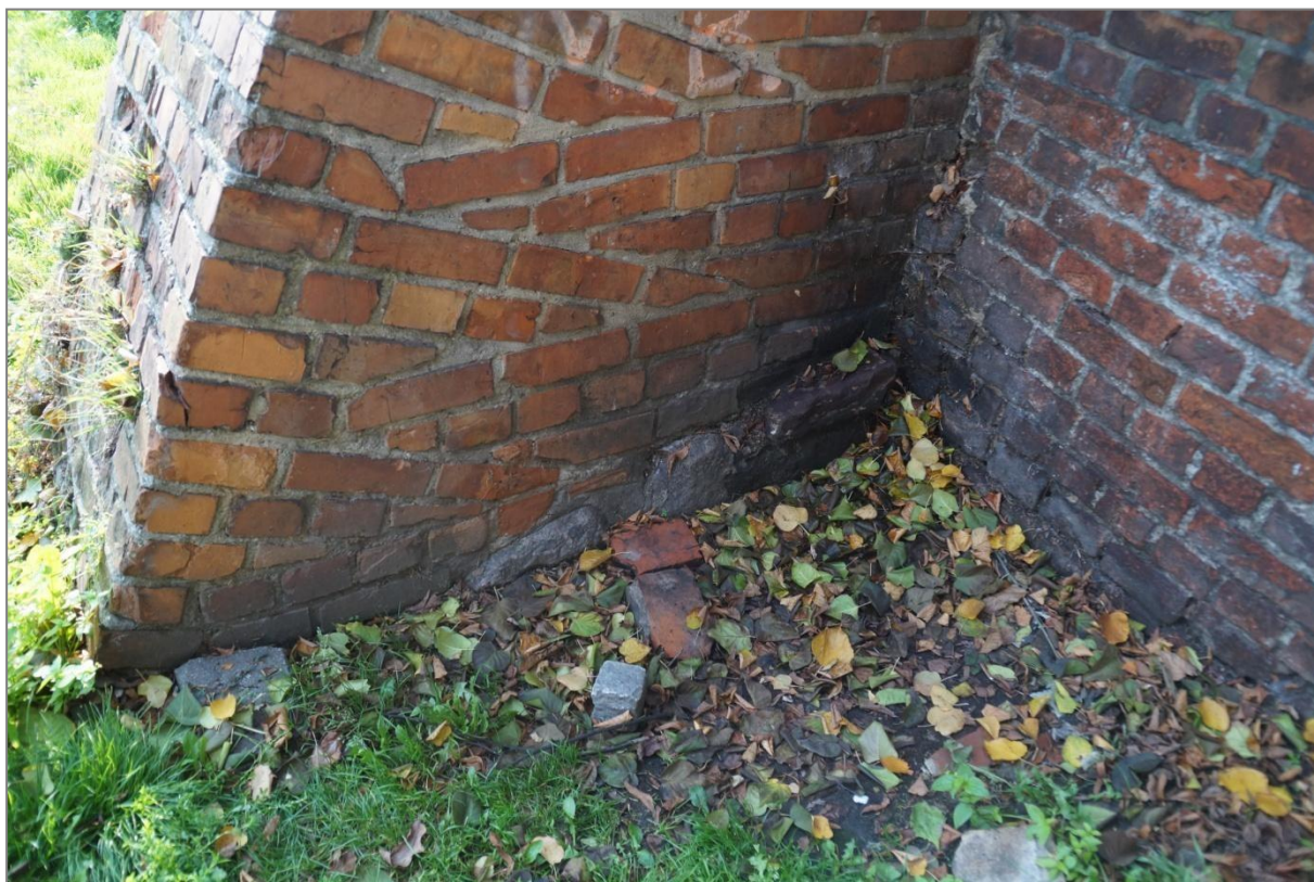
36., 37. Przypora we wschodniej części muru. w licu której znaczny udział mają poważnie uszkodzone cegły.
