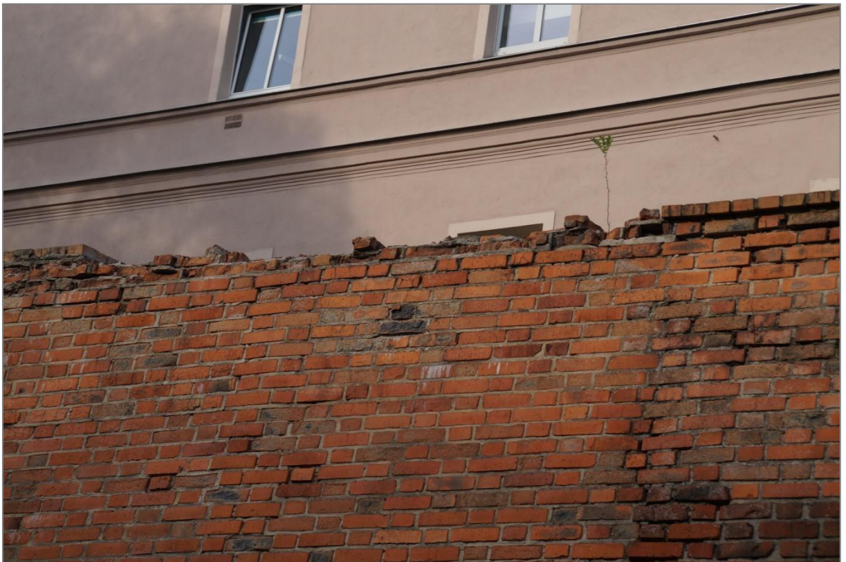
23., 24. Rozpadająca się korona muru.
