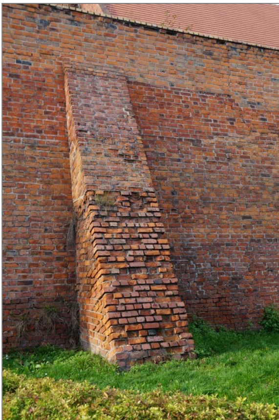
36., 37. Przypora we wschodniej części muru. w licu której znaczny udział mają poważnie uszkodzone cegły.
