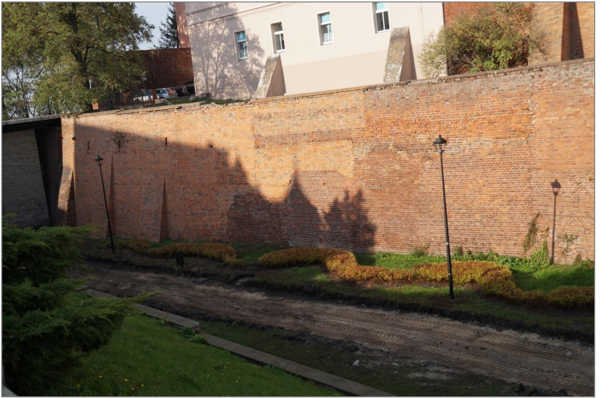
12. Zachodnia część zewnętrznego pierścienia południowego odcinka obwarowań miejskich Grudziądza.
