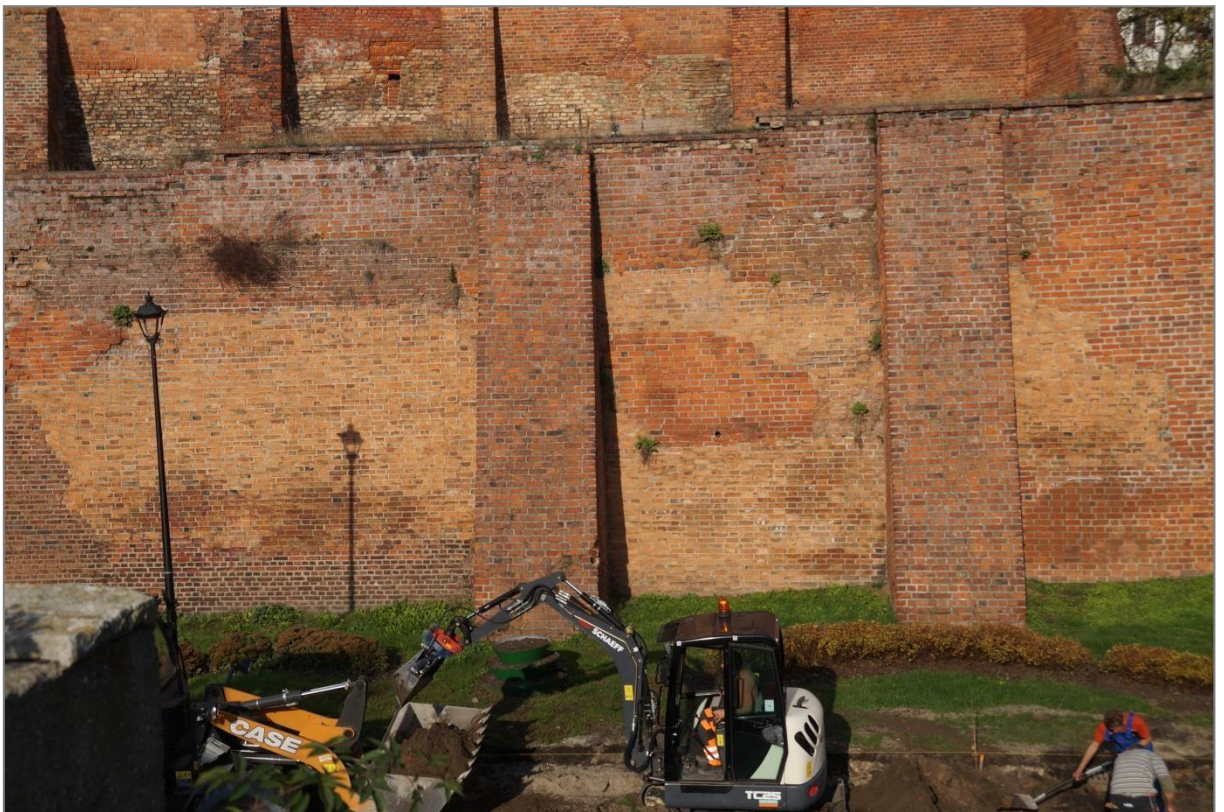
17., 18. Lico muru zewnętrznego pierścienia obwarowań z czytelnymi partiami licznych przemurowań. Niestety na murze znalazło się szpecące graffiti.
