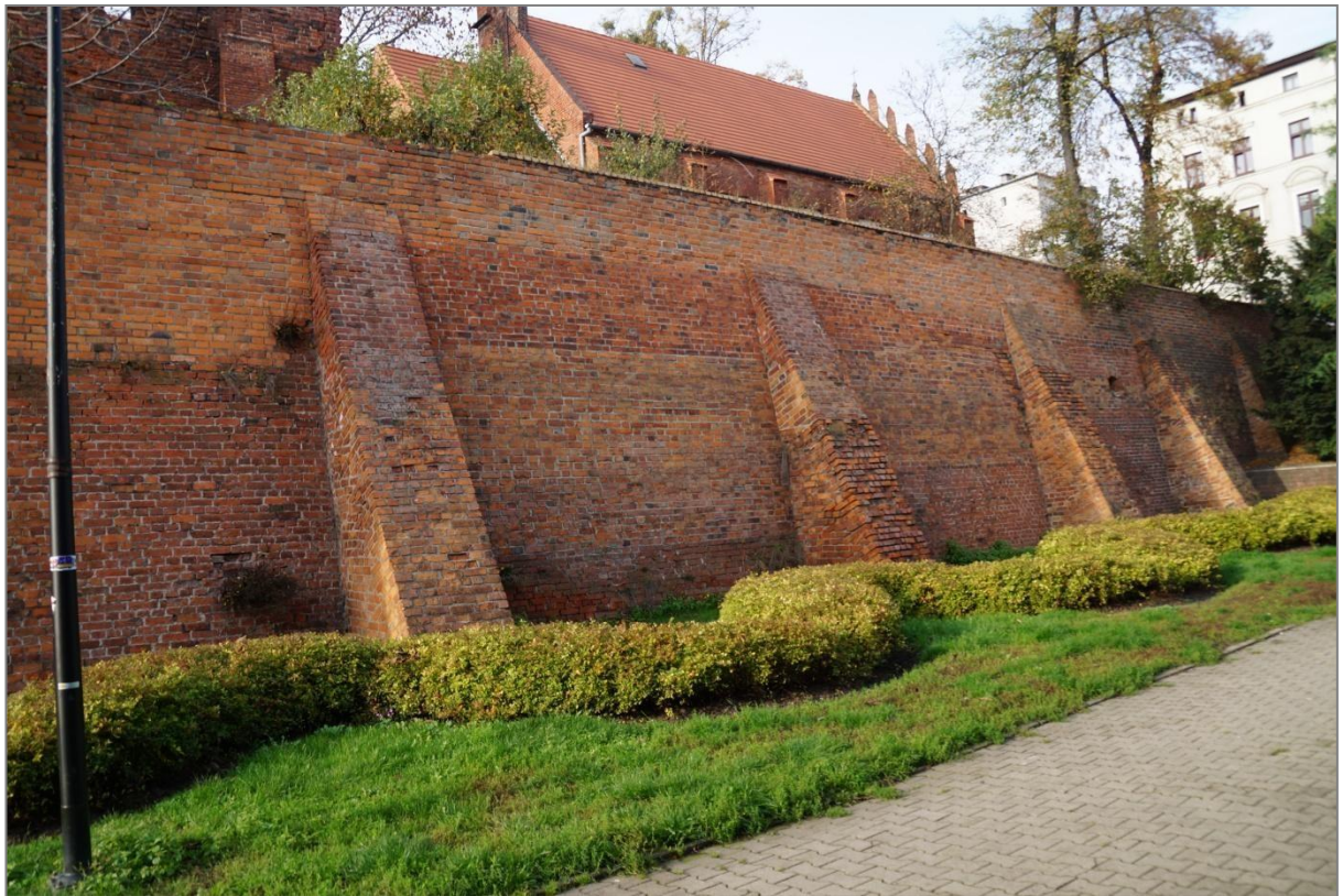
30., 31. Wschodnia część muru zewnętrznego pierścienia południowo-wschodnich obwarowań miejskich.
