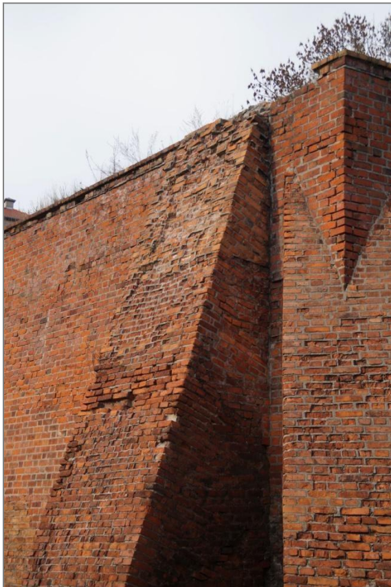
26.,27. Bardzo zniszczone przypory w południowo- wschodnim narożniku muru.
