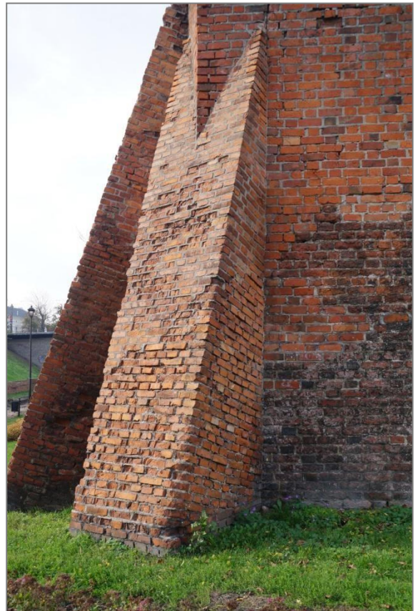
26.,27. Bardzo zniszczone przypory w południowo- wschodnim narożniku muru.
