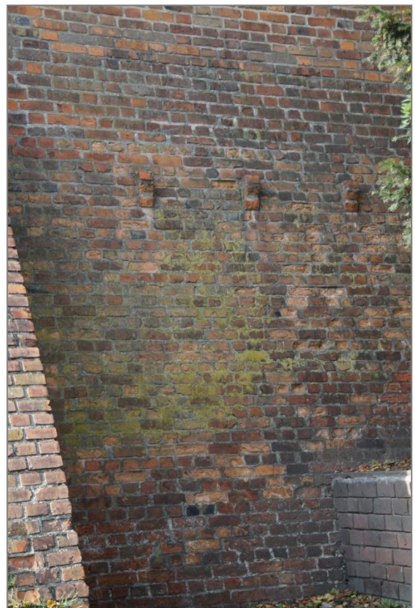
41. Północna część wschodniego muru - miejsce porośnięte glonami z ciemnymi
