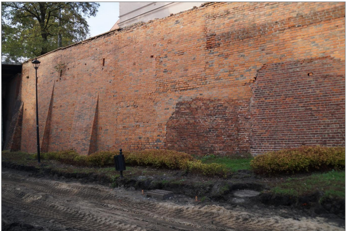
13. Zachodnia część zewnętrznego pierścienia południowego odcinka obwarowań miejskich w dużej mierze przelicowana w XX wieku.
