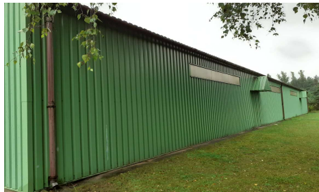
c) Hala magazynowa B5
