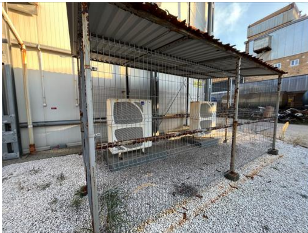
Fot. 4. Widoczne boksy na jednostki zewnętrzne central klimatyzacyjnych.
