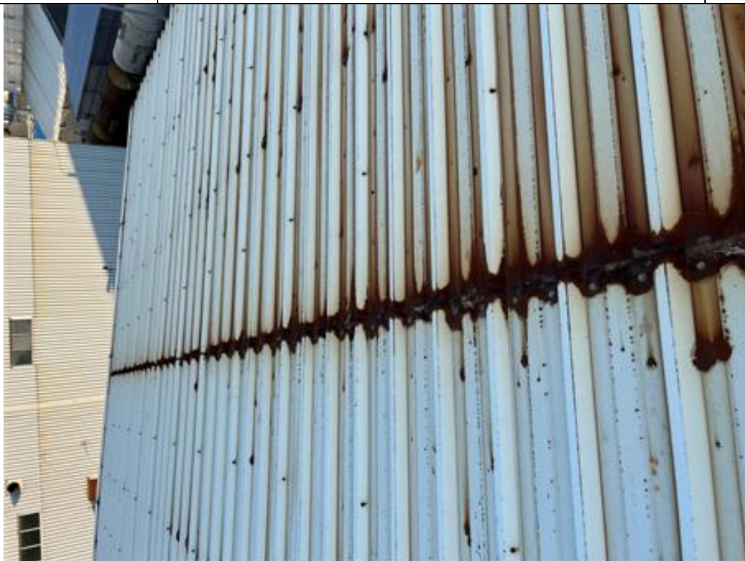
Fot. 7. Dach widoczna korozja na połączeniu blach dachowych.
