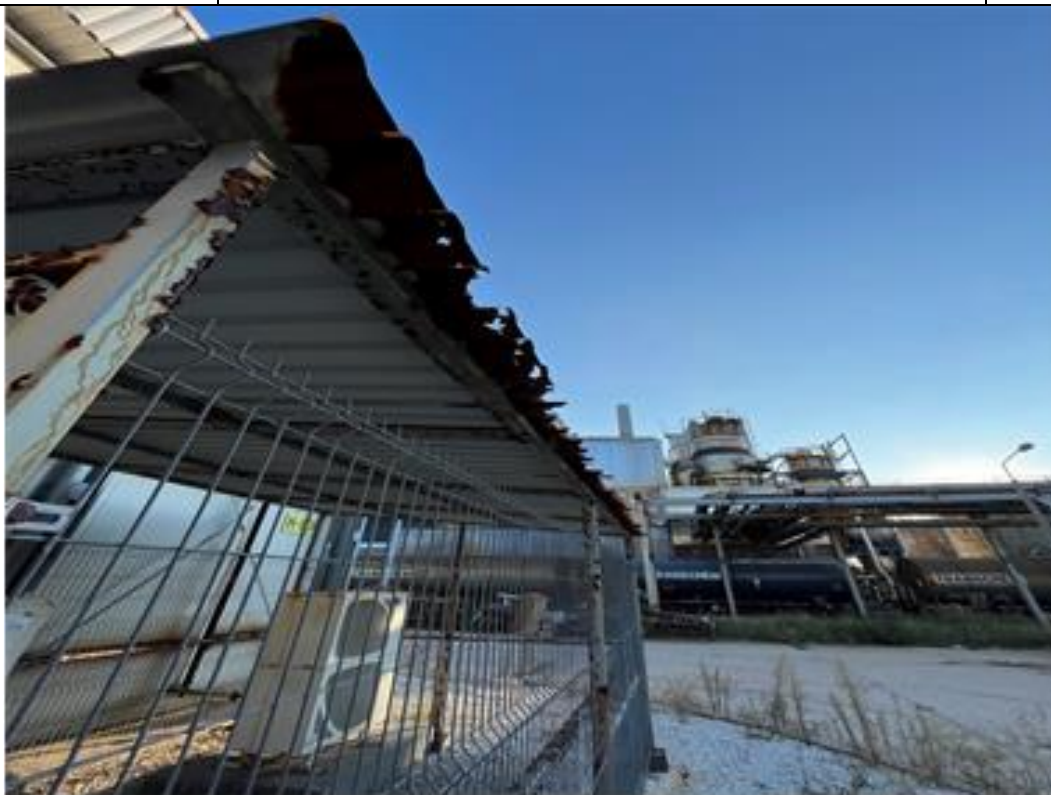
Fot. 5. Widoczne boksy na jednostki zewnętrzne central klimatyzacyjnych, korozja metalo-konstrukcji oraz stalowego poszycia dachowego.
