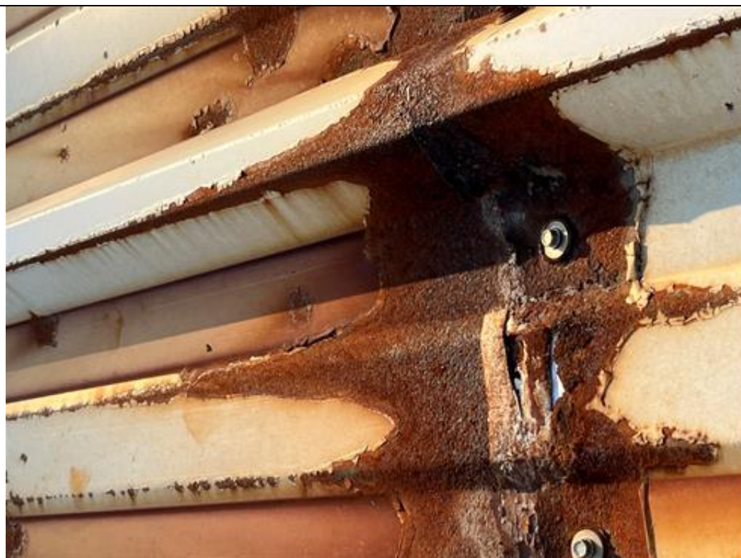
Fot. 8. Widoczne dziury na połączeniu blach dachowych.
