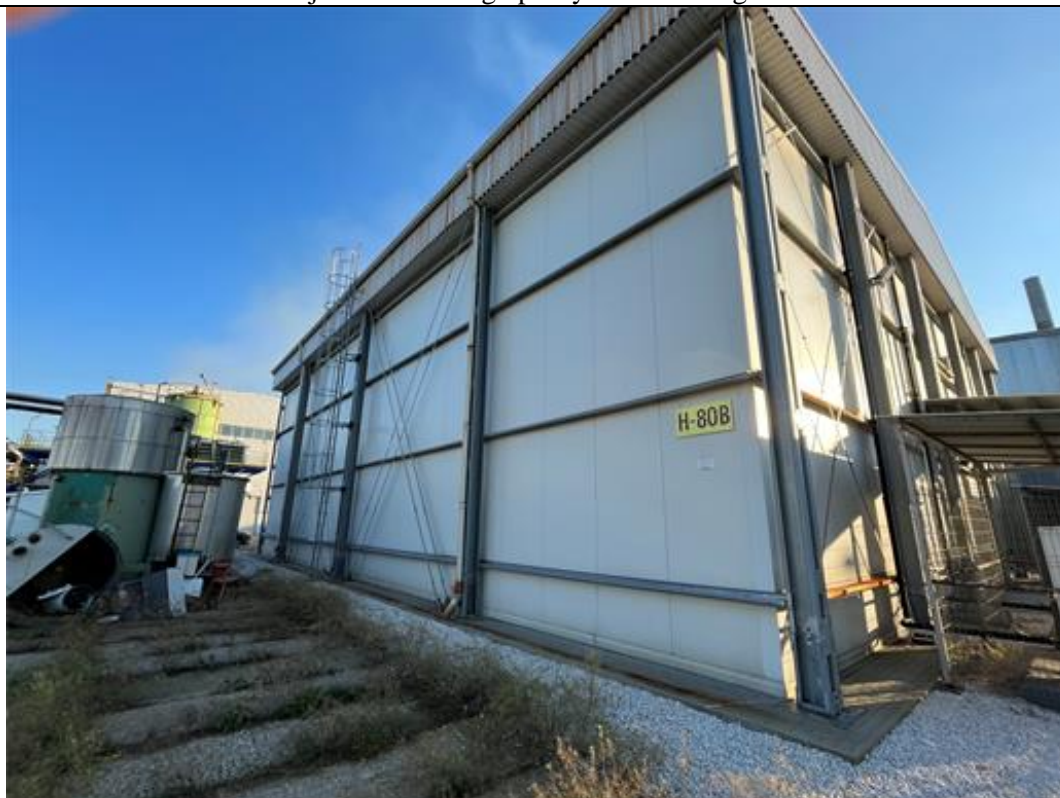
Fot. 6. Widoczne boksy na jednostki zewnętrzne central klimatyzacyjnych.
