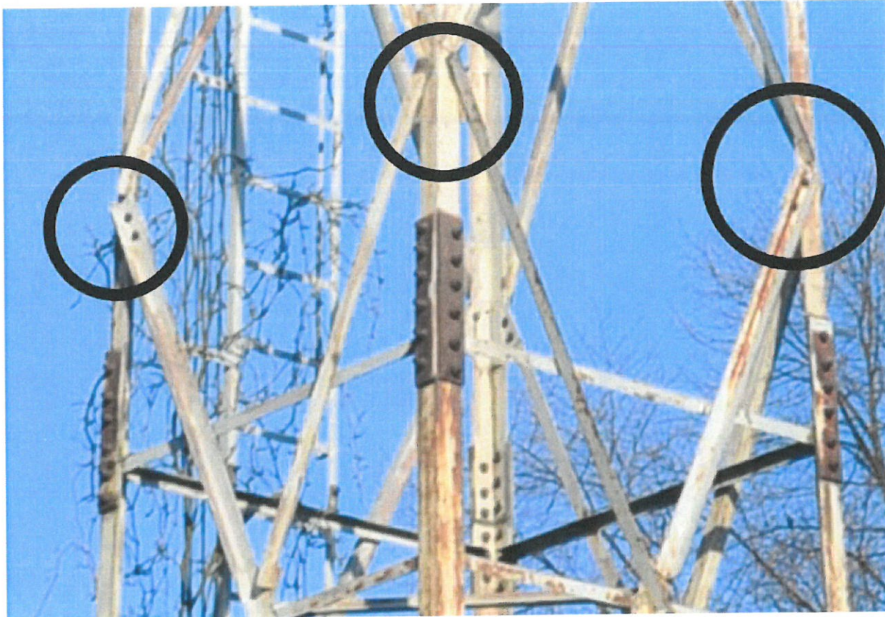
Fot. 13. Połączenie segmentów – widoczne śrubowe połączenie stężeń z krawężnikami
