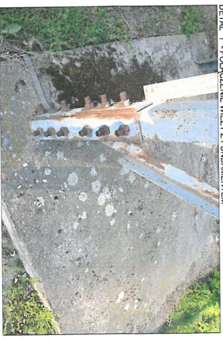
DETAL "2*" - POŁĄCZENIE SEGMENTÓW
