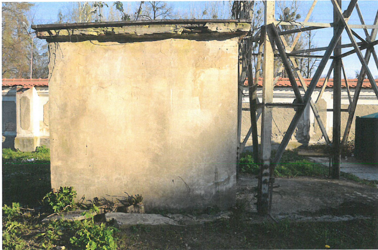
Fot. 5. Kabina techniczna – elewacja północna
