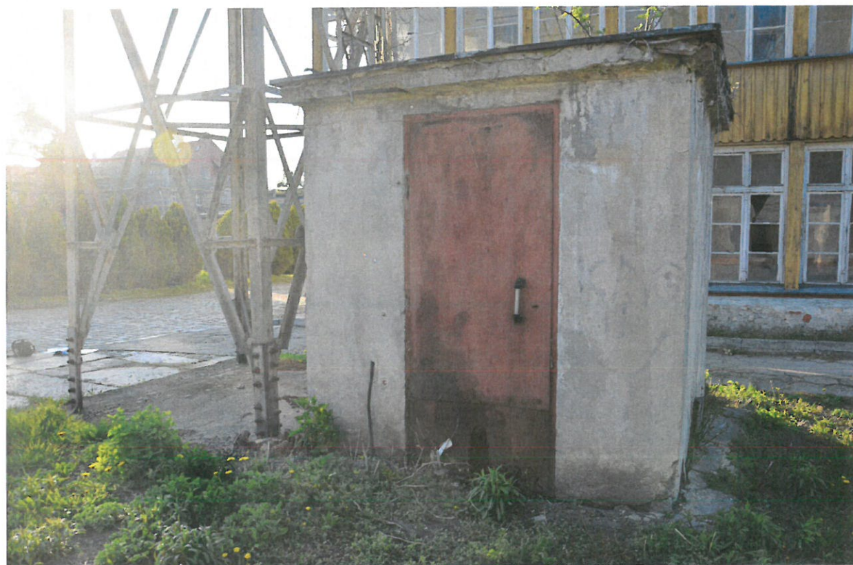
Fot. 6. Kabina techniczna – elewacja południowa
