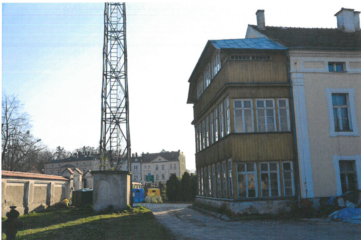
Fot. 3. Widok na wieżę i kabinę techniczną od strony wschodniej
