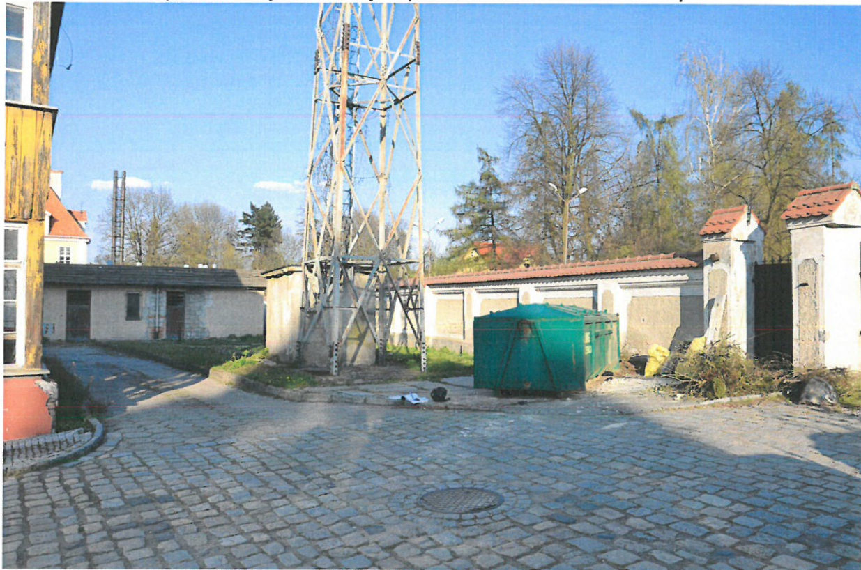
Fot. 2. Widok na wieżę i kabinę techniczną od strony zachodniej
