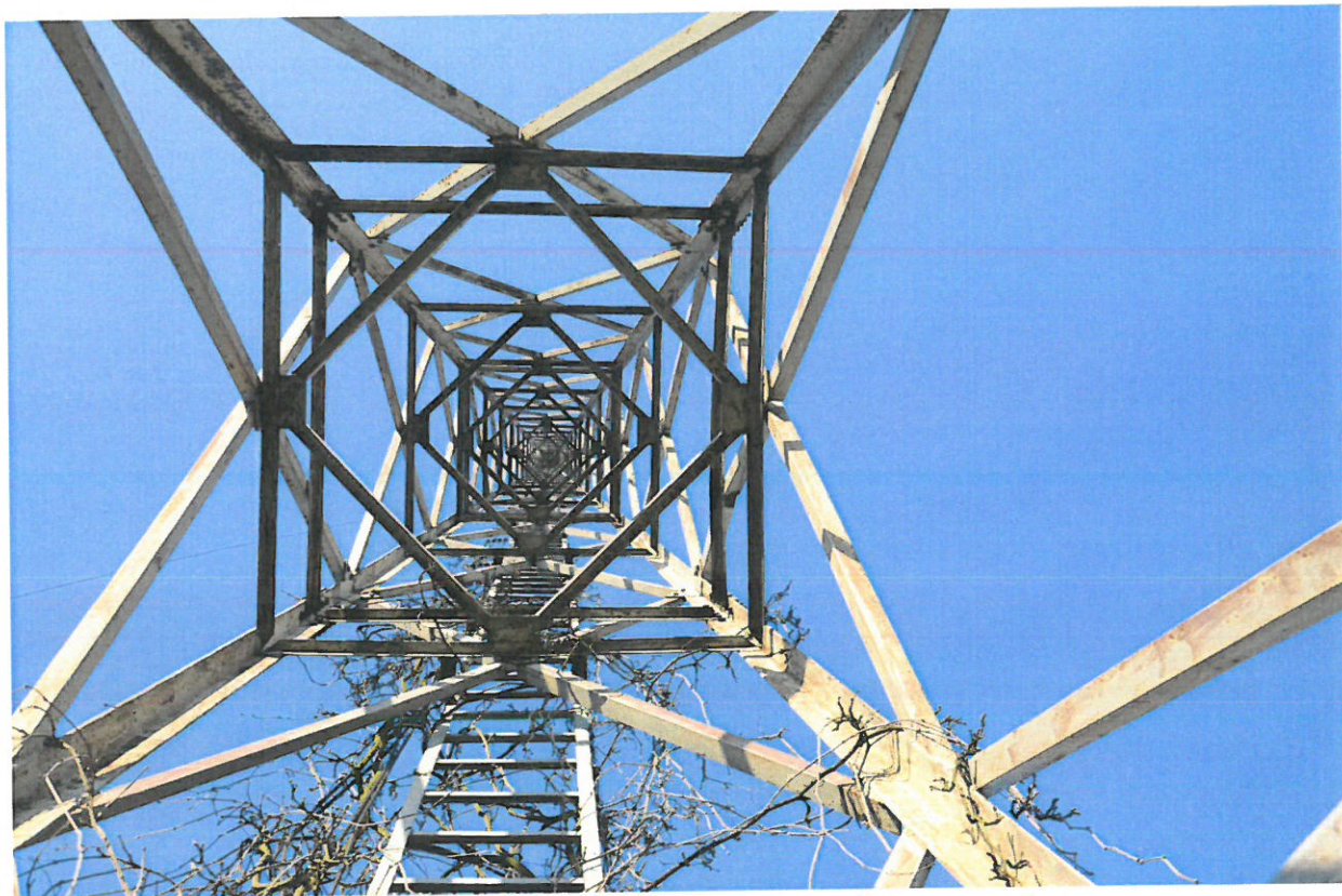
Fot. 10. Przepony stabilizujące poszczególne segmenty
