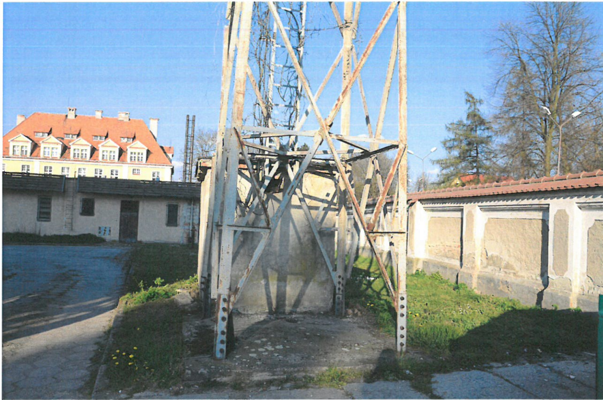
Fot. 7. Połączenie segment nr 1 z fundamentem blokowym
