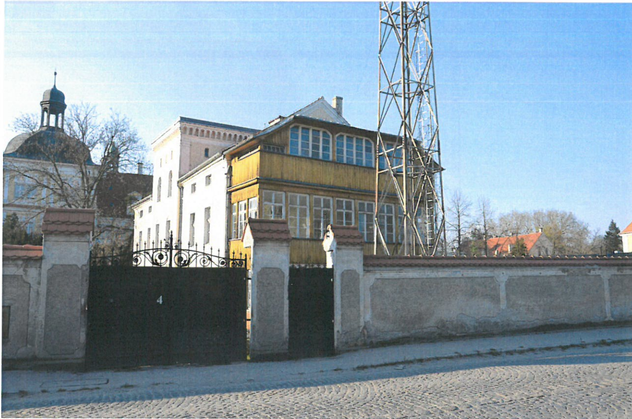
Fot. 1. Widok na działkę 6 od strony ul. Klasztornej (z ulicy Mickiewicza). Wjazd umożliwiający bezpośredni dojazd do miejsca prowadzenia robót rozbiórkowych
