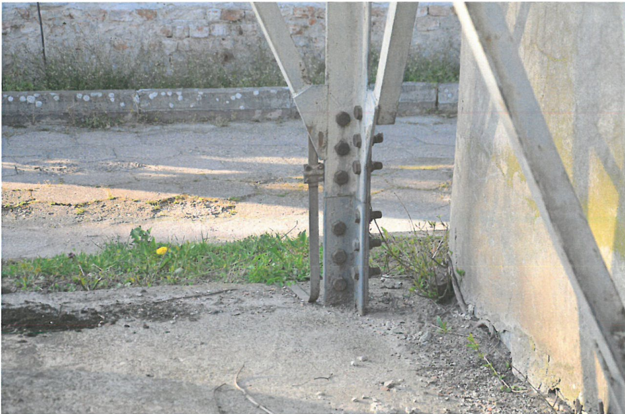
Fot. 8. Połączenie segment nr 1 z fundamentem blokowym
