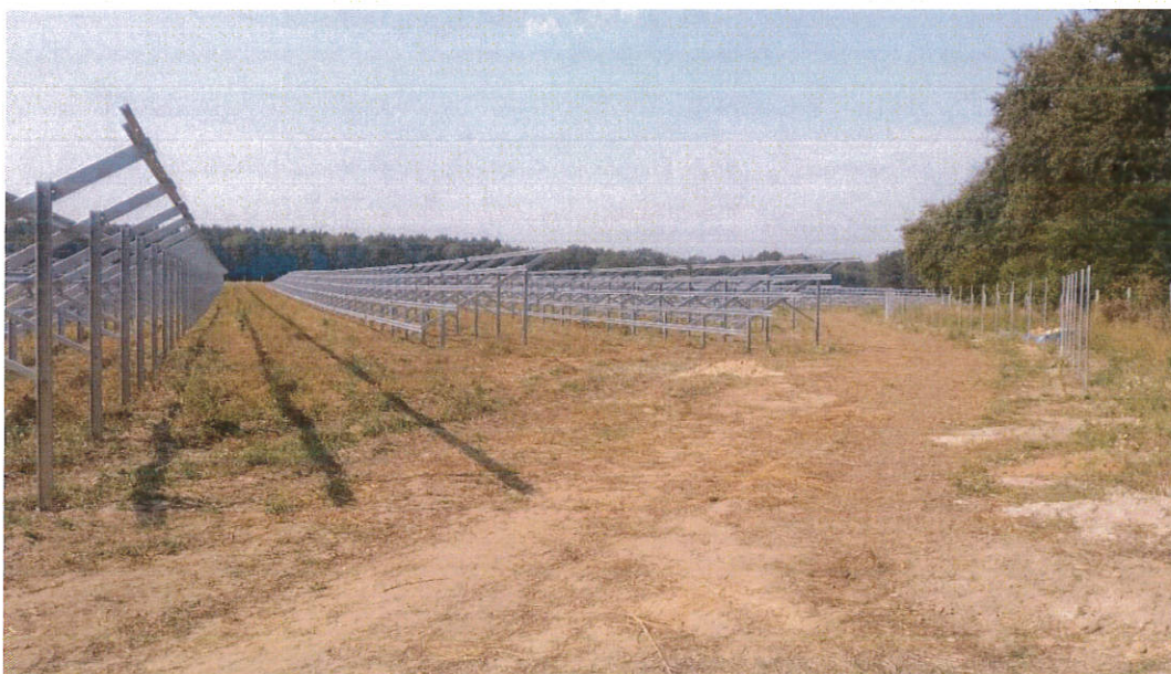
[Fot.1] przygotowane konstrukcje nośne do paneli fotowoltaicznych „palowane” w gruncie.
