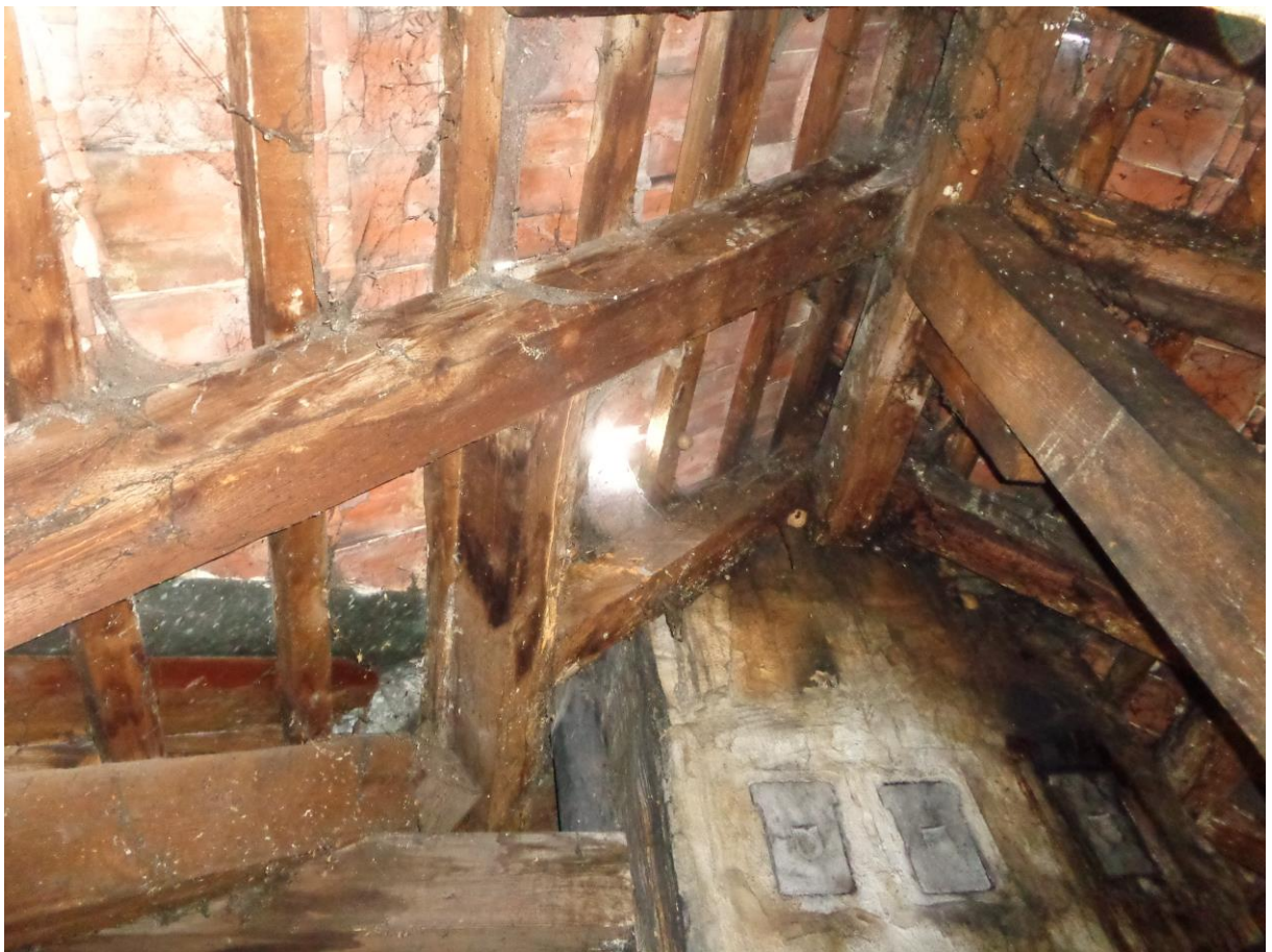
Zacieki na kominach, prześwity w dachu.
