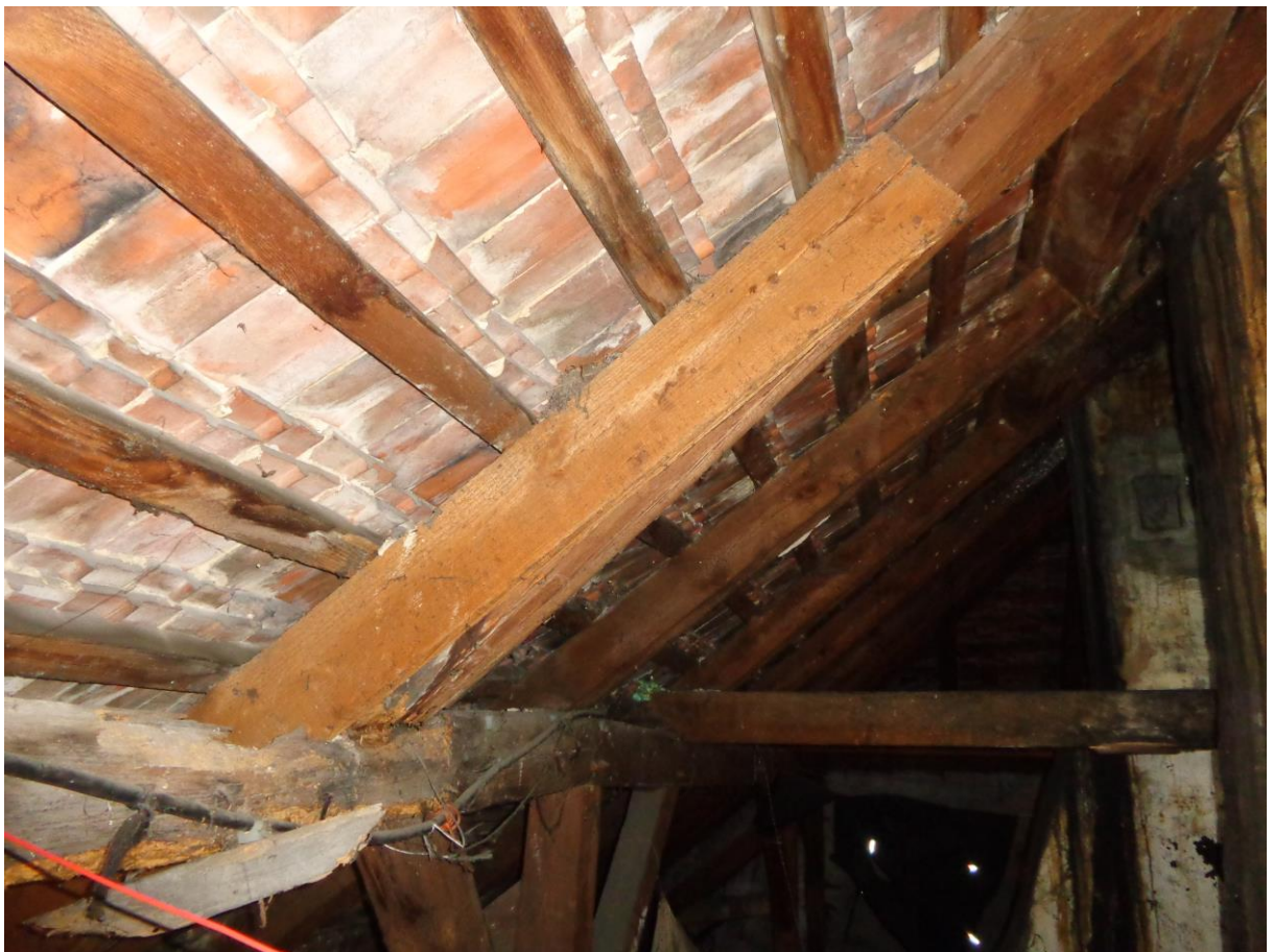
Porażenia więźby dachowej.
