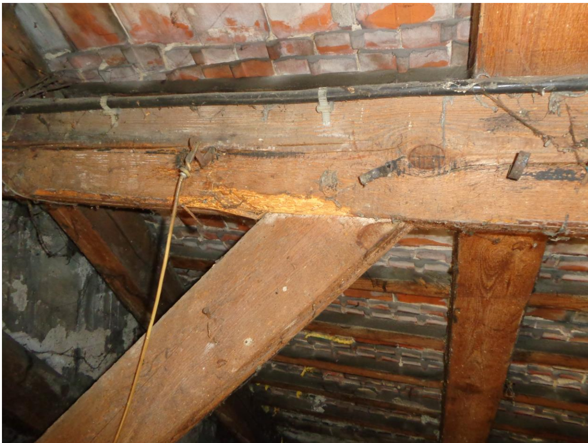
Porażenie więźby dachowej.
