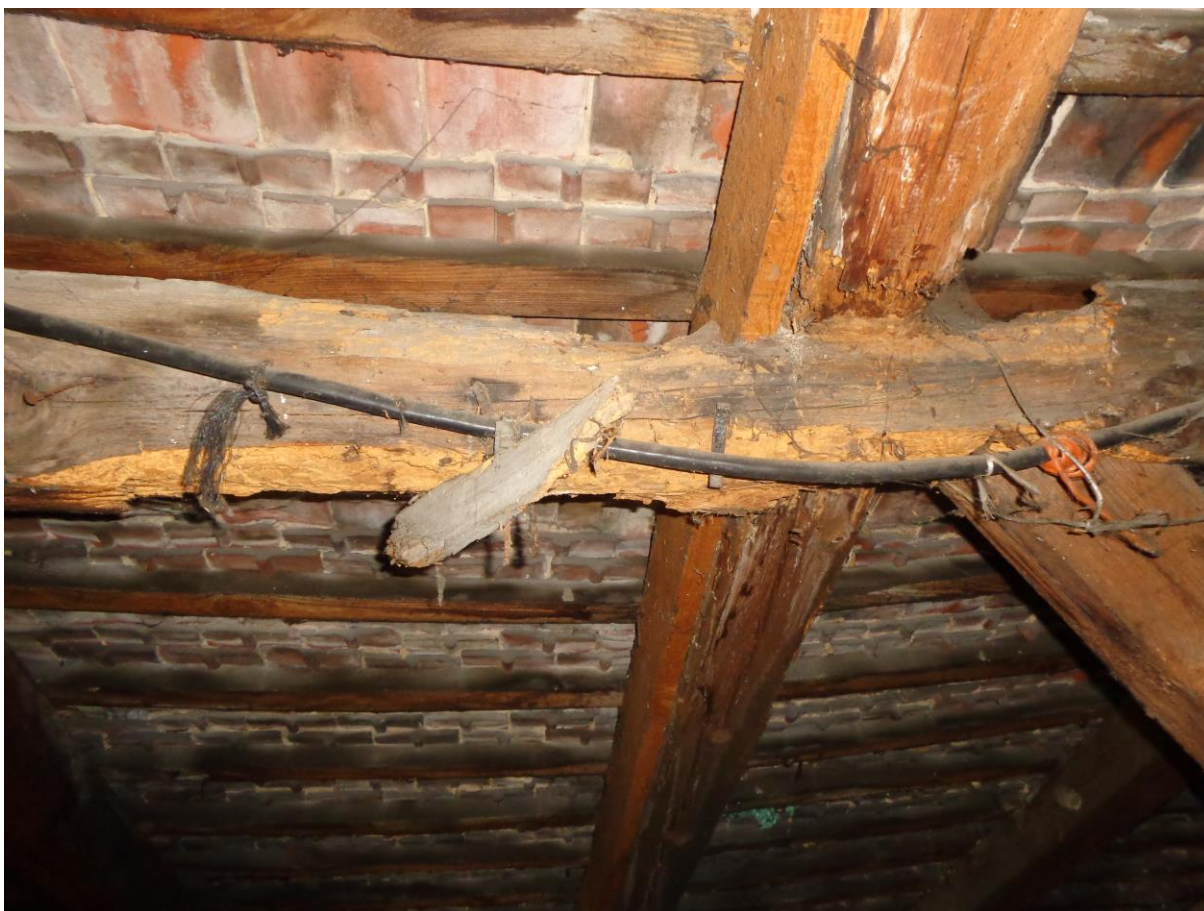
Porażenia więzby dachowej.
