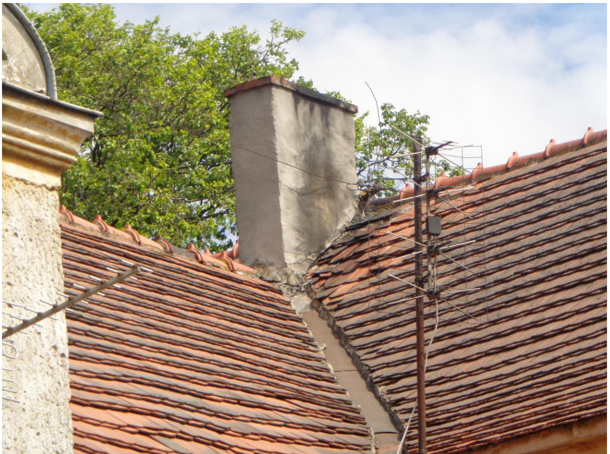
Kominy ponad dachem, stan pokrycia dachowego.
