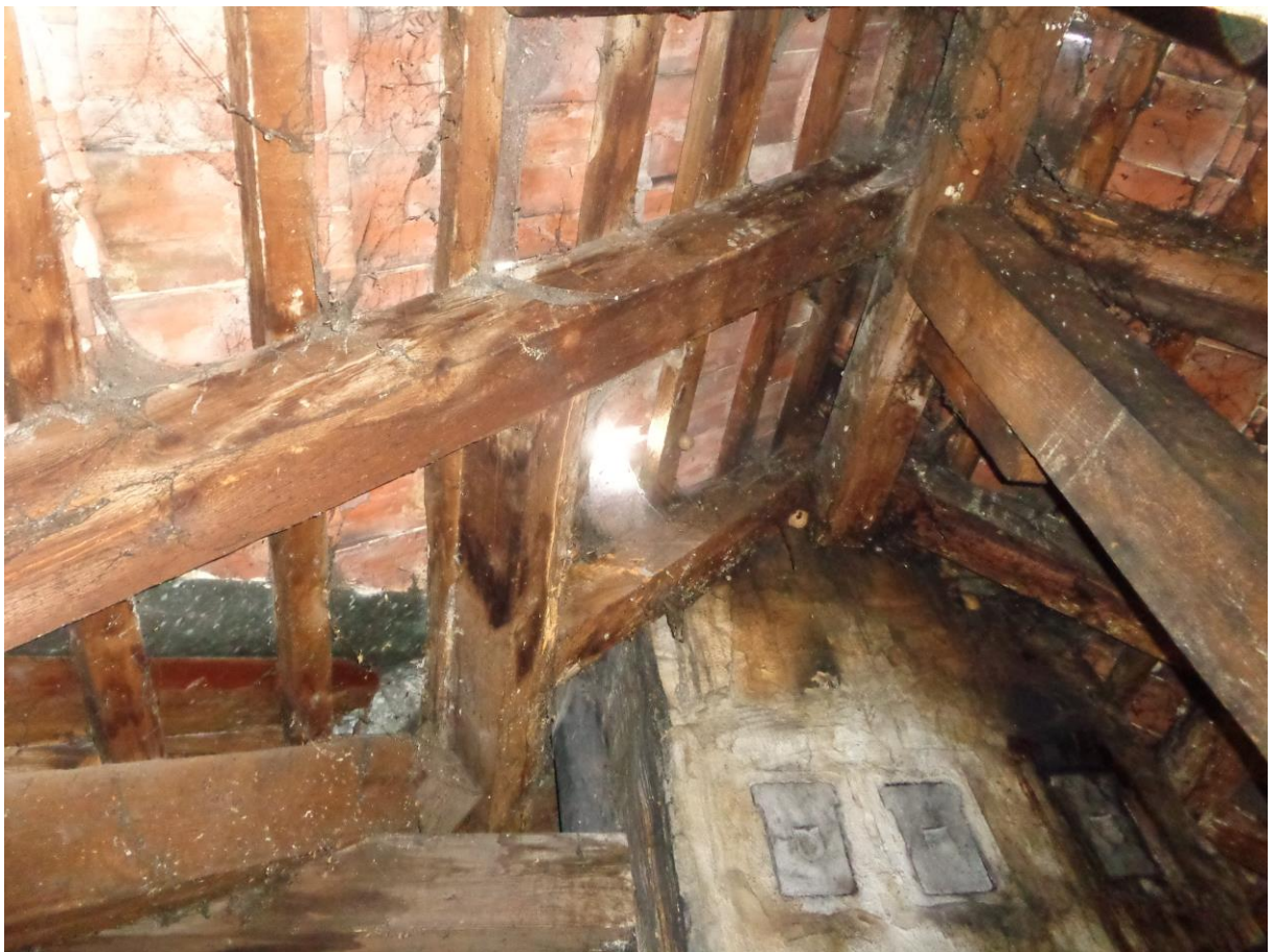
Zacieki na kominach, prześwity w dachu.
