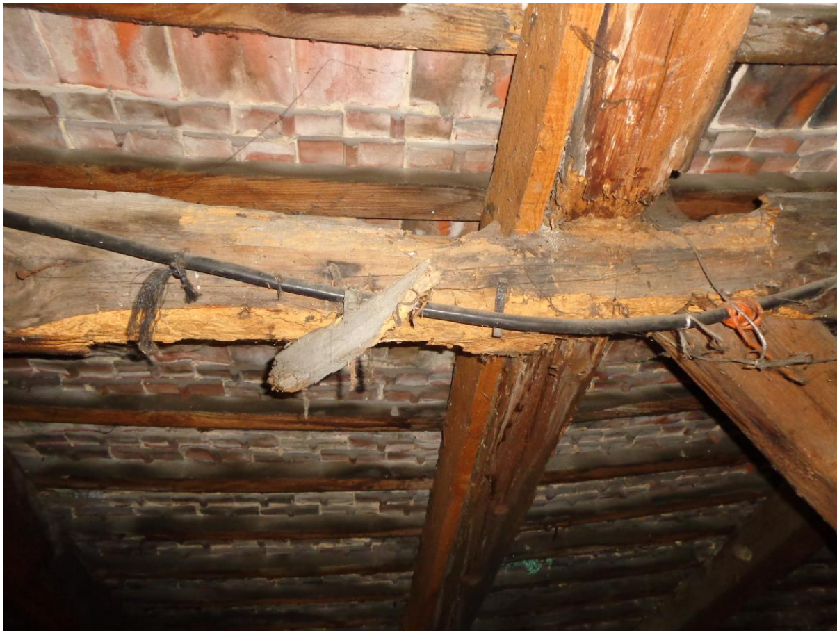
Porażenia więźby dachowej.
