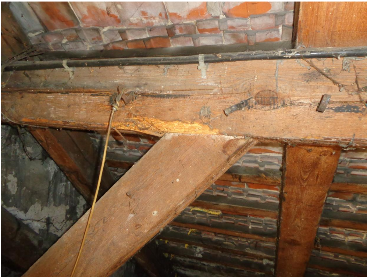
Porażenie więźby dachowej.
