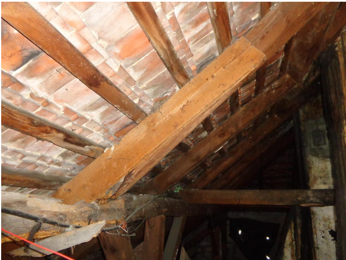
Porażenia więźby dachowej.
