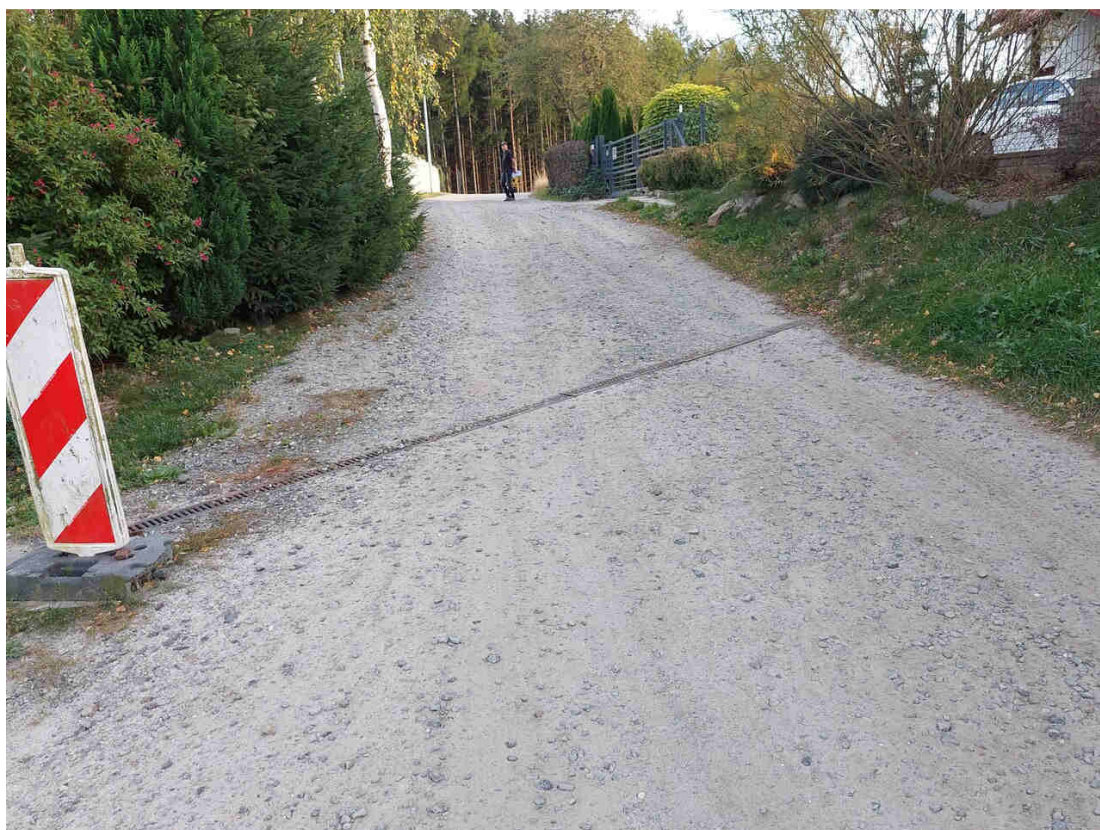
Zdj.38,39 – fragmenty trasy o nawierzchni z mieszanki mineralno-kamiennej oraz elementy odwodnienia
