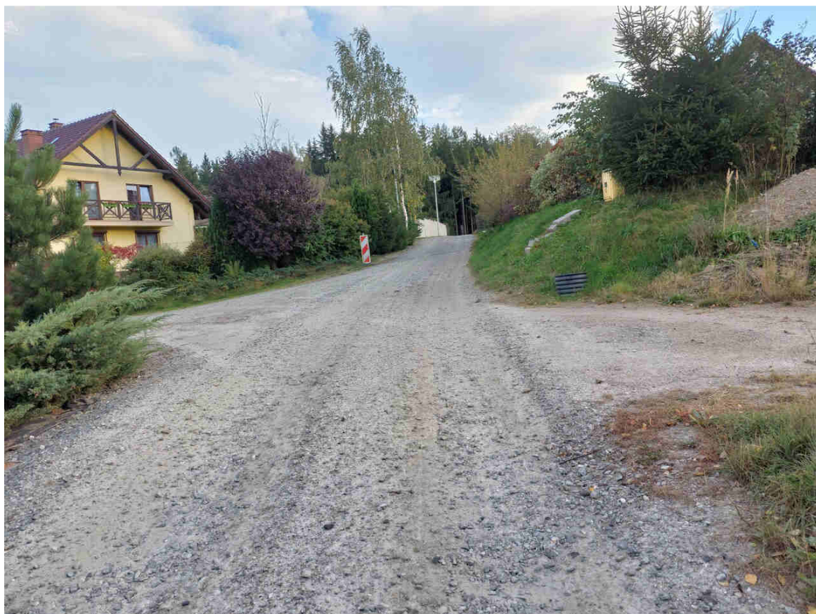
Zdj.30,31– fragmenty trasy o nawierzchni z mieszanki mineralno-kamiennej
