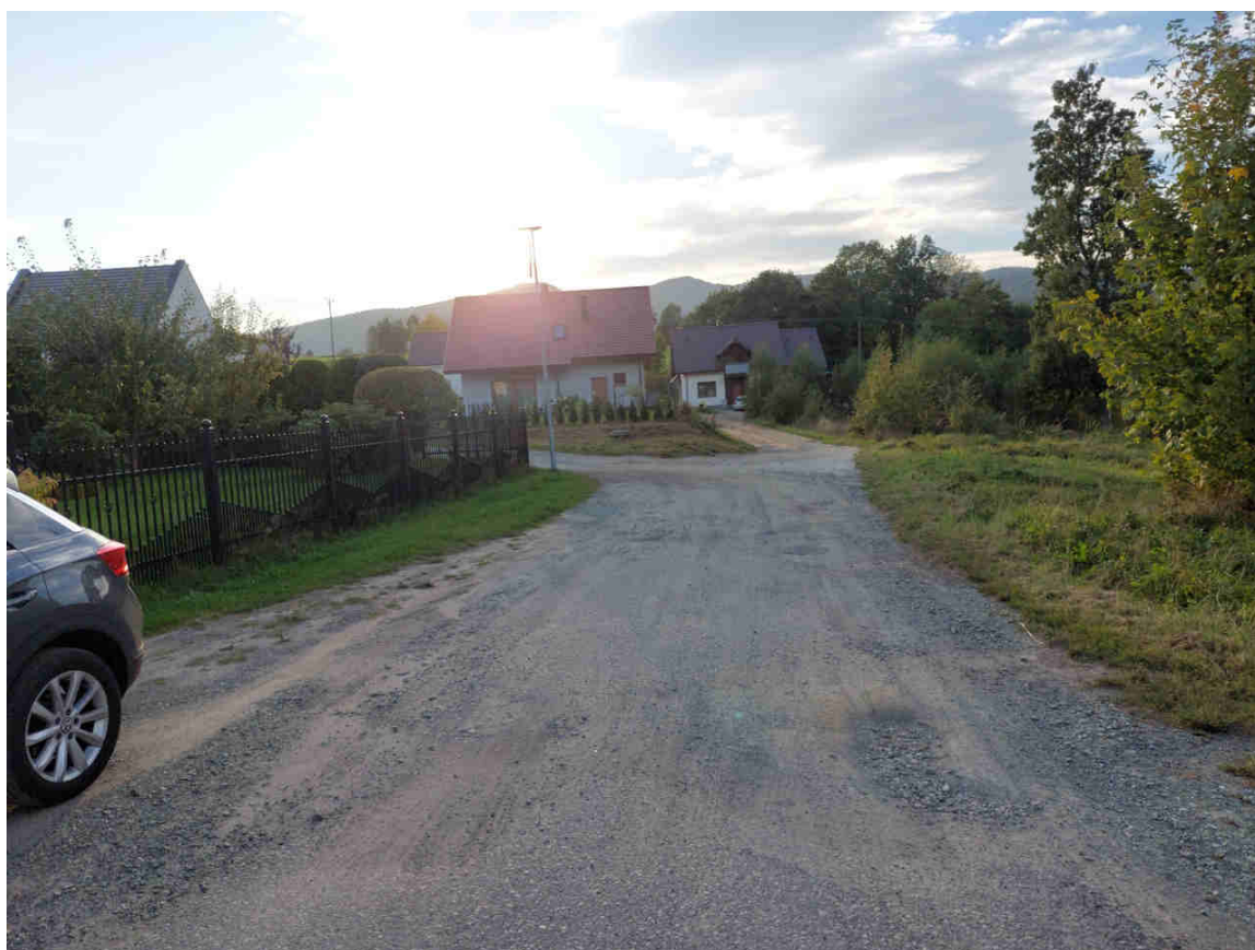
Zdj.27,28 – fragmenty trasy o nawierzchni bitumicznej przechodzący w nawierzchnię z kruszywa
