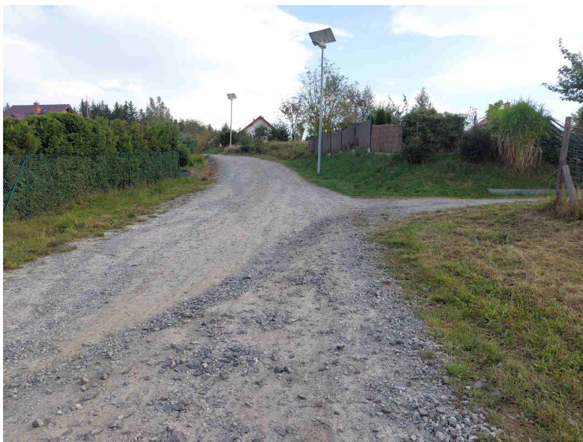
Zdj.28,29 – fragmenty trasy o nawierzchni z mieszanki mineralno-kamiennej
