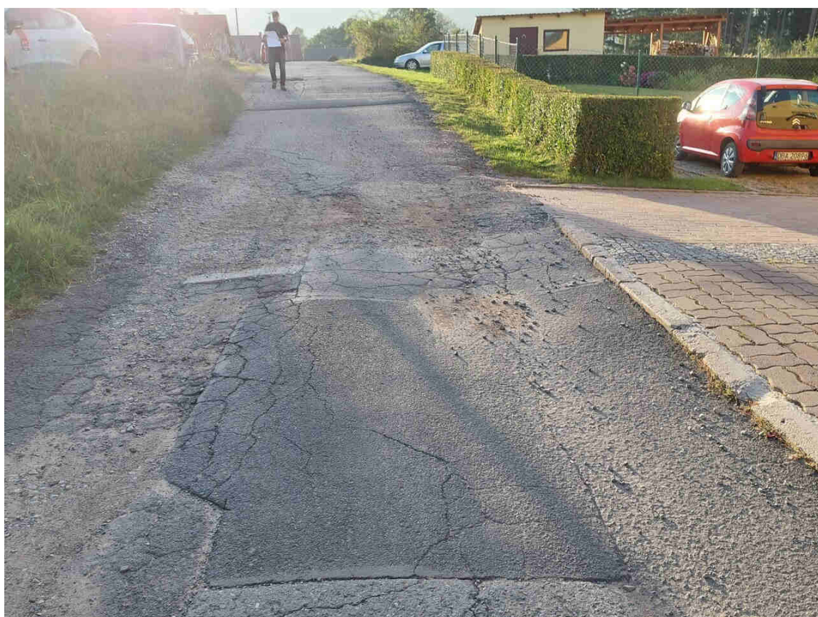
Zdj.17,18 – fragmenty trasy o nawierzchni bitumicznej oraz nawierzchnie istniejących
