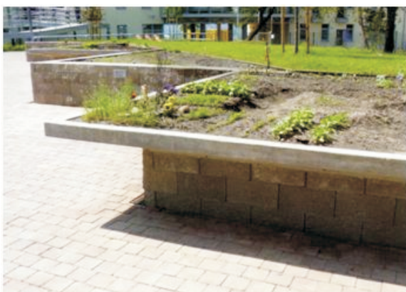
Ryc. 9.15. Stanowisko z roślinami dostosowane do potrzeb osób poruszających się na wózkach inwalidzkich. (Źródło: Samova 2008, s.91)
