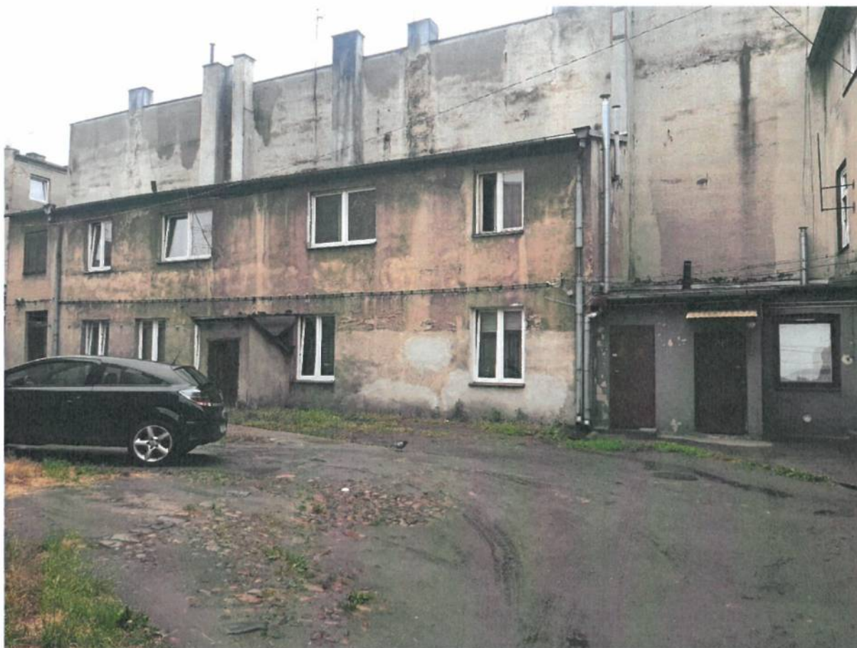
FOT 2 – Budynek przy ul. Dąbrowskiego 2 - oficyna (fot. własna)
