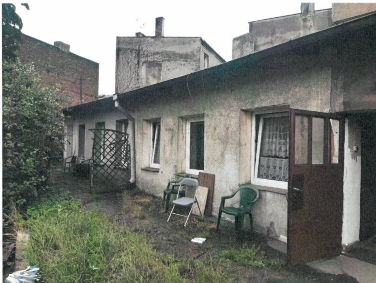
FOT 5 – Budynek przy ul. Dąbrowskiego 4 - oficyna (fot. własna)
