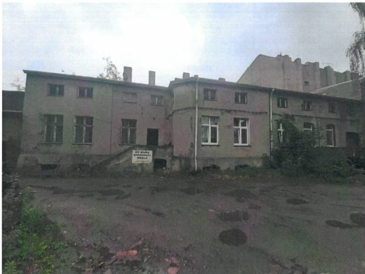
FOT 17 – Budynek przy ul. Dąbrowskiego 31 - oficyna (fot. własna)
