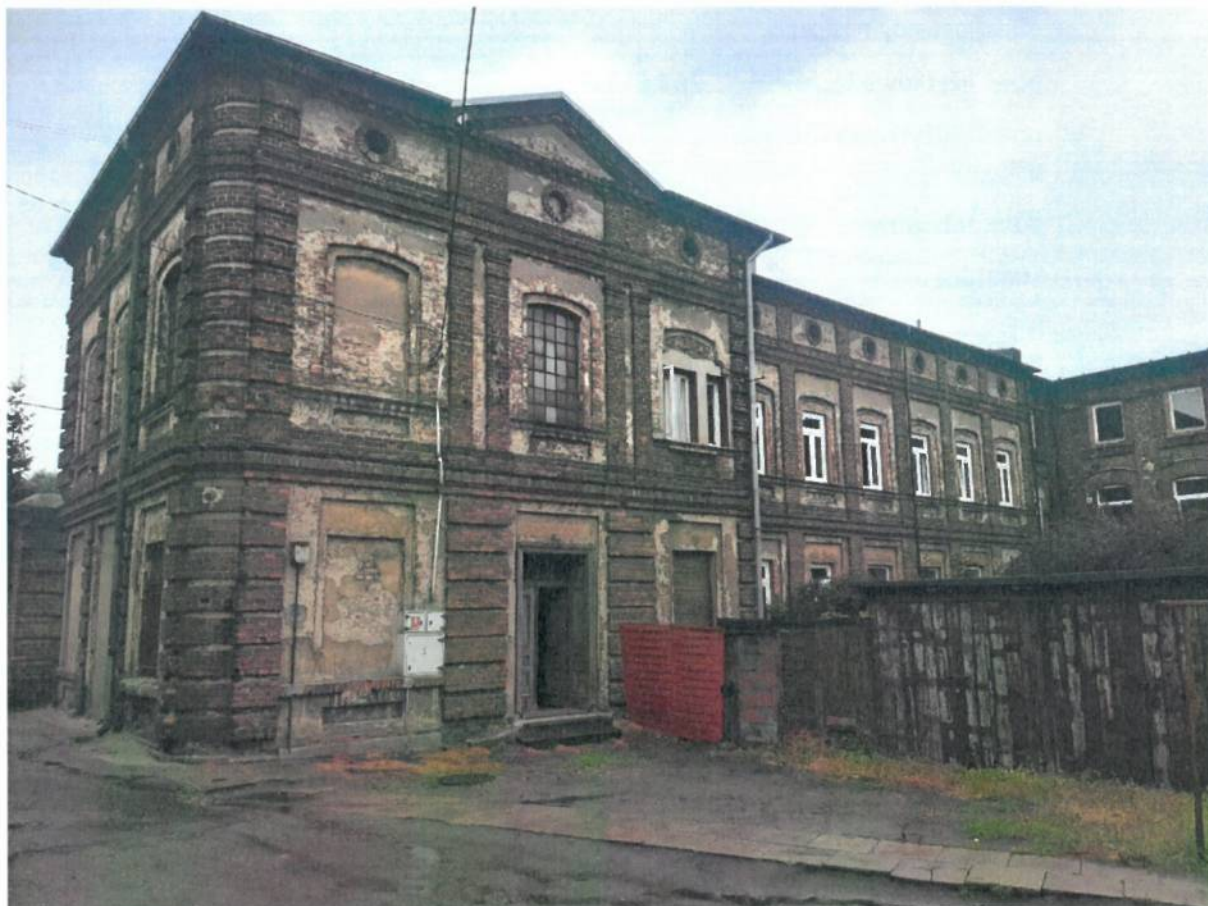
FOT 11 – Budynek przy ul. Dąbrowskiego 23 - oficyna (fot. własna)
