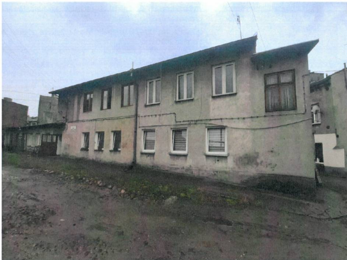
FOT 6 – Budynek przy ul. Dąbrowskiego 4 - oficyna (fot. własna)
