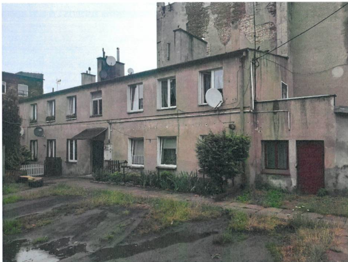
FOT 10 – Budynek przy ul. Dąbrowskiego 23 - oficyna (fot. własna)
