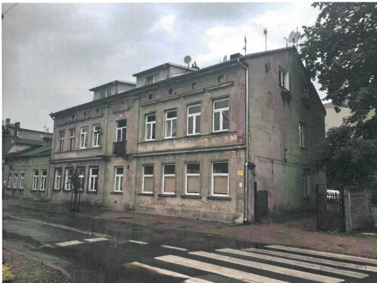
FOT 21 – Budynek przy ul. Dąbrowskiego 37 (fot. własna)
