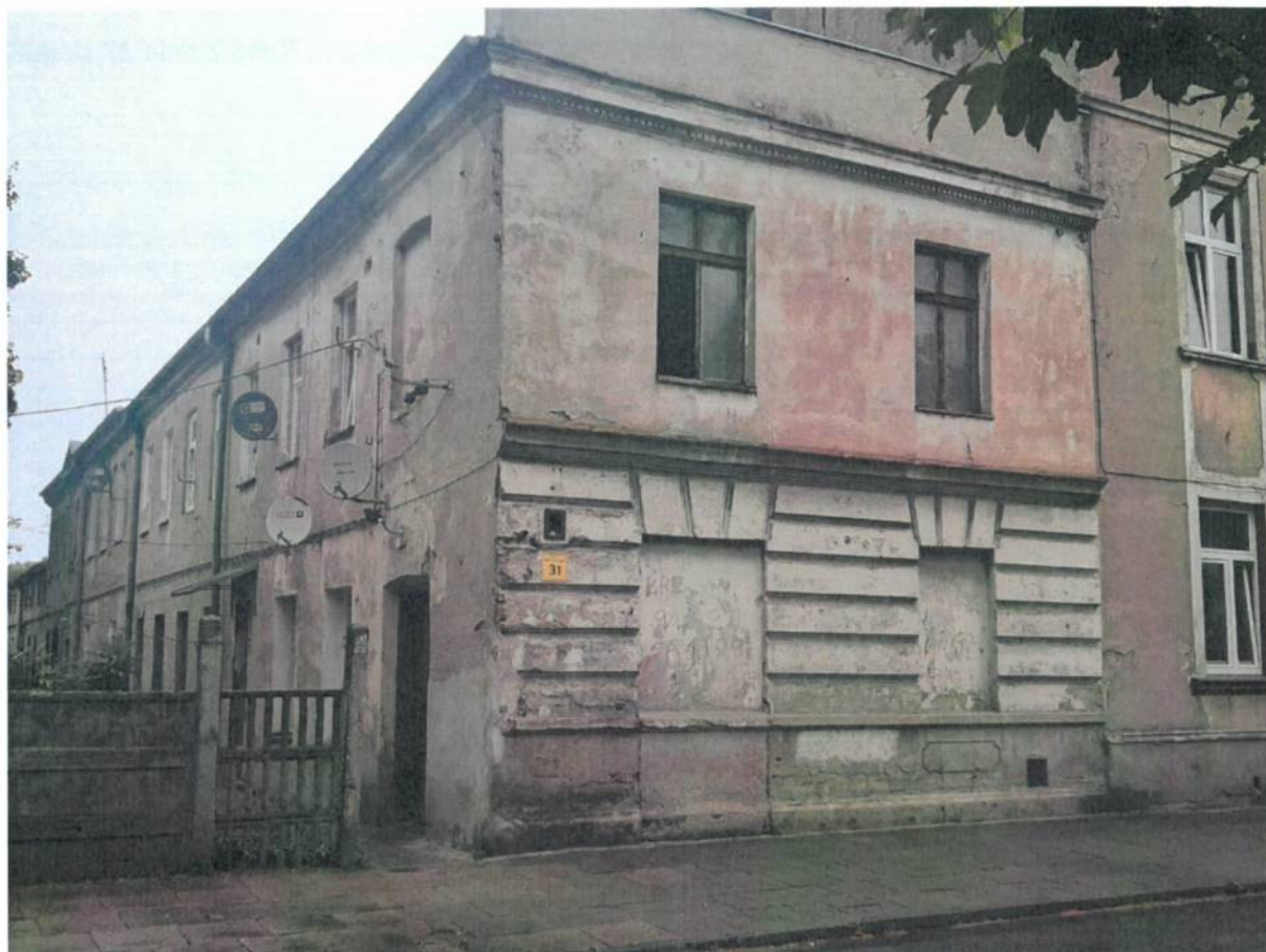
FOT 16 – Budynek przy ul. Dąbrowskiego 31 - oficyna (fot. własna)
