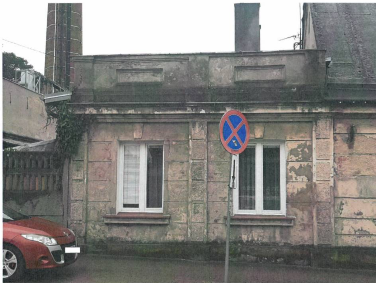
FOT 4 – Budynek przy ul. Dąbrowskiego 4 - oficyna (fot. własna)
