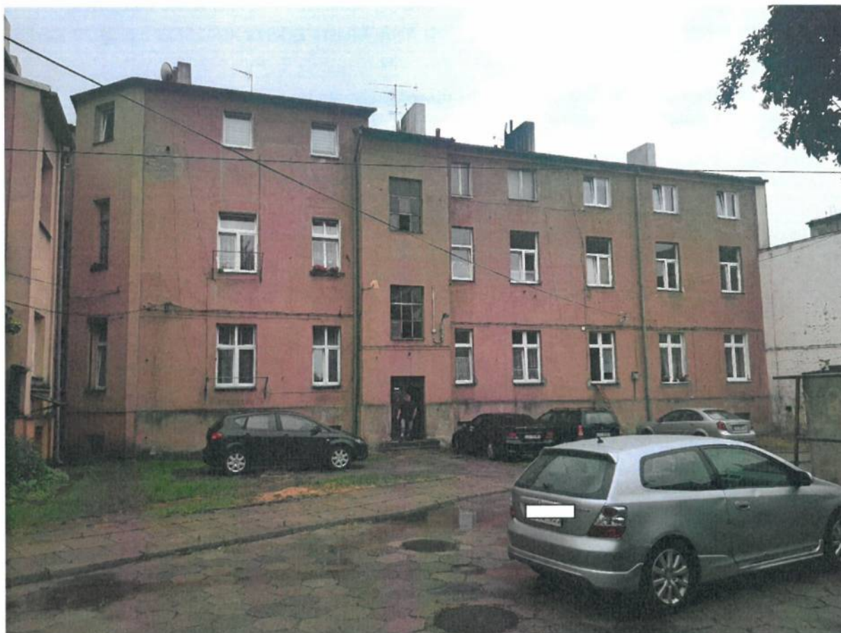
FOT 19 – Budynek przy ul. Dąbrowskiego 33 - oficyna (fot. własna)
