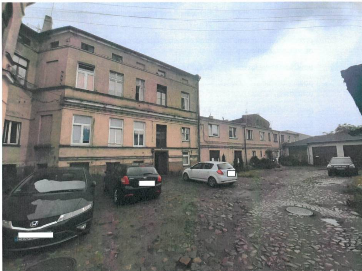
FOT 13 – Budynek przy ul. Dąbrowskiego 25 - oficyna (fot. własna)
