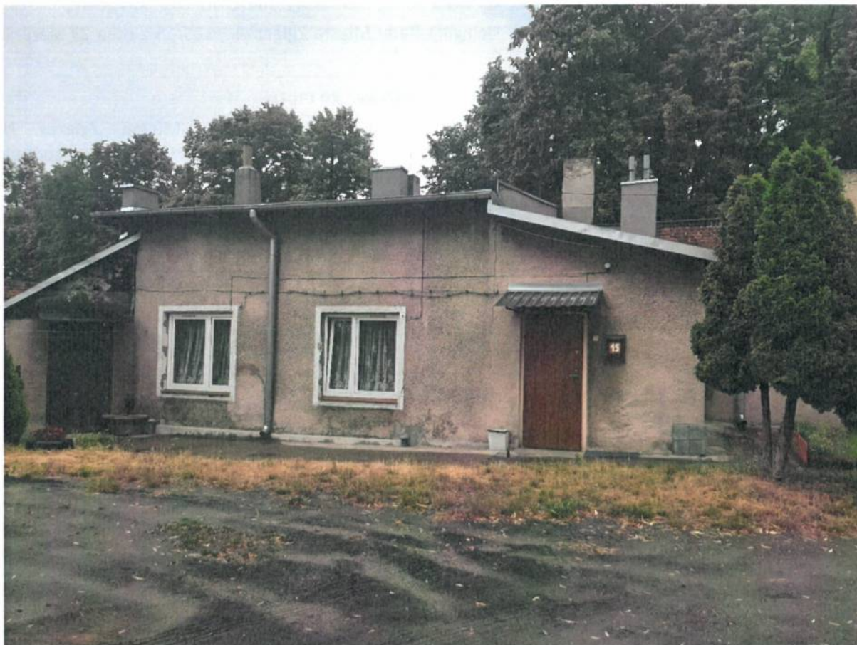
FOT 8 – Budynek przy ul. Dąbrowskiego 11 - oficyna (fot. własna)
