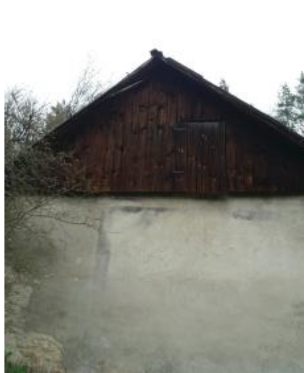
Ściana szczytowa z kamienia w części obory
