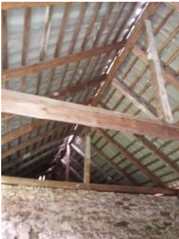
Brak obróbki kalenicy, stan więźby dachowej
