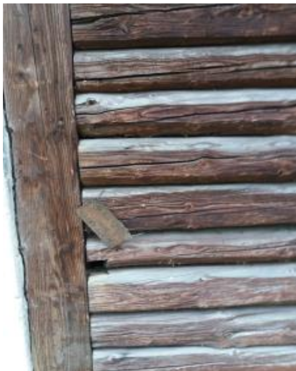
Wypełnienie ścian między filarami
