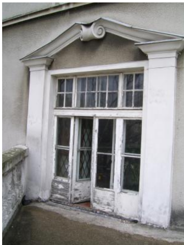
F 12 - Zniszczone okno w budynku AB
