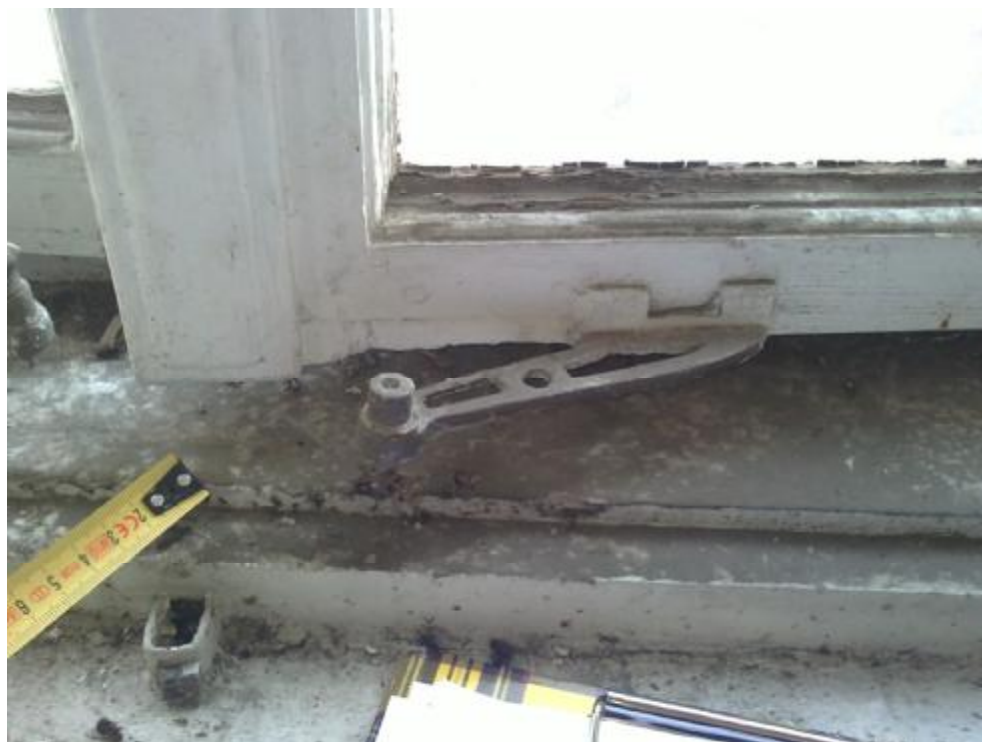
F 16 - Zachowane okucia w oknie w budynku C
