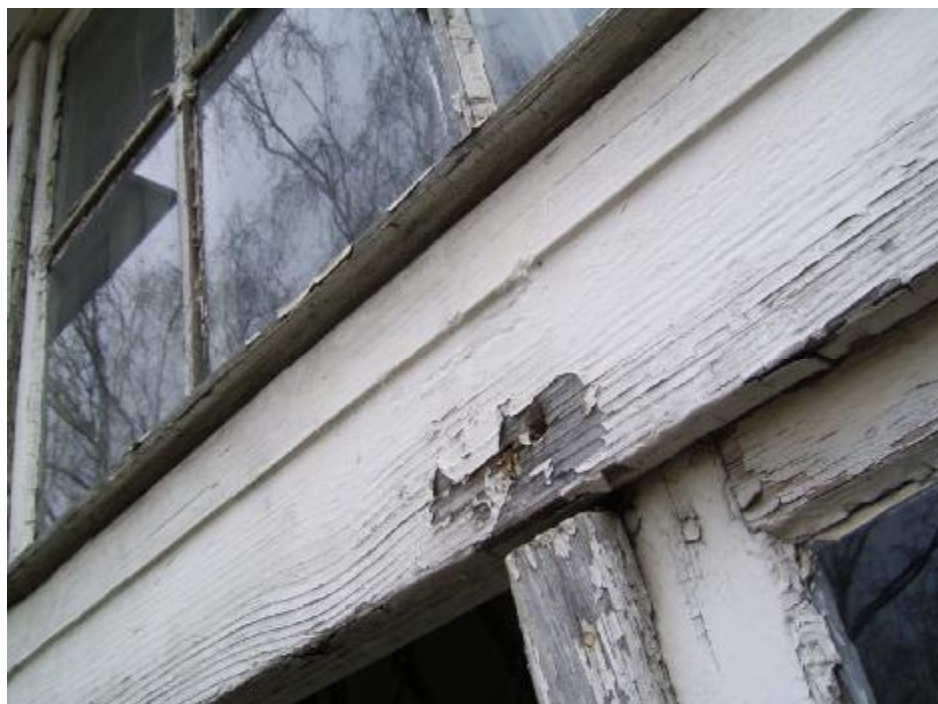
F 14 Zniszczenia okna w budynku AB
