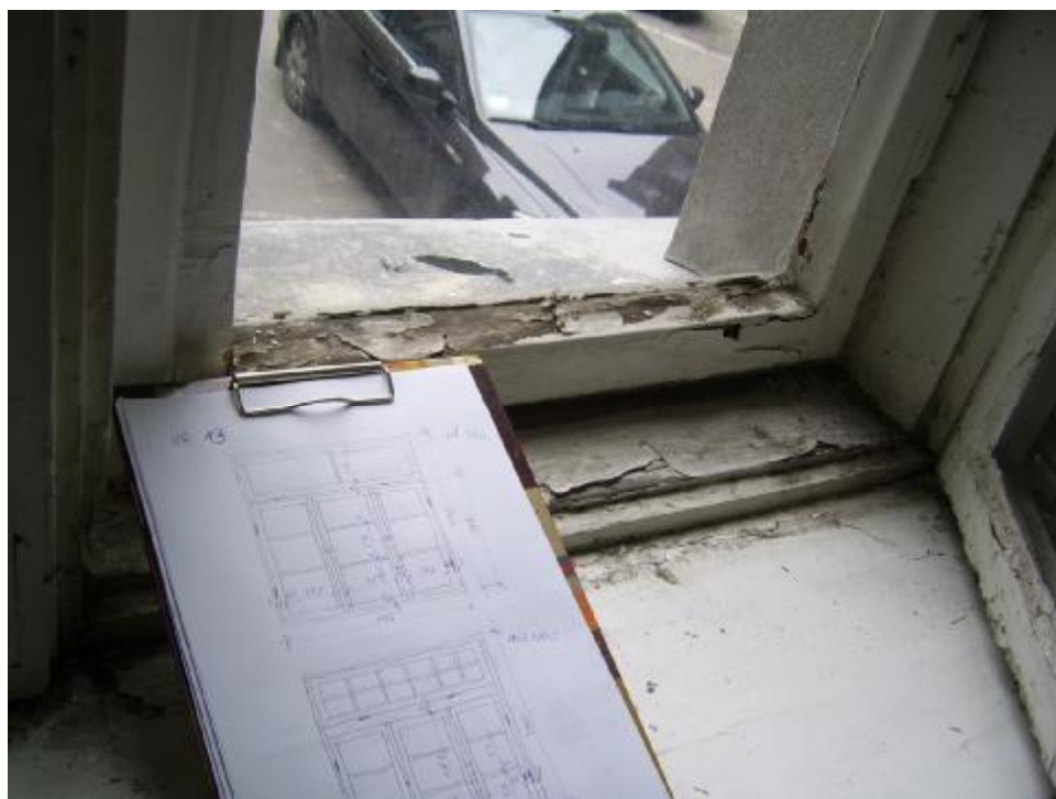
F 11 - Zniszczone okno w budynku AB
