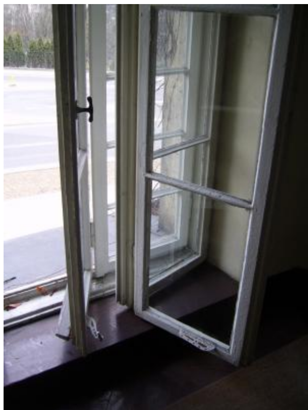
F 9 - Okno z zachowanymi okuciami - widoczne zniszczenia powłoki lakierniczej
