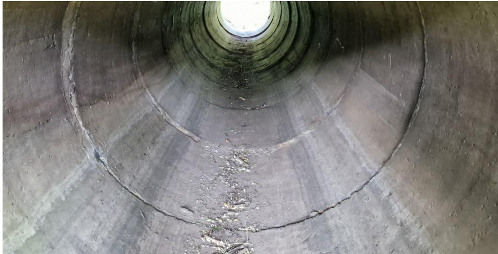
Rys. 3.3 Widok w środku przepustu – widoczne uszczelnienie pomiędzy segmentami
