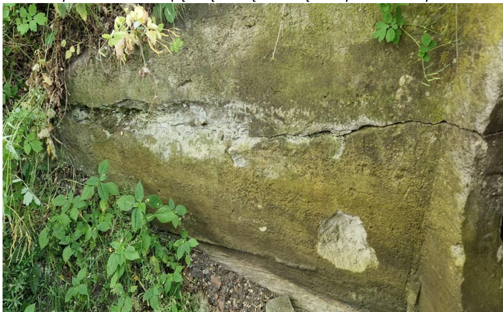
Rys. 3.5 Widok na spękaną skrzydło od strony WD
