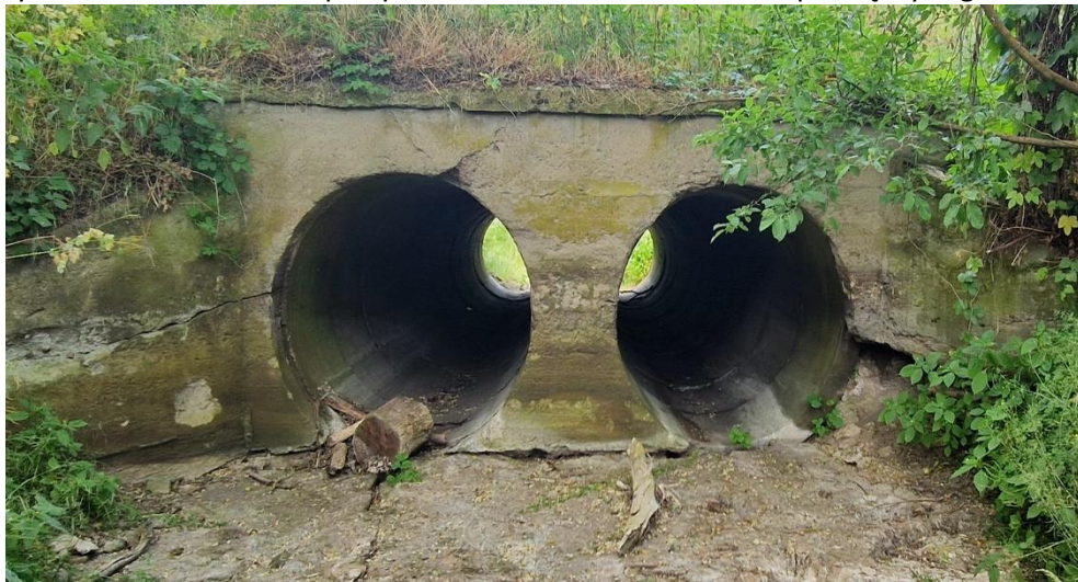
Rys. 3.4 Widok na spękaną ścianę czołową i skrzydła od strony WD
