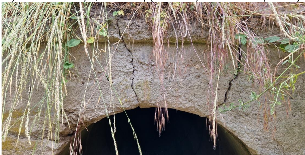
Rys. 3.1 Widok na spękaną ścianę czołową od strony WG
