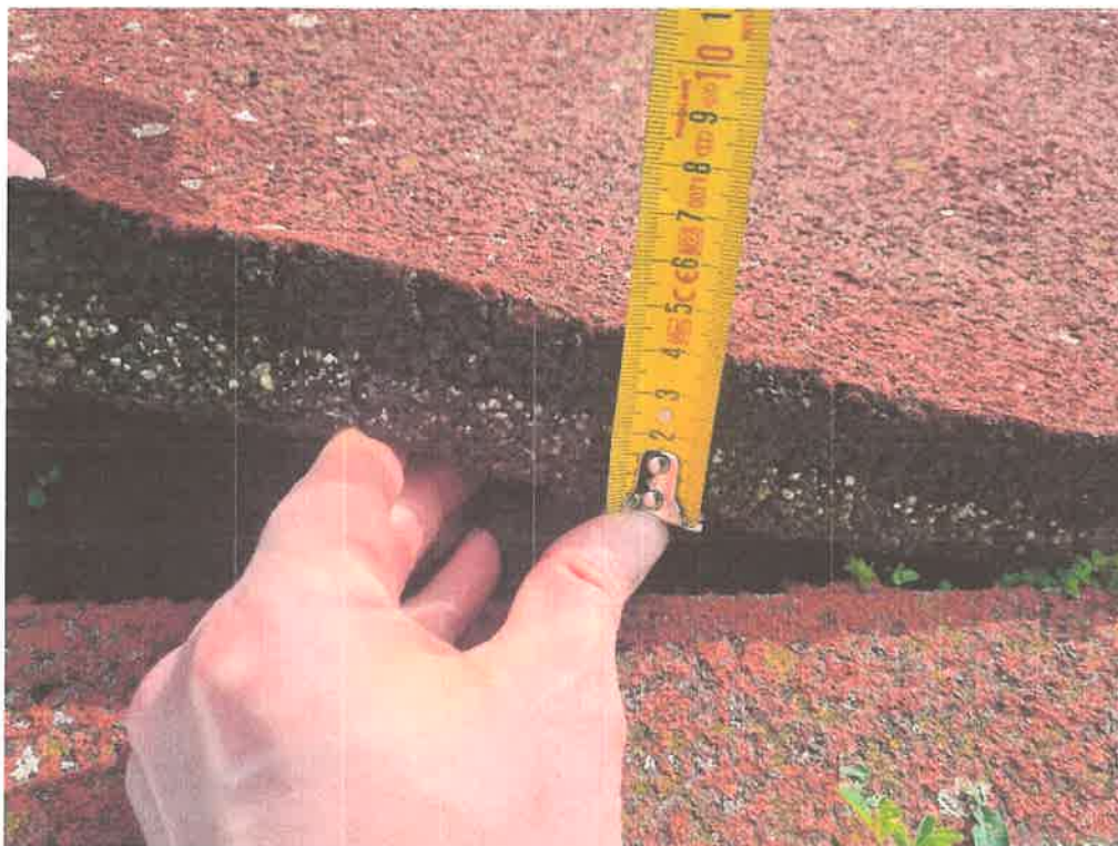
Fot. 5 Przekrój nawierzchni
