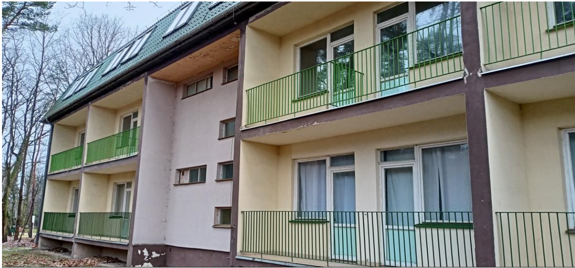
Zdjęcie nr 2: elewacja tylna budynku
