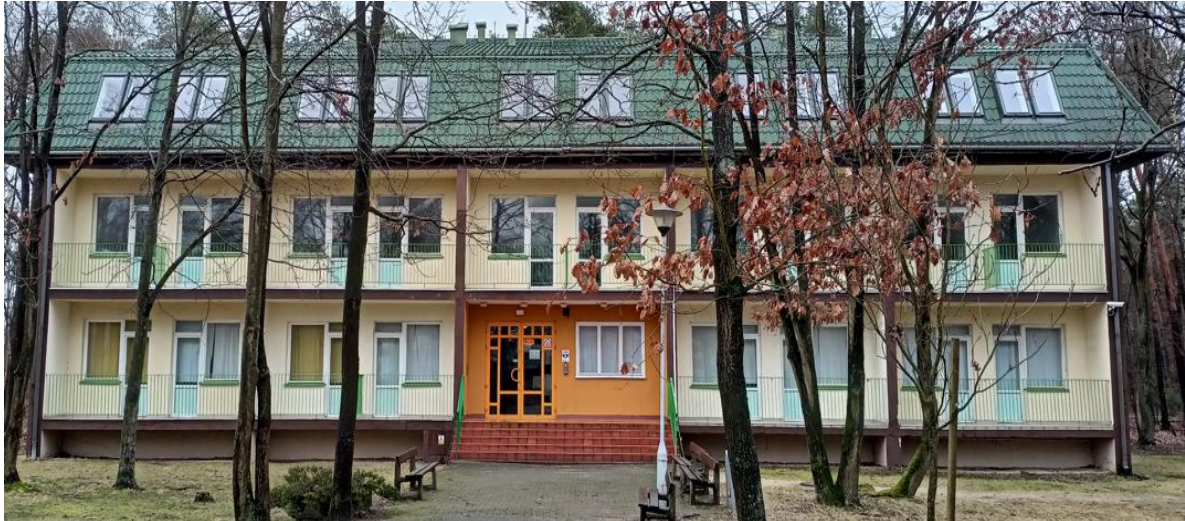
Zdjęcie nr 1: elewacja przednia budynku
