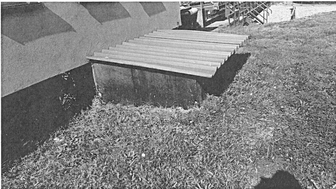
Fot. nr5 – Budynek krat Ob. nr 3 – elewacja wsch.
