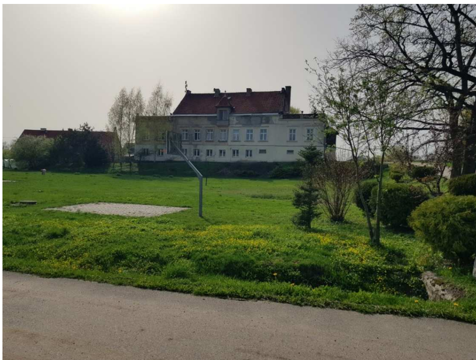
Fotografia nr 2 Widok terenu inwestycji od strony wschodniej (z dz. nr 7/26) – stan istniejący
