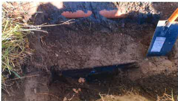
Fot. 4, 5 Odkryta płyta fundamentowa
