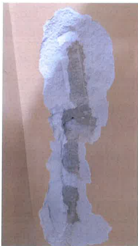
Fot. 8 Odkuty tynk na ścianie
