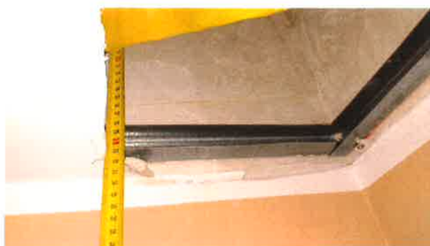
Fot. 6, 7 Odkrywka nad sufitem z płyty G-K
