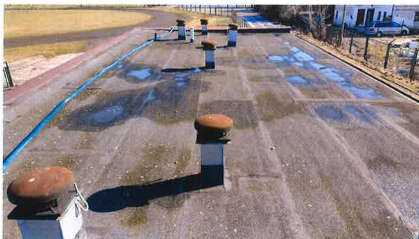
Fot. 3 Widok dachu
