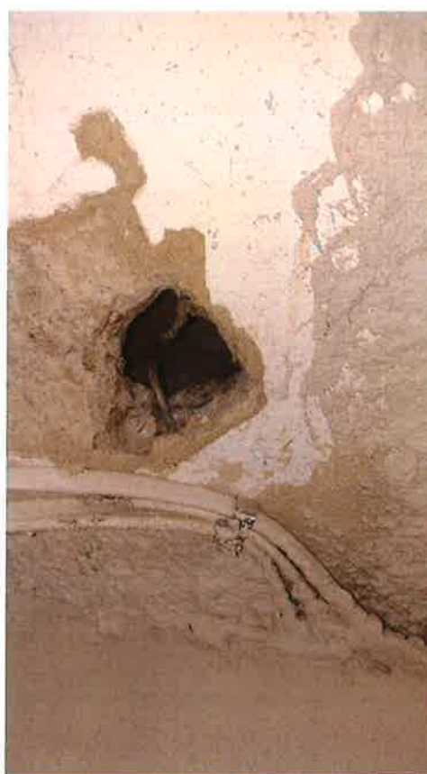
Fot. 9 Kanał płyty żelbetowej stropowej
