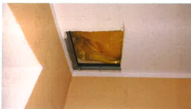
Fot. 6, 7 Odkrywka nad sufitem z płyty G-K
