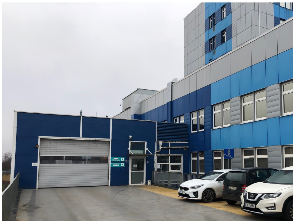
Fot. Nr 1 - Rodzaj nawierzchni drogi oraz chodnika – do przełożenia
