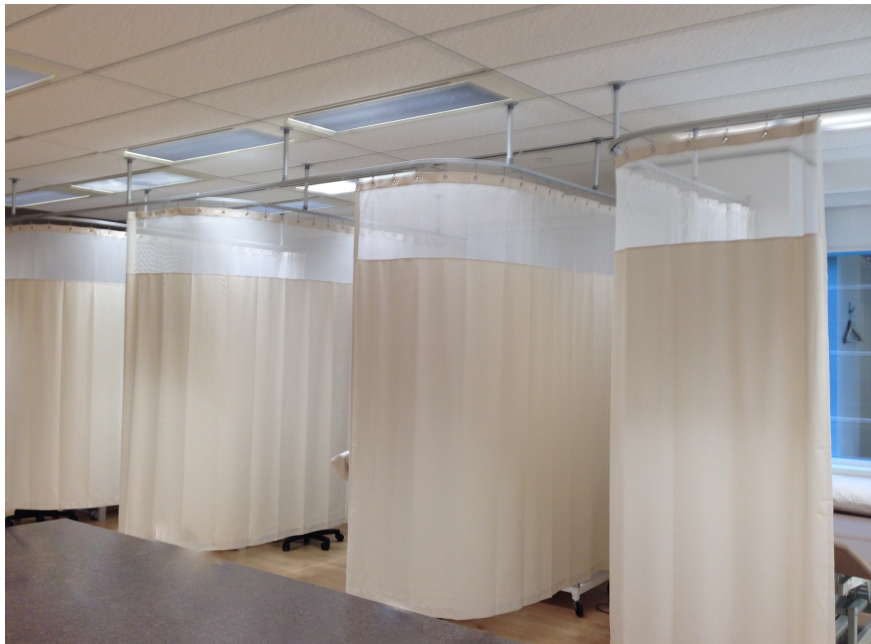
Rys. nr 7 – System parawanów sufitowych pozwalający na oddzielenie stanowisk łóżkowych
