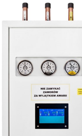
Fot. – Podtynkowy zestaw kontrolno-pomiarowy gazów medycznych
