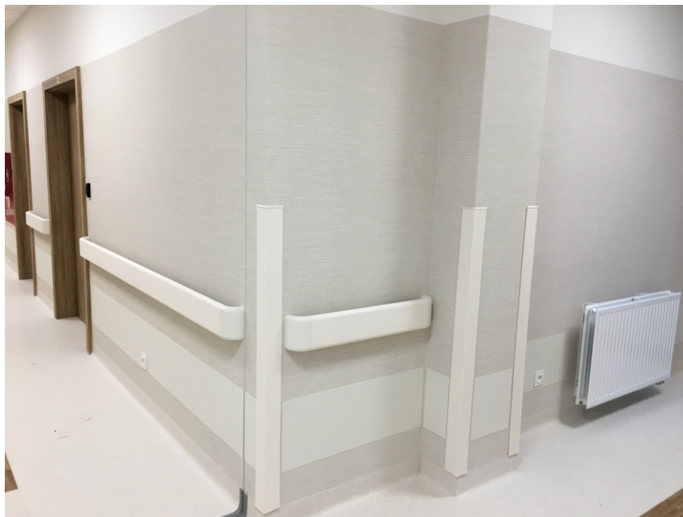
Rys. nr 9 – zabezpieczenie ścian przed uderzeniami
