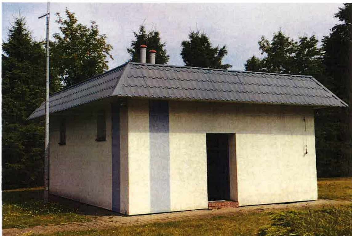
Fotografia 2. Studnie nr 2 i nr 3 na terenie SUW Sątopy
