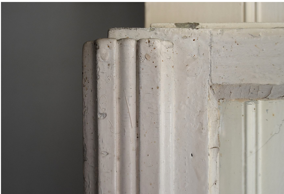
Il. 15 Grudziądz, Kamienica przy ul. Pańskiej 2/ ul. Reja 1- elewacja północna (parter) - pierwotna stolarka TYP O/IA – widok na fragment listwy przymykowej wewnętrznej
