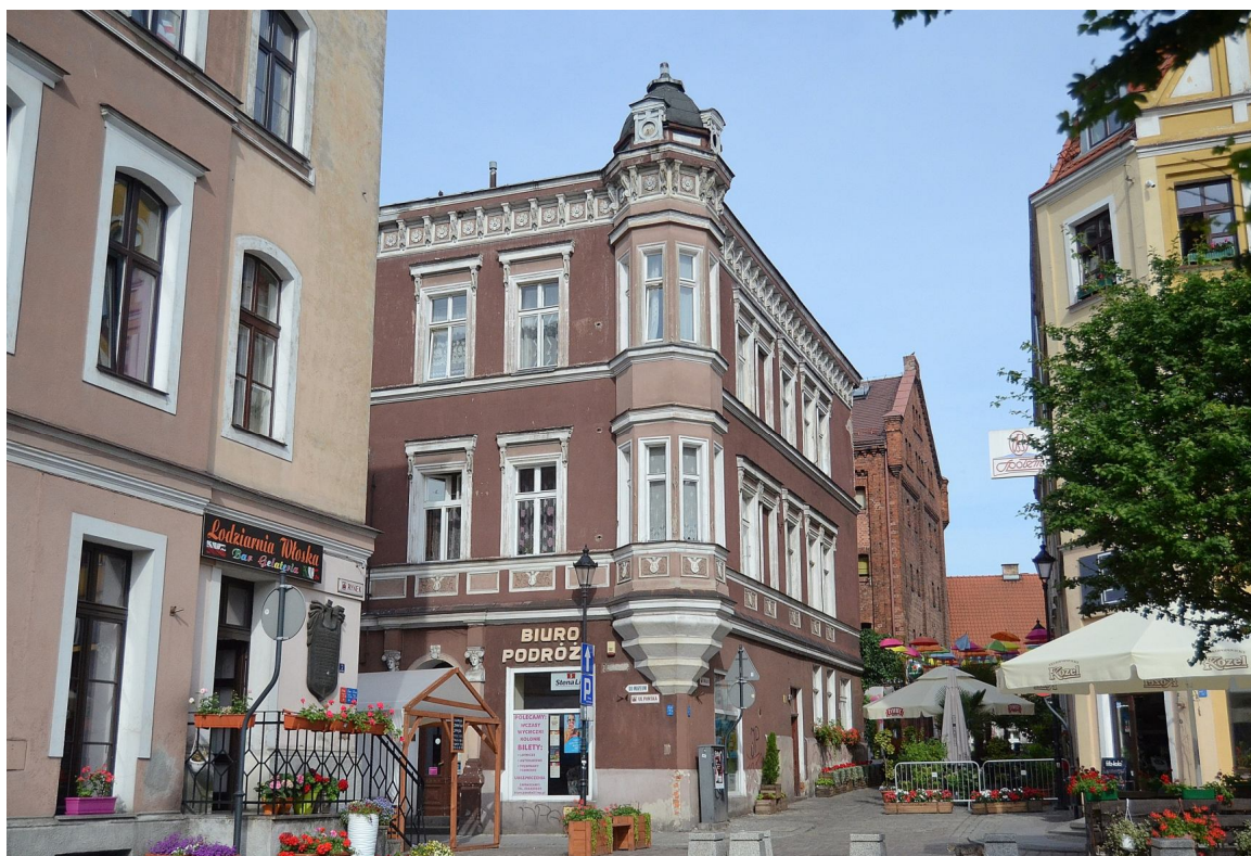
Il. 1 Grudziądz, Kamienica przy ul. Pańskiej 2/ ul. Reja 1 - widok na północną i wschodnią elewację kamienicy
