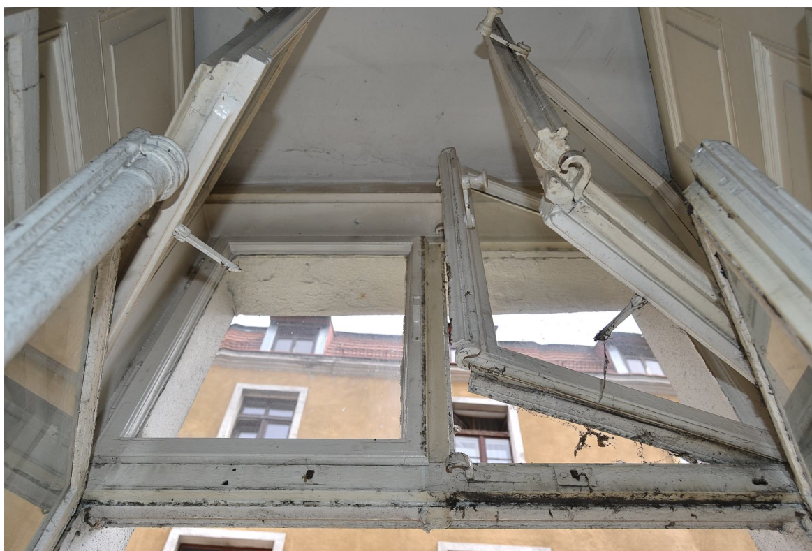
Il. 13 Grudziądz, Kamienica przy ul. Pańskiej 2/ ul. Reja 1 - elewacja północna (parter) - pierwotna stolarka TYP O/IA – widok na nadślepię stolarki
