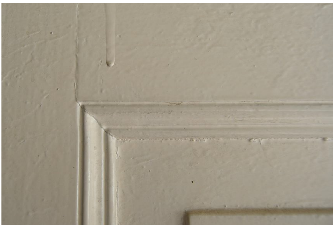
Il. 24 Grudziądz, Kamienica przy ul. Pańskiej 2/ ul. Reja 1- elewacja północna (parter) - pierwotna stolarka TYP O/IA – widok na profilowanie ramiaka okiennicy
