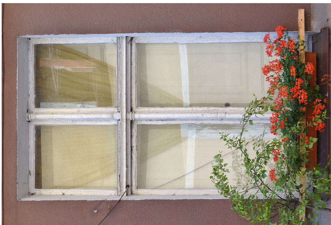
II. 5 Grudziądz, Kamienica przy ul. Pańskiej 2/ ul. Reja 1 - elewacja północna (parter) - stolarka TYP O/IA – widok na pierwotną stolarkę okienną - awers
