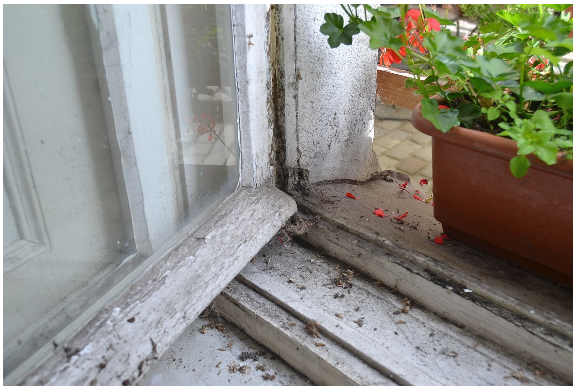
Il. 8 Grudziądz, Kamienica przy ul. Pańskiej 2/ ul. Reja 1- elewacja północna (parter) - pierwotna stolarka TYP O/IA – widok na fragment progu skrzynki oraz skrzydła okiennego
