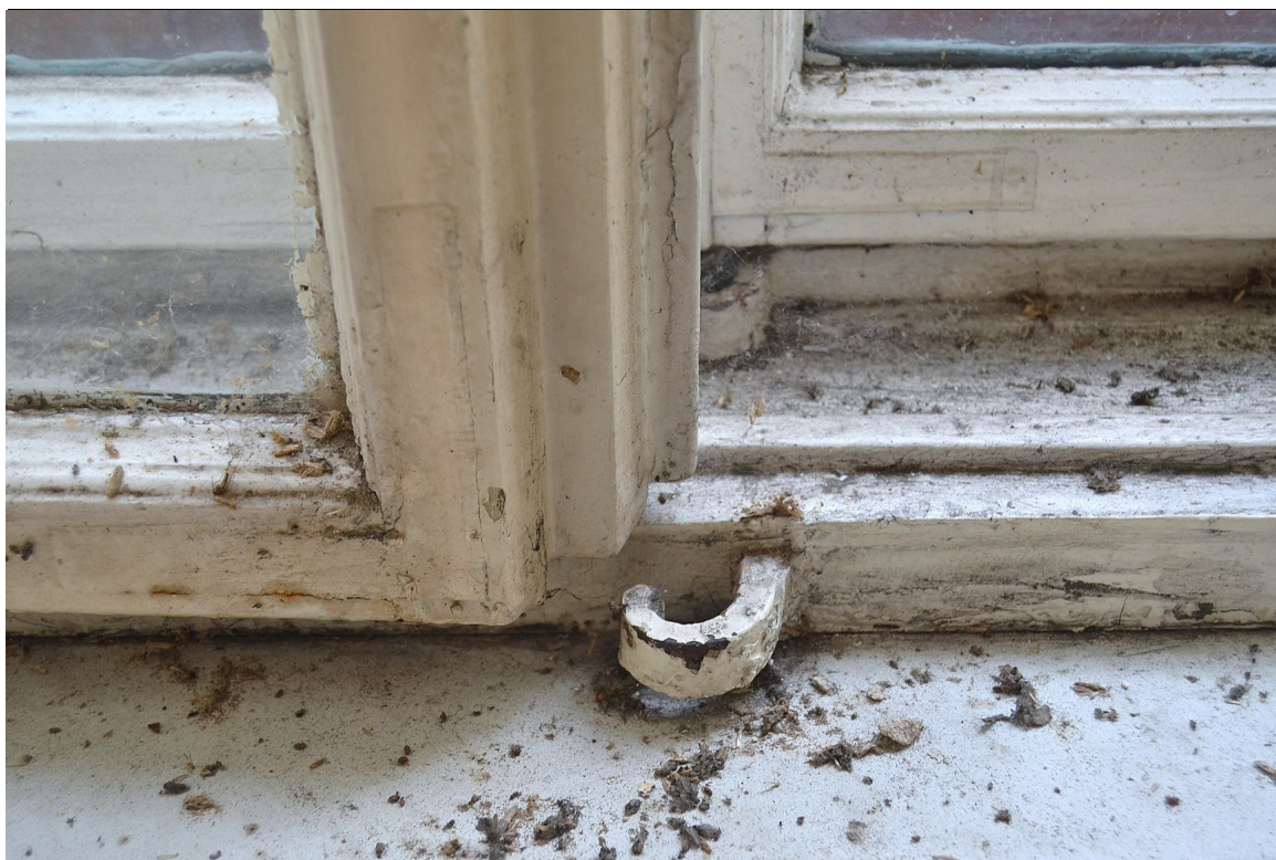
Il. 16 Grudziądz, Kamienica przy ul. Pańskiej 2/ ul. Reja 1- elewacja północna (parter) - pierwotna stolarka TYP O/IA – widok na próg skrzynki, skrzydło oraz hak zawrotnicy
