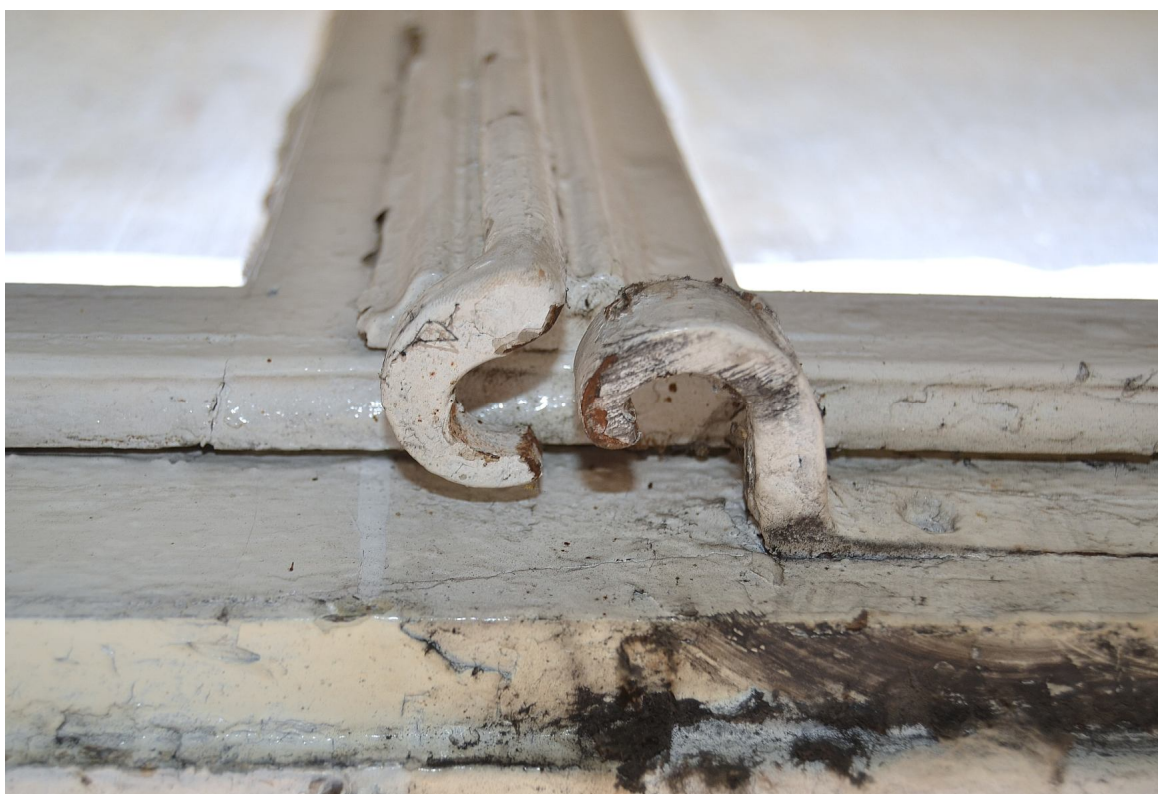
Il. 21 Grudziądz, Kamienica przy ul. Pańskiej 2/ ul. Reja 1- elewacja północna (parter) - pierwotna stolarka TYP O/IA – widok na haki zawrotnicy
