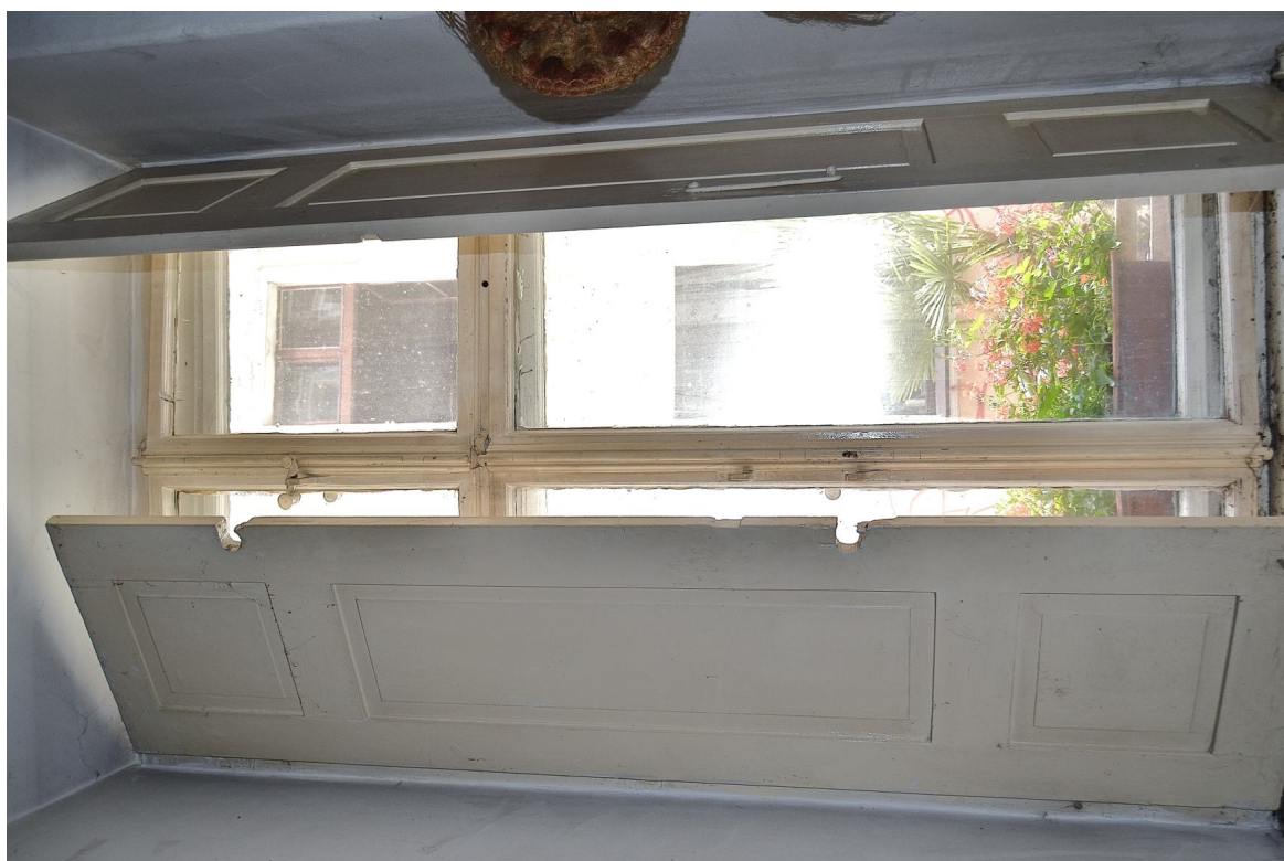
II. 6 Grudziądz, Kamienica przy ul. Pańskiej 2/ ul. Reja 1- elewacja północna (parter) - stolarka TYP O/IA – widok na pierwotną stolarkę okienną - rewers
