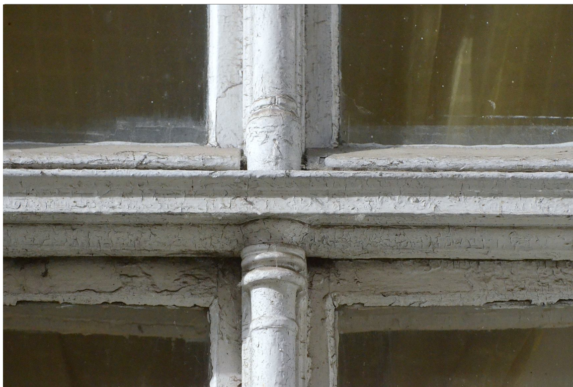
Il. 7 Grudziądz, Kamienica przy ul. Pańskiej 2/ ul. Reja 1- elewacja północna (parter) - stolarka TYP O/IA – widok na fragment półpozornego krzyża okiennego
