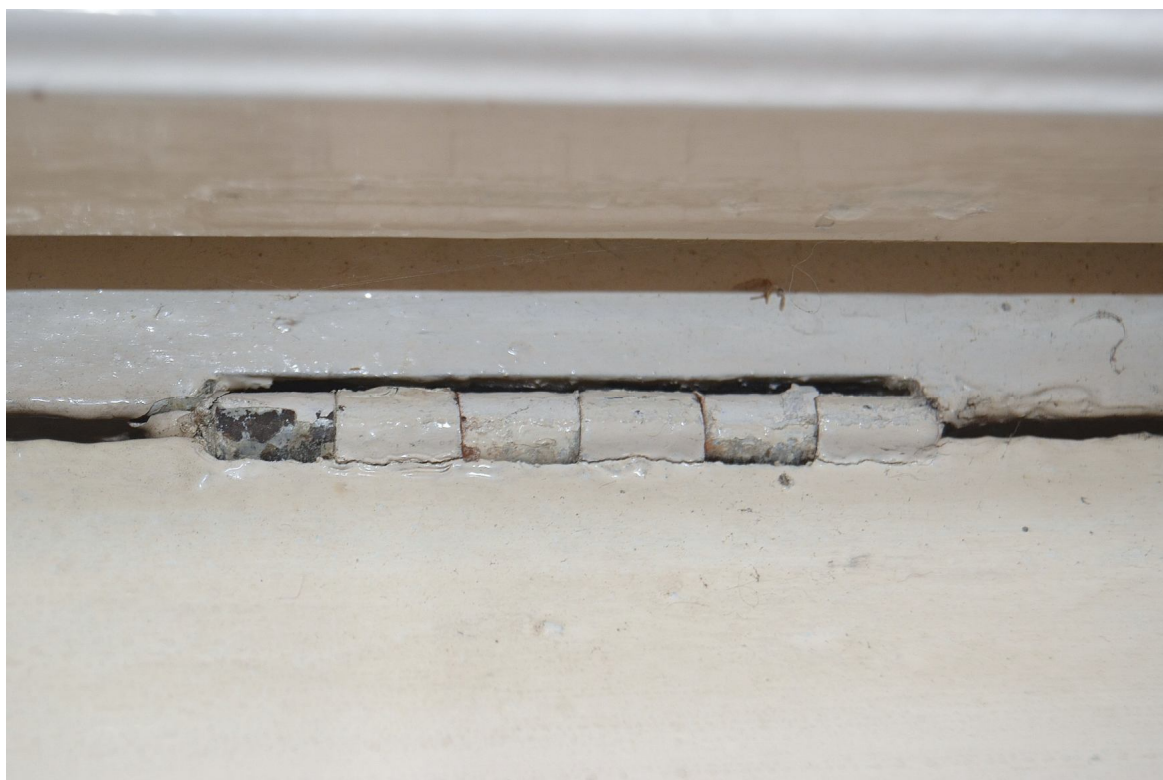
Il. 25 Grudziądz, Kamienica przy ul. Pańskiej 2/ ul. Reja 1- elewacja północna (parter) - pierwotna stolarka TYP O/IA – widok na zawias czopowy splatany okiennicy
