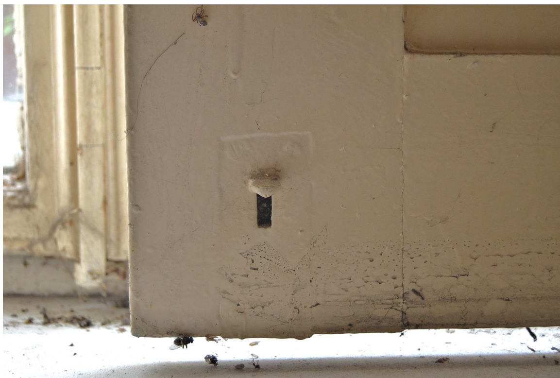
Il. 26 Grudziądz, Kamienica przy ul. Pańskiej 2/ ul. Reja 1- elewacja północna (parter) - pierwotna stolarka TYP O/IA – widok na zasuwkę wpuszczaną okiennicy
