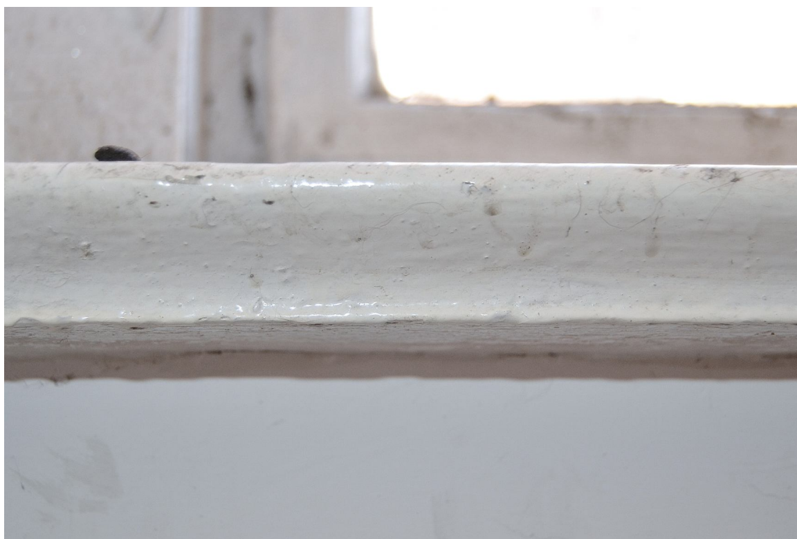
Il. 38 Grudziądz, Kamienica przy ul. Pańskiej 2/ ul. Reja 1- elewacja północna (klatka schodowa) - pierwotna stolarka TYP O/IB – widok na nosek parapetu wewnętrznego
