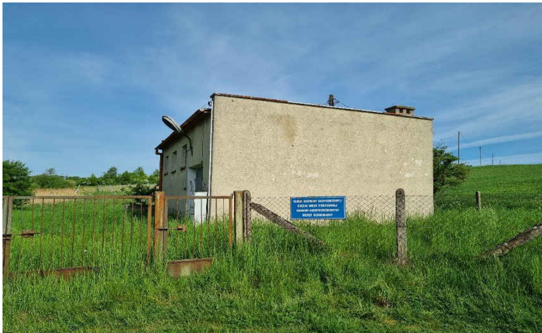
Rys.1 Zdjęcia stanu istniejącego Hydrofornia w Kołowie
