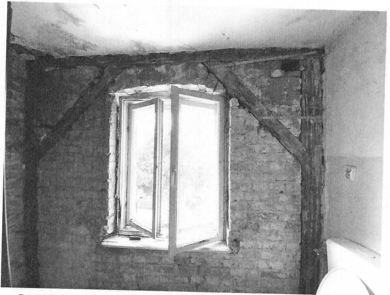
Fot. 2. Widok ogólny pomieszczenia łazienki w m. nr 6
