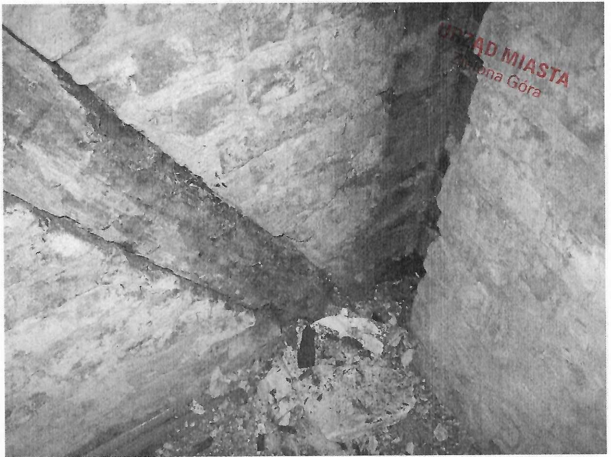
Fot. 5. Zastrzał drewniany w ścianie zewnętrznej pld. i bruzda jako pozostałość po słupie w narożniku łazienki
