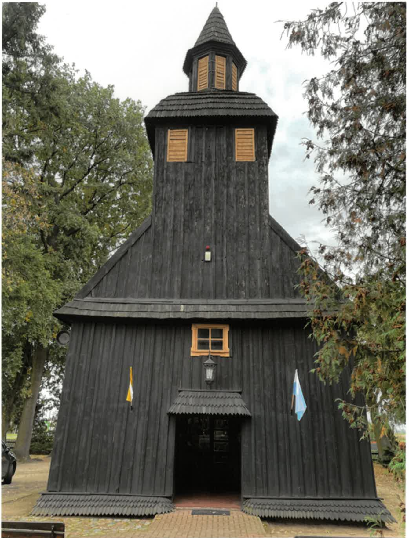
Elewacja północna, frontowa.
