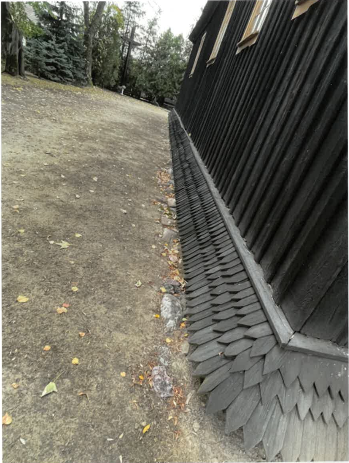
Fragment elewacji zachodniej.
