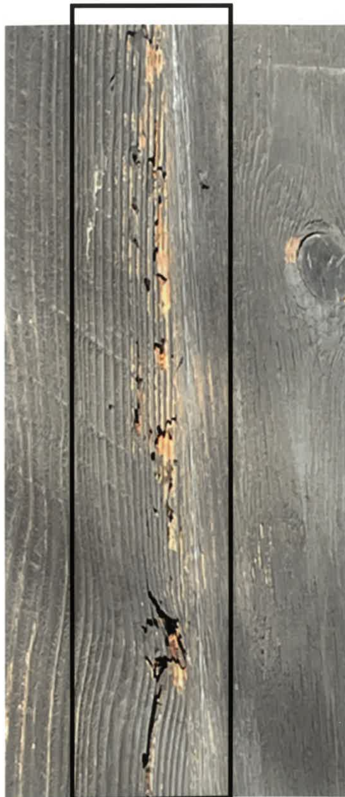
Ślady po żerowaniu drewnojadów. Widoczna osłabiona struktura drewna.
