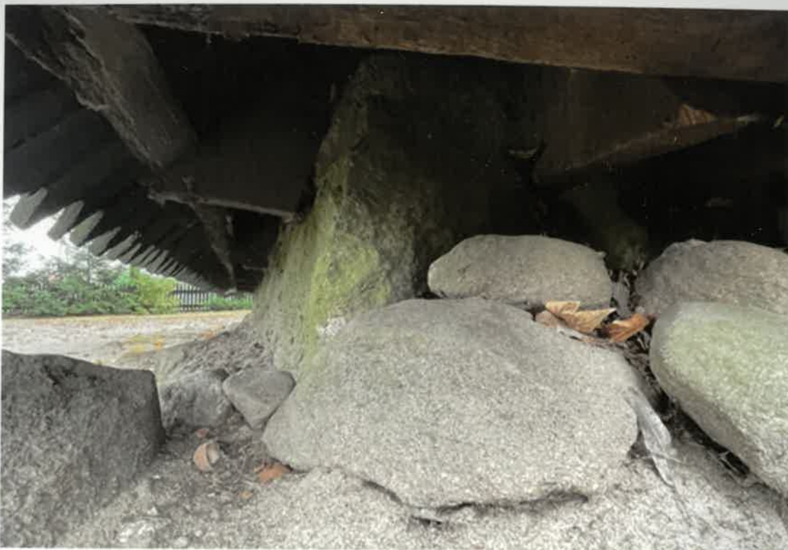
Fartuch gontowy. Widok od wewnętrznej strony.
