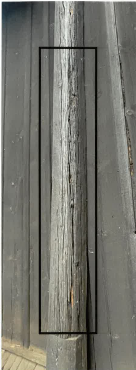
Ślady po żerowaniu drewnojadów. Widoczna osłabiona struktura drewna.
