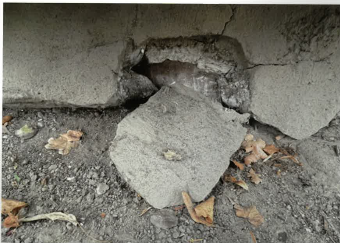
Fragment cokołu kamiennego uzupełnianego zaprawa cementową.
