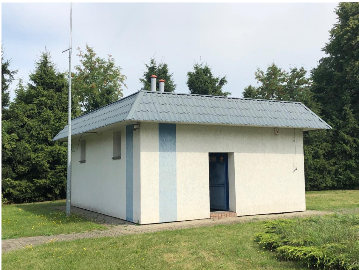
Fot.1 Widok budynku
