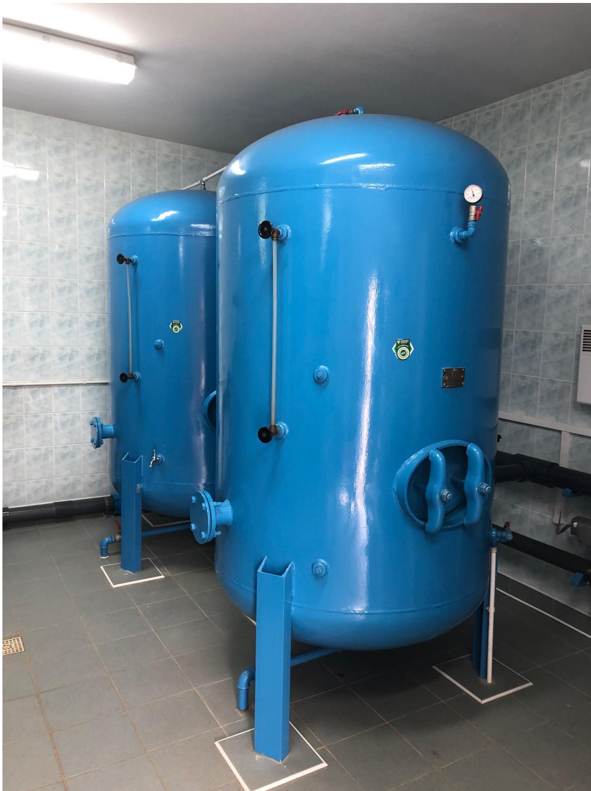
Fot.2 Wnętrze budynku
