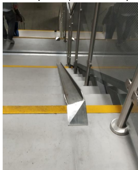
Fotografia 15. Pochylnia zastosowana na dworcu autobusowym w Zielonej Górze Źródło: Materiały Urzędu Marszałkowskiego Woj. Pomorskiego
