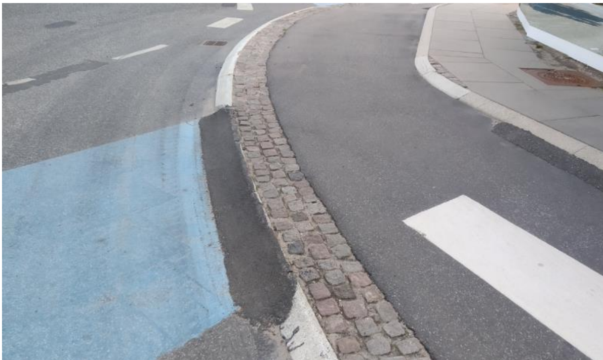
Fotografia 14. Zniwelowanie różnicy wysokości krawężnika do osi drogi poprzez małą wylewkę asfaltową (Billund, Dania). Źródło: Materiały Urzędu Marszałkowskiego Woj. Pomorskiego
