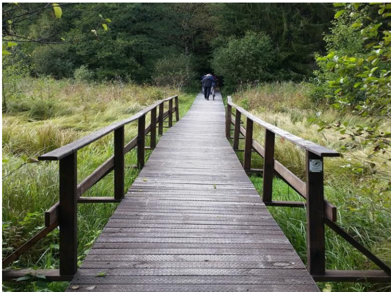
Fotografia 18. Kładka drewniana, uszorstniona siatką stalową o drobnych oczkach, Wigierski Park Narodowy.
