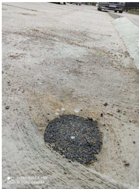
Fot. 6. Odtworzenie nawierzchni po zakończeniu badań.
