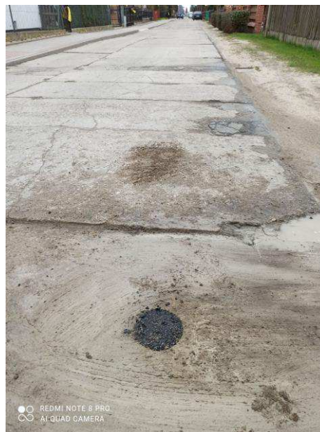
Fot. 2. Odtworzenie nawierzchni po zakończeniu badań.
