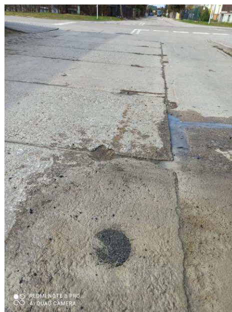
Fot. 4. Odtworzenie nawierzchni po zakończeniu badań.
