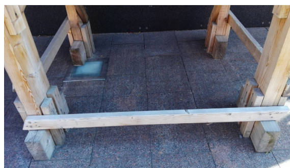
Pomost łączący taras nad pawilonem i schody do Muzeum. Sposób posadowienia schodów.
