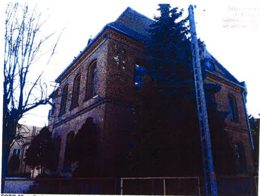
FOTO 05 - zdjęcie z zewnątrz elewacji północnej oraz wschodniej
