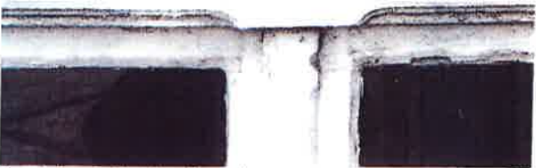
Oryginalne zdobienia i profilowanie śłemia pochodzące z budynku Klinik we Wrocławiu ok 1895r
