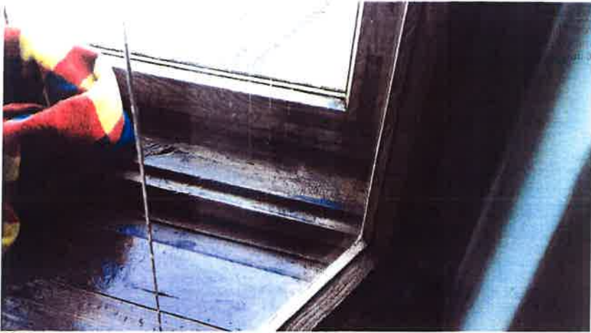
FOTO 13 - zdjęcie od wewnątrz okna skrzynkowego na parterze
