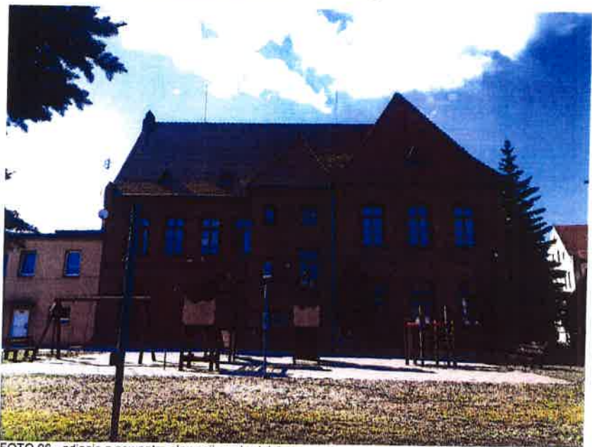
FOTO 06 - zdjęcie z zewnątrz elewacji wschodniej
