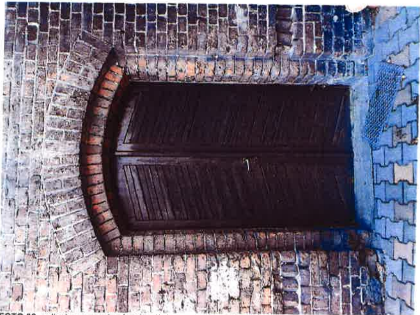
FOTO 08 - zdjęcie z zewnątrz drzwi wejściowych – elewacja wschodnia
