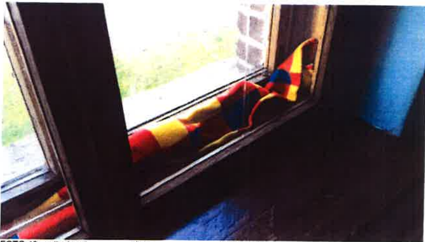
FOTO 12 - zdjęcie od wewnątrz okna skrzynkowego na parterze
