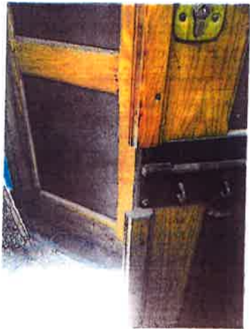
Konstrukcja ramowa wypełniona pilśnią
