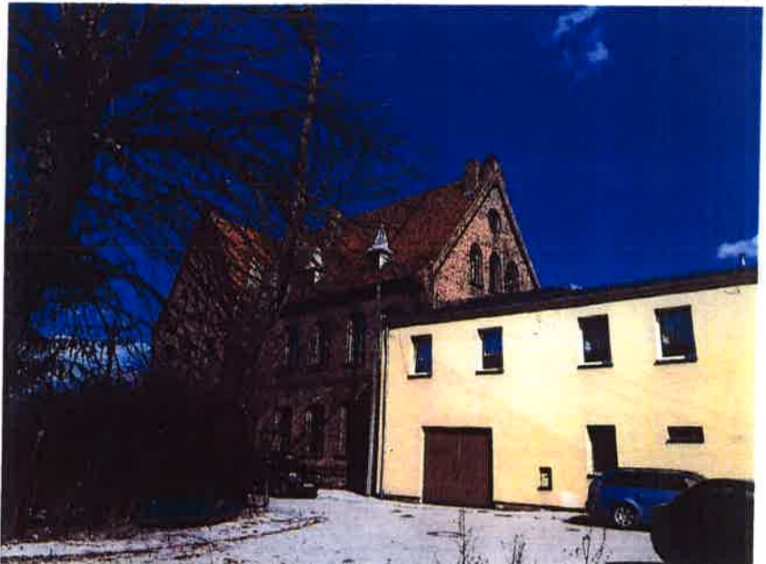
FOTO 01 – zdjęcie z zewnątrz elewacji zachodniej - frontowej oraz południowej
