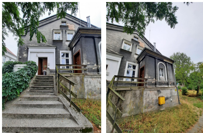
↑ Fot. 6, 7. Elewacja boczna (północno-wschodnia)
