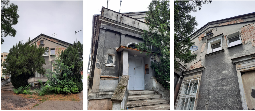
↑ Fot. 3, 4, 5. Elewacja boczna (południowo-zachodnia)
