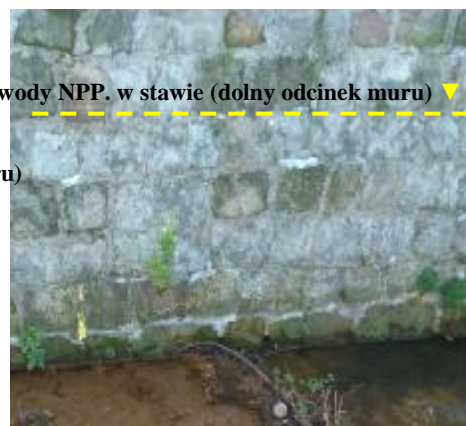
Zdj. 13,14. Porost roślin w spoinowaniach muru wyremontowanego w 2018r.
