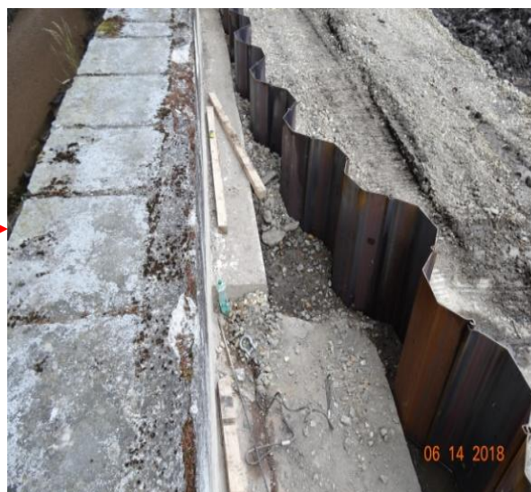
Zdj. 7. Ścianka przy zmianie szerokości oczepu
