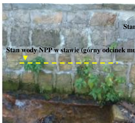
Zdj. 13,14. Porost roślin w spoinowaniach muru wyremontowanego w 2018r.
