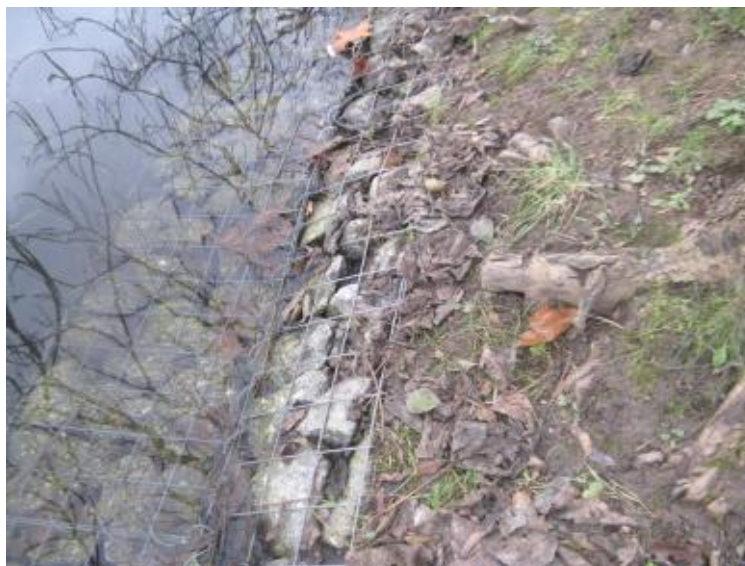
Zdj. 18. Odsłonięte materace kamienno - siatkowe wymagające przykrycia gruntem
