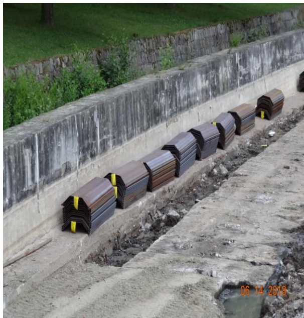
Zdj. 3. Przygotowane 126 ścianek szczelnych o długości 2,0 m do wbicia w grunt
