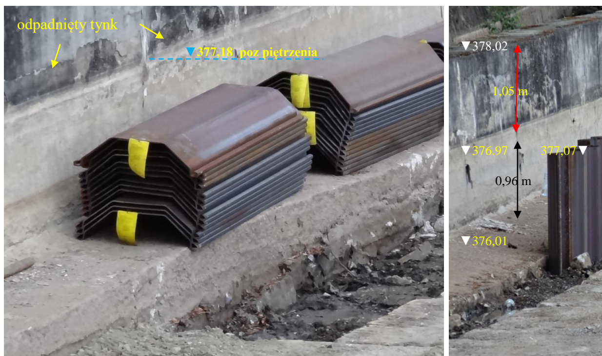
Zdj. 5 a, b. Stan starego oczepu muru przed remontem muru w 2018r.
