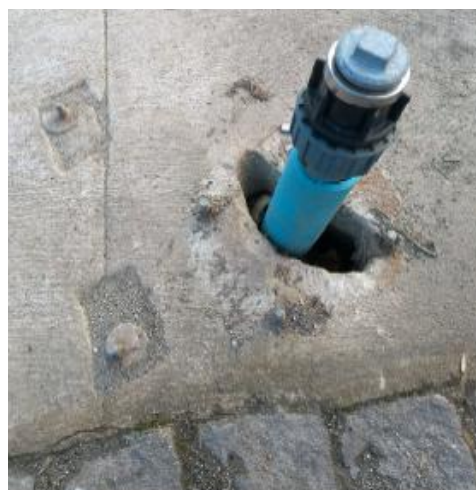
Zdj. 22. Niedbale obudowany przewód wodny
