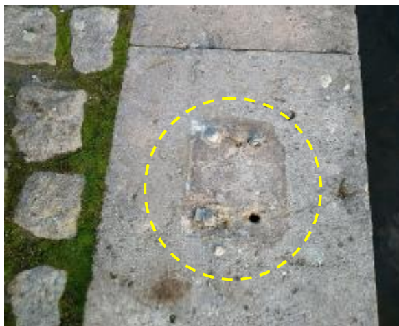
Zdj. 21. Urwane mocowanie urządzenia edukacyjnego
