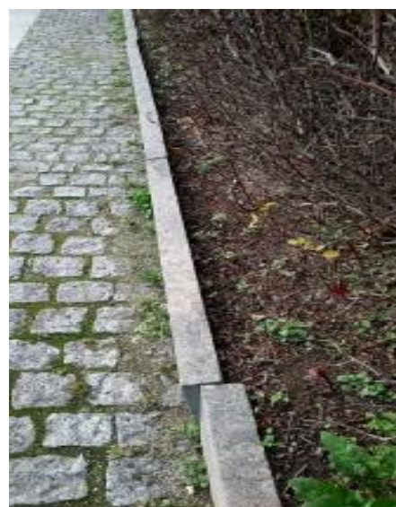
Zdj. 20. Przemieszczone krawężniki
