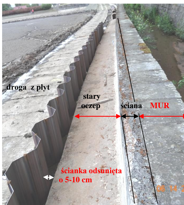
Zdj. 6. Oddalenie ścianki szczelnej od oczepu
