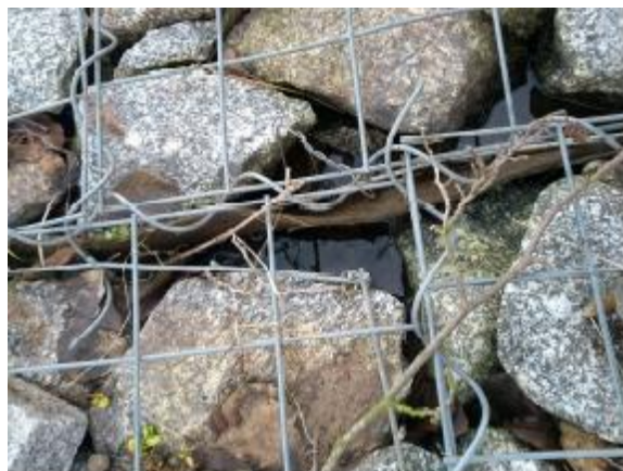
Zdj. 17. Nierówno ułożony kamień i pustki Geowłókna narażona na promienie UV
