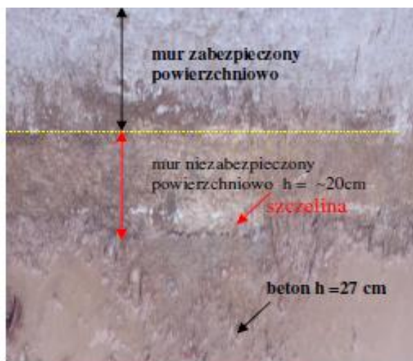
Zdj. 8. Stan ściany nad betonowym oczepem
