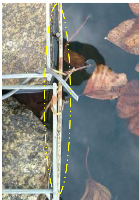
Zdj 18. Początki korozji drutu gabionów po 15 miesiącach eksploatacji
