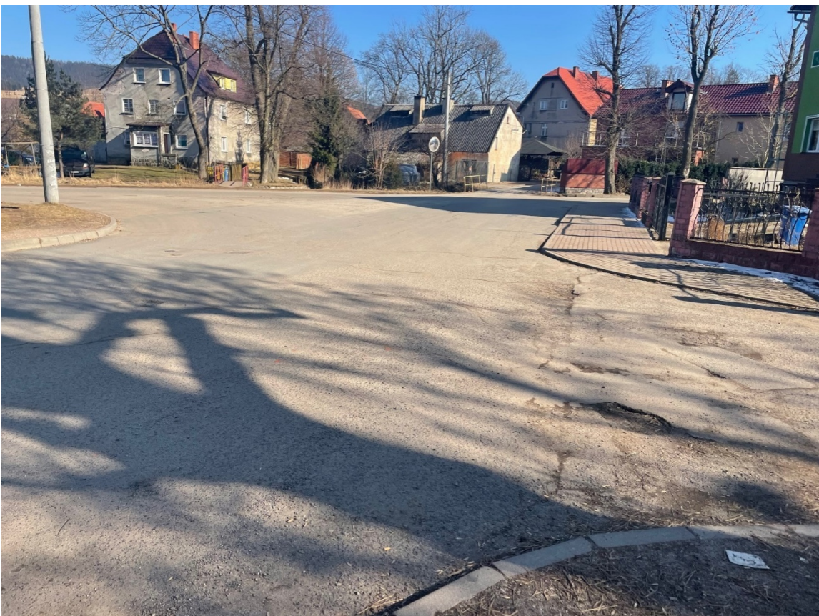
Fotografia 16 Widok na skrzyżowania ulicy Kolonia z ulicą Polną
