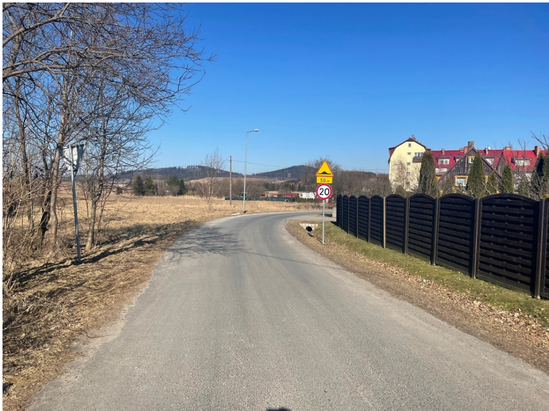
Fotografia 2 Widok na stan jezdni ul. Kolonia od strony ul. Lubawskiej
