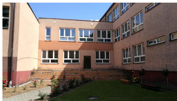
Fot.2 Fragment elewacji południowej
