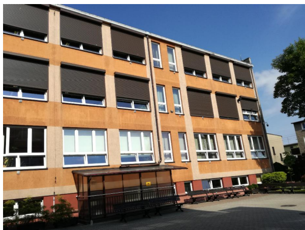
Fot.3 Fragment elewacji wschodniej
