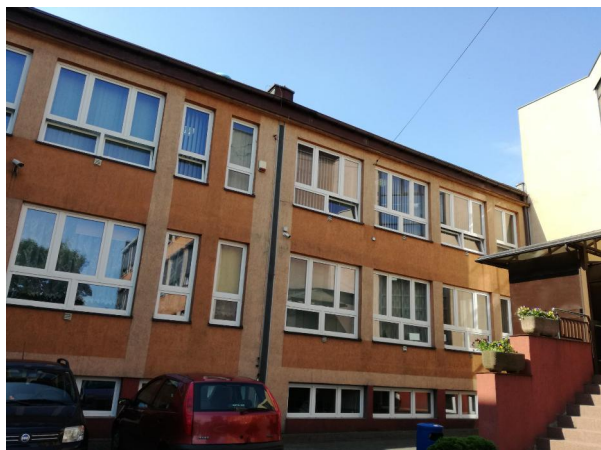
Fot.5 Fragment elewacji północnej
