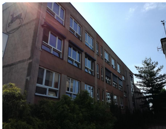
Fot.4 Fragment elewacji zachodniej
