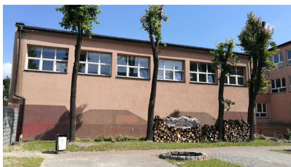
Fot.1 Fragment elewacji południowej
